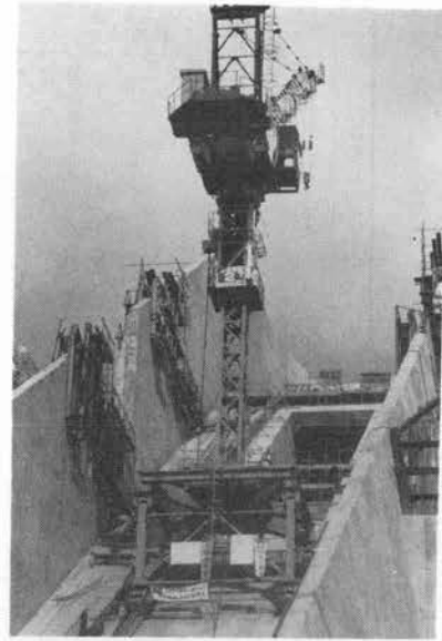
写真-2 傾斜移動式クライミングクレーン
