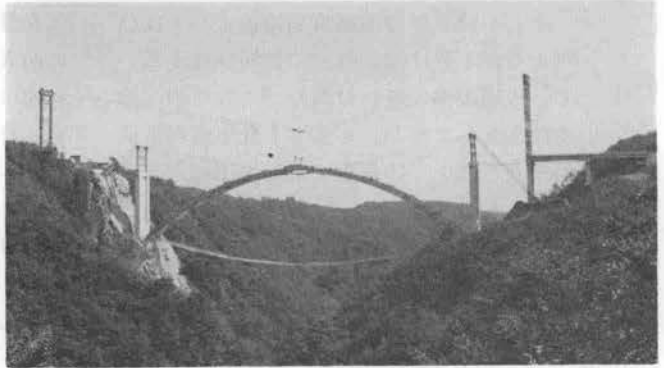
写真-4 アーチ架設(閉合)
