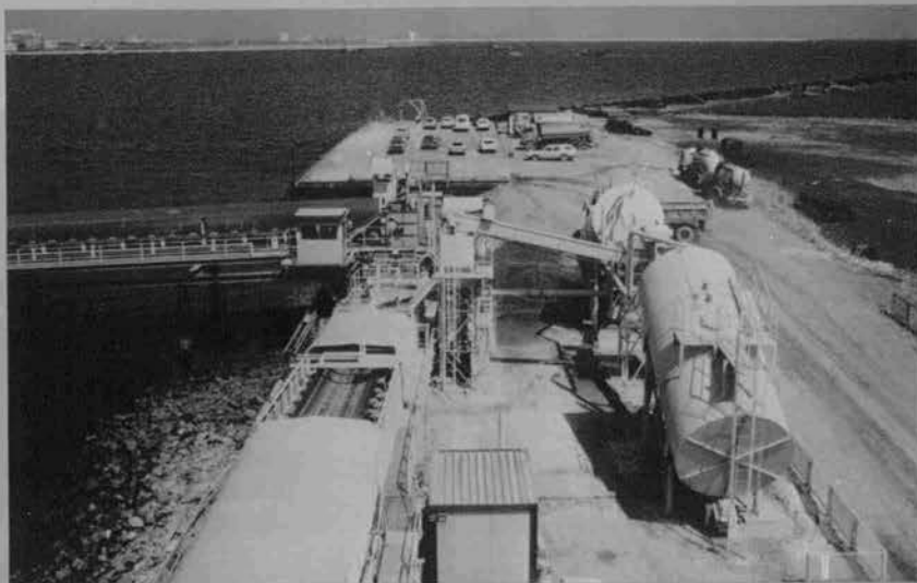
⊕生石灰自動添加装置
