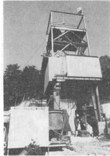
写真-3 坑外仮設備 (やぐら)
