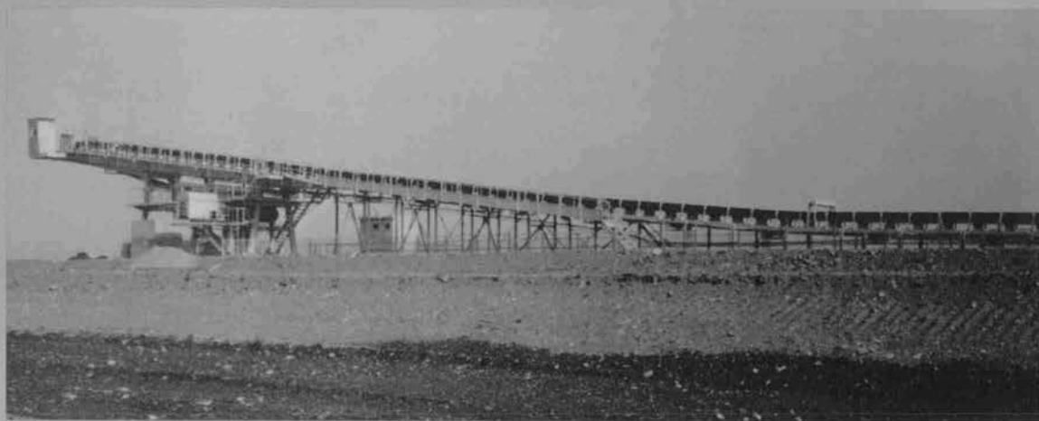
◆アンカー杭を用いない移動用コンベヤ (No.3')
