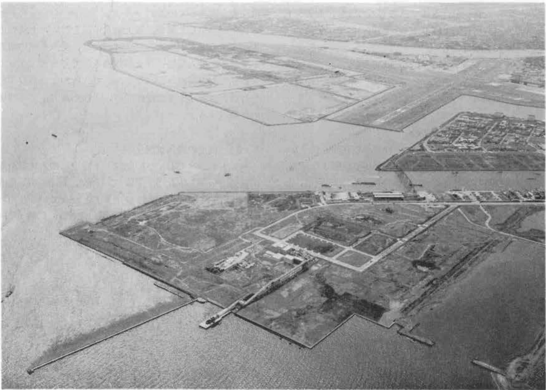
写真一 受入基地と羽田沖廃棄物処理場
