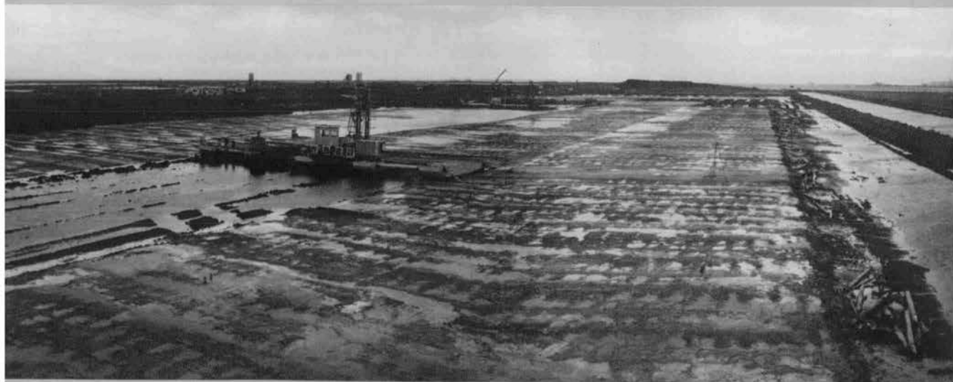
◆表層固化処理工事状況 (左上は処理船)
