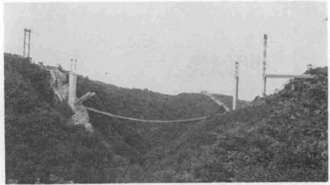
写真-3 アーチ架設(初期)
