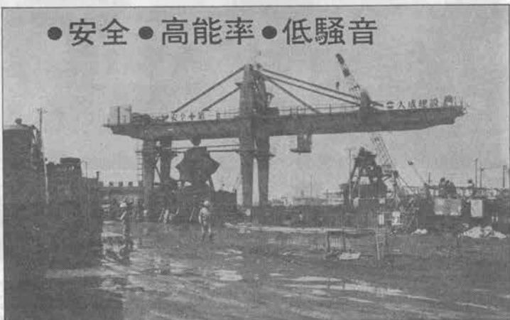
YBM-110型 バケット8M 3 能力1000馬力(地下25Mより)
