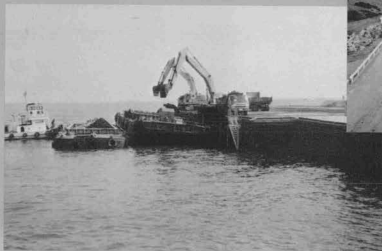
◆表層固化処理工事状況 (左上は処理船)
