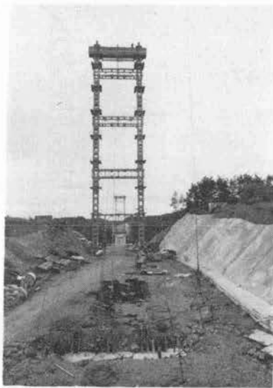
写真-1 架設設備 (ケーブルタワー)
