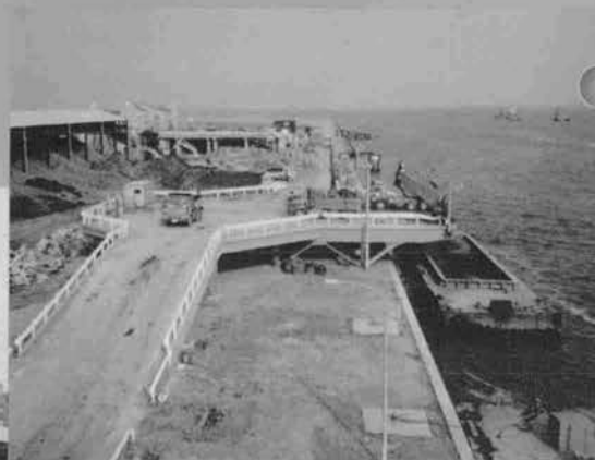
◆バージ積込デッキ
