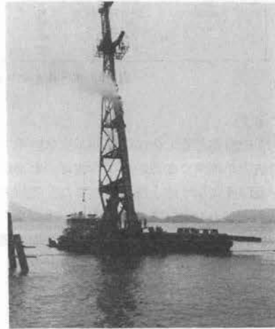
写真-4 杭打船による施工
