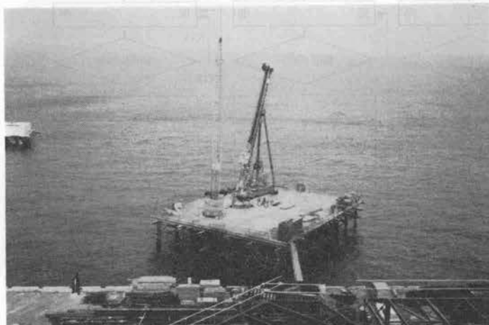
写真—5 仮設棧橋による杭打ち施工
