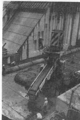
写真-4 コンクリート1層目上を走行のスプレッドコンベヤ
