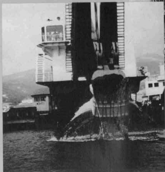
◆ 6 m 3 バケット船による海底浚渫
