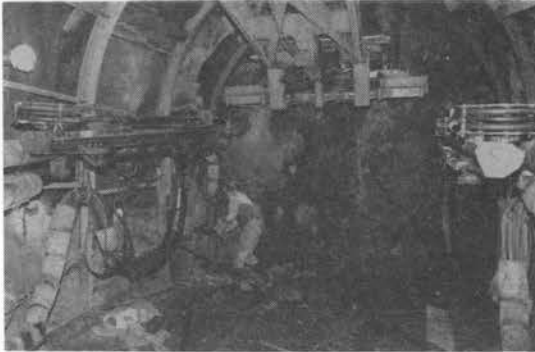
写真-2 ドリルジャンボによるトンネル施工状況
