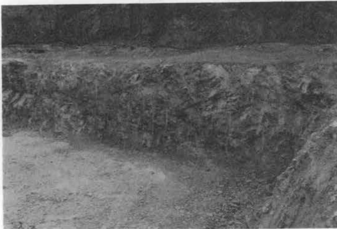
写真-7 高ベンチカット工法による掘削後 (H=5m)
