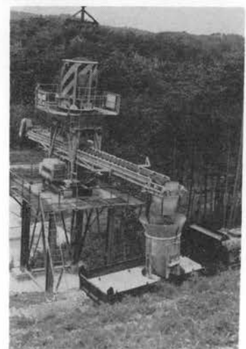
写真-5 中間ホップとしてのスプレッドコンベヤ利用
