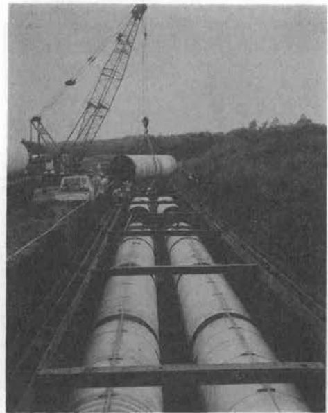
写真-1 送水管施工状況
