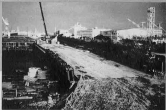
⇨ 函体積装ヤードの仮設棧橋
