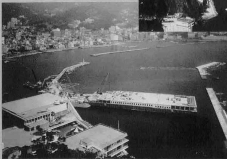
◆函体の沈設完了 建築工事中
