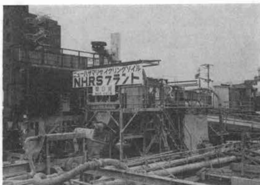
写真-2 2号機プラント全景
