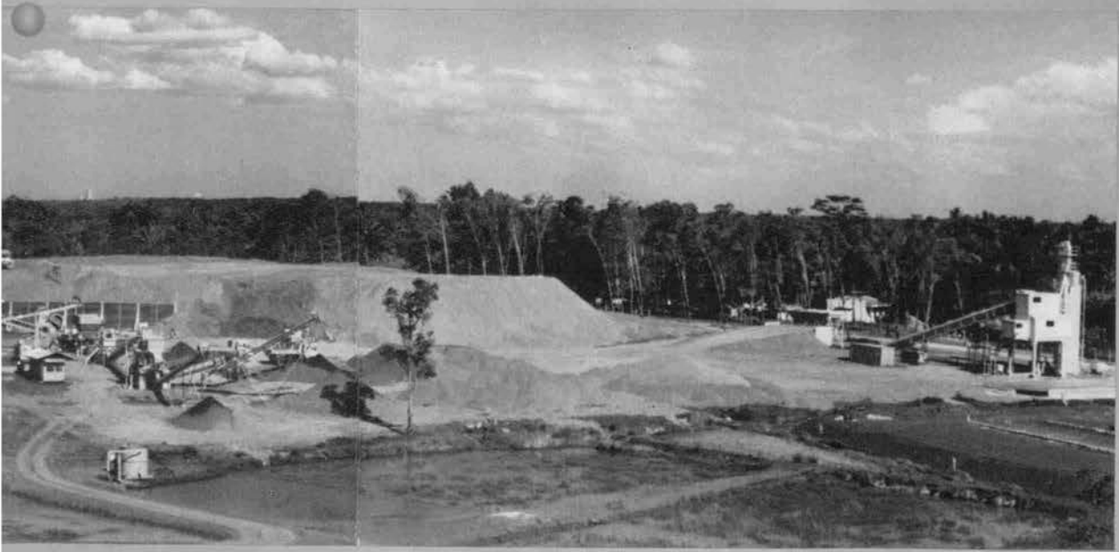
②プラントヤード全景（仮設直後）
