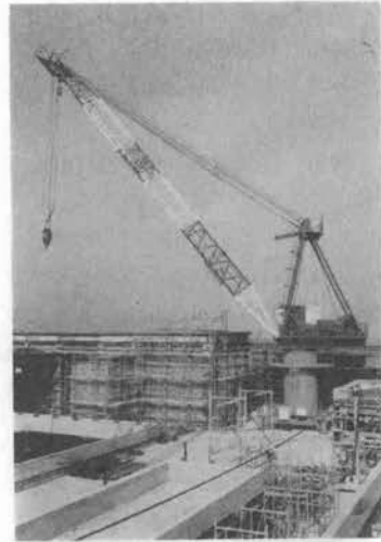
写真-3 ジブクレーン 150 t-m
