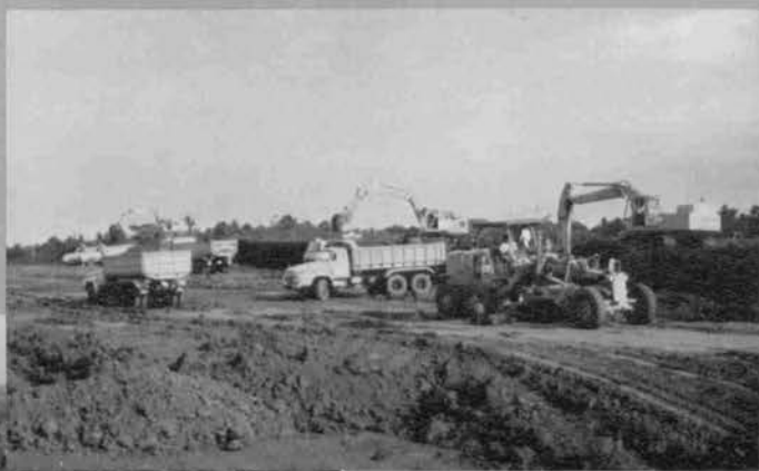
◆本線上の切盛土工 (土質はラテライト)
