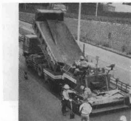
写真-49 ハイコンバクションスクリード付アスファルトフィニッシャー
