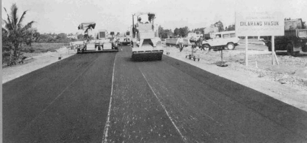
◆アスファルト舗設工 (アスファルトフィニッシャ 2 台による全幅施工)
