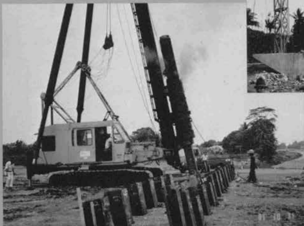
⇨ オーバーブリッジ用基礎斜杭の打込み
