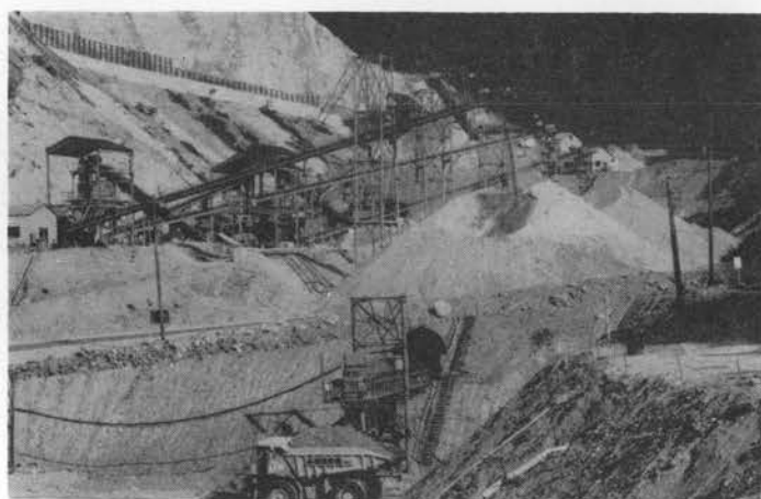
写真-2 フィルタプラント設備
