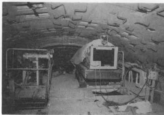
写真-2 シールドマシンに固定されたレーザーターゲット
