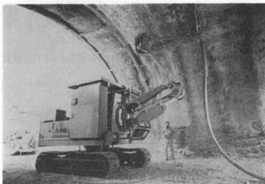
写真-20 プレイバック式コンクリート吹付ロボット
