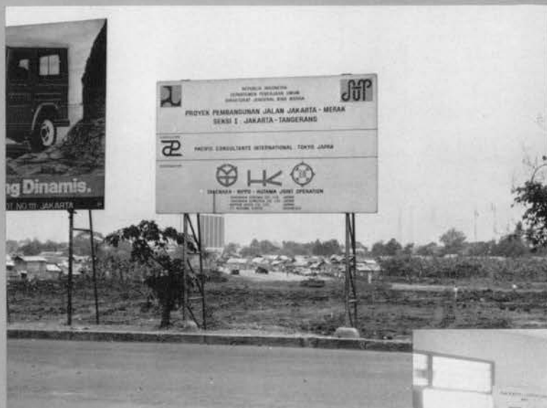
◇ジャカルタ側工事始点に立てられた工事標識
