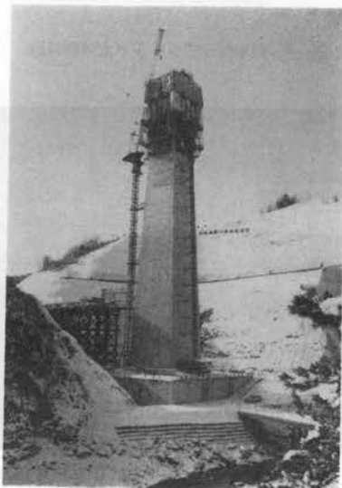
写真-37 高橋脚施工用ジャンピングフォーム
