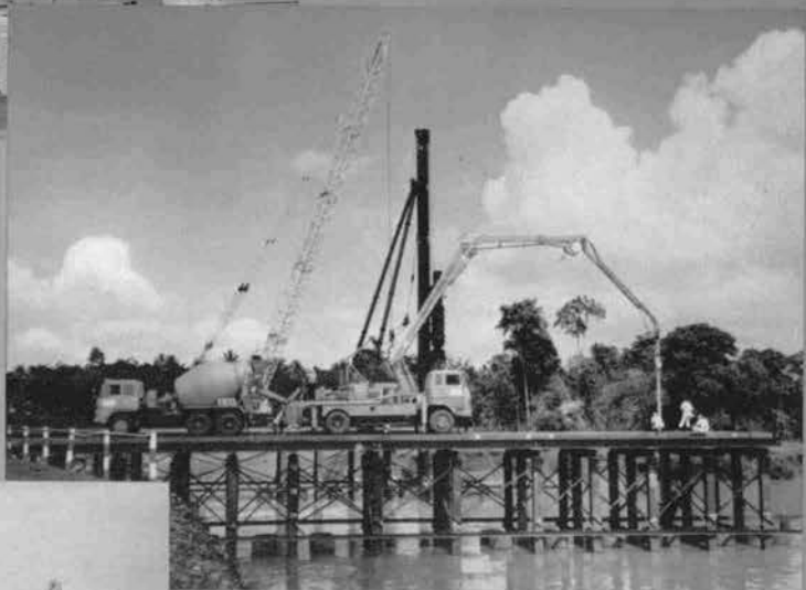
④チサダネ川橋基礎杭の中詰コンクリート打設
