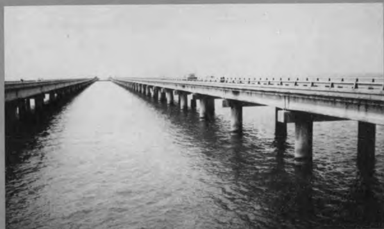
♣ ポンチャクレイン湖に架かる長さ 40 km のコースウェイ橋 (ルイジアナ州ニューオーリンズ)
