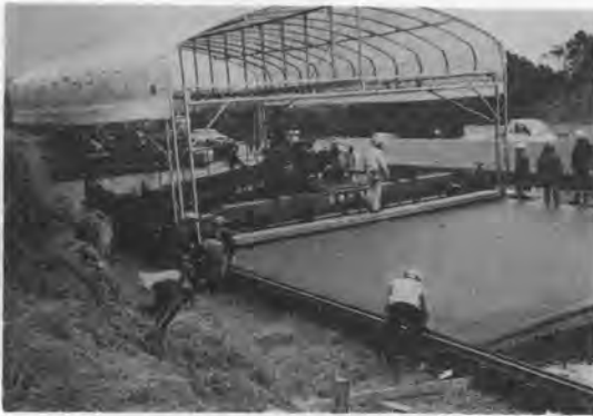
写真-8 斜仕上げ機施工状況
