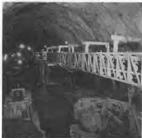
写真-3 トレーンローダによるずり出し(長峰トンネル)
