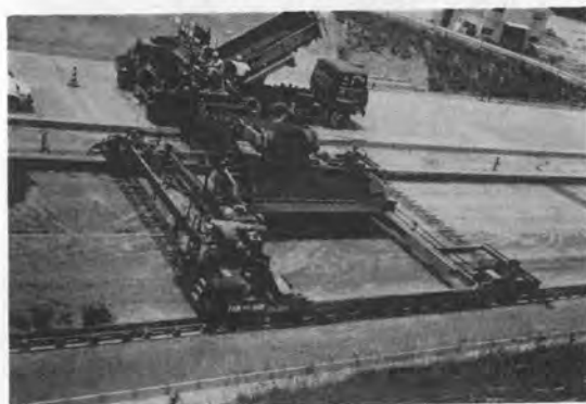
写真-4 横取り状況
