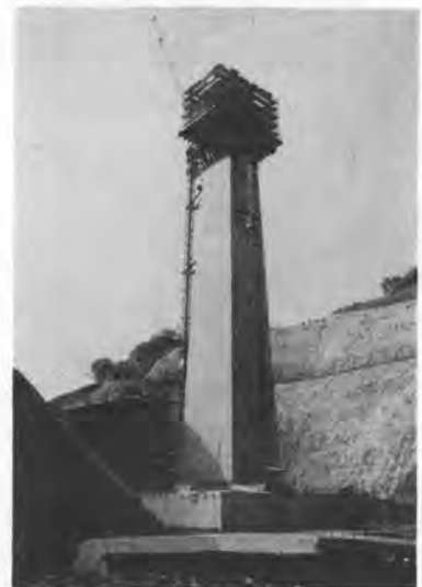
写真-5 P 2 橋脚完成
