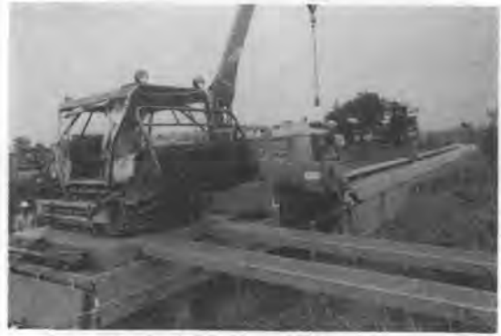
写真-2 のり面への搬出入
