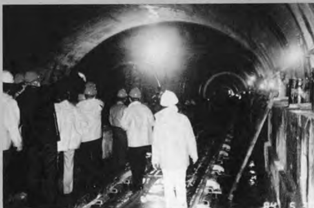
⇨ レール敷設中の地下鉄工事 (ニューヨーク市)
