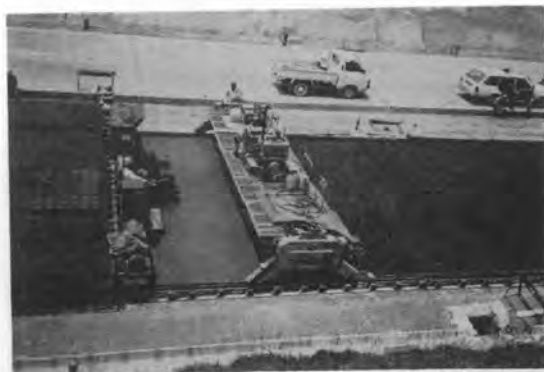
写真-5 下層フィニッシュ施工状況
