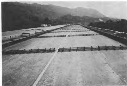
写真-2 型枠，バーアセンブリ設置状況
