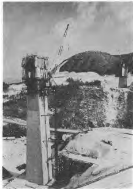
写真-1 阿木川ダム2号橋工事状況
