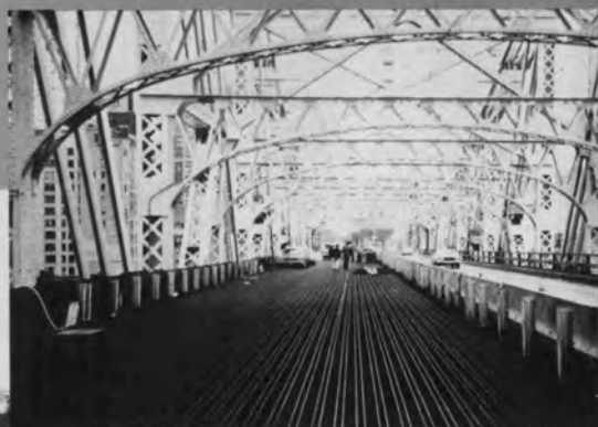
♣ 上部デッキ橋床修理中の クインズボロー橋
