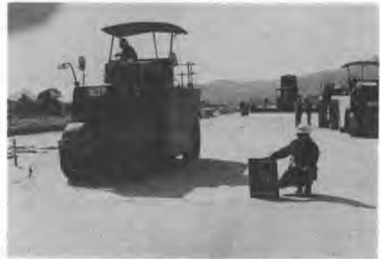
写真-1 路盤施工状況
