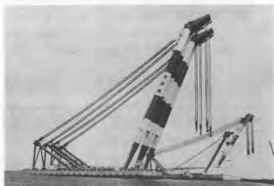
写真-15 住友ジブ俯仰式起重機船 (第50吉田号)
