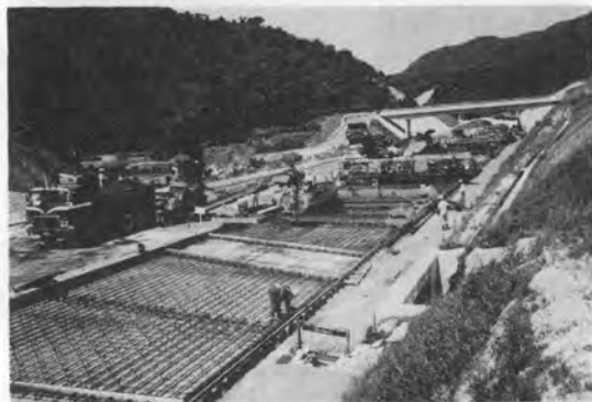
写真-3 舗設状況全景
