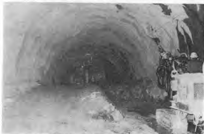
写真-1 NATM の施工状況 (藤白トンネル、2 段ショートベンチ下半片側斜路)
