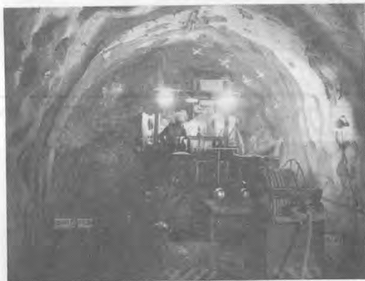
東京電力株蛇尾川揚水発電所 工事用トンネル(佐藤工業株殿施工) で使用中の油圧2ブームホイールジ ャンボ MAXIMATIC H207B
