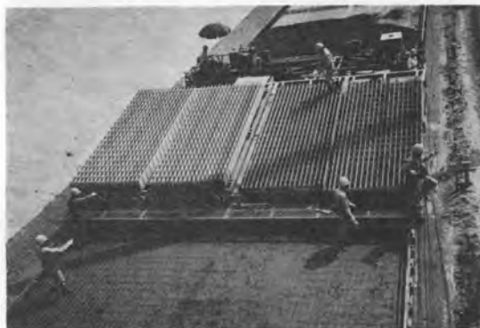
写真-6 メッシュカート施工状況
