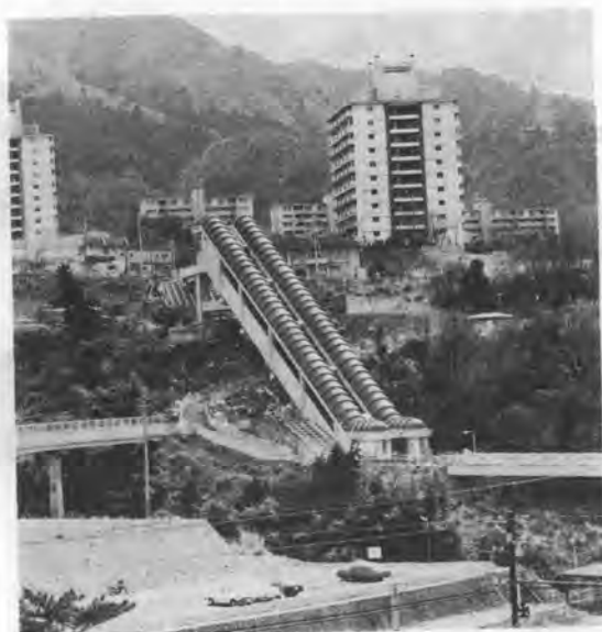
写真-1 斜行エレベータ
