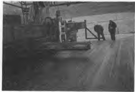
写真-9 タイングルーバ施工状況
