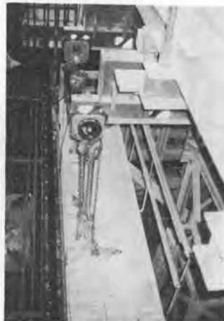
写真-4 内型枠セット中
