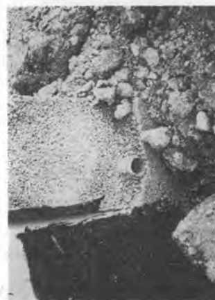
写真-3 ウォール・ドレーン
