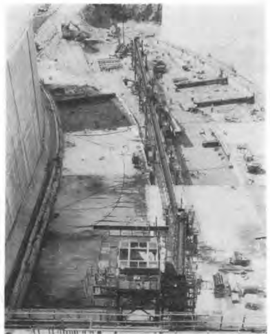
写真-1 BCP 工法による打設状況
