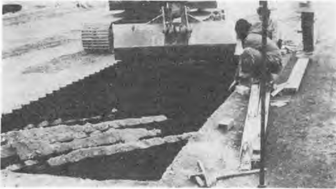
写真-1 ジオウェブの設置
