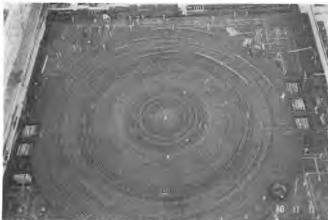
写真—1 原子力発電所基礎の配筋例
