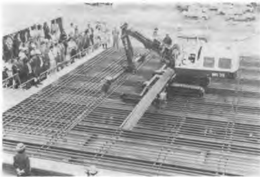
写真-6 公開実験時の配筋状態
