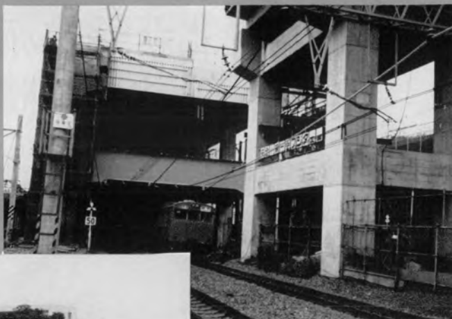
赤羽駅高架橋⇨
