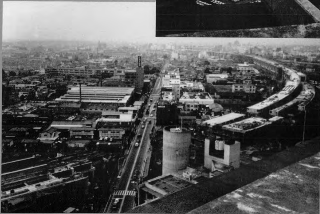
◇ 与野市内高架橋 (東京方より大宮方を望む)
