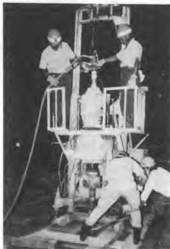
写真-2 DHC-3B 型による注入
