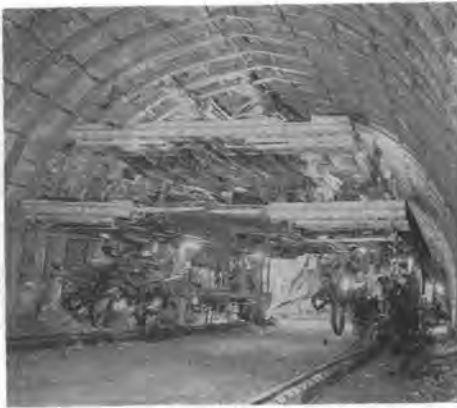
写真-2 全油圧9ブームガントリージャンボ
