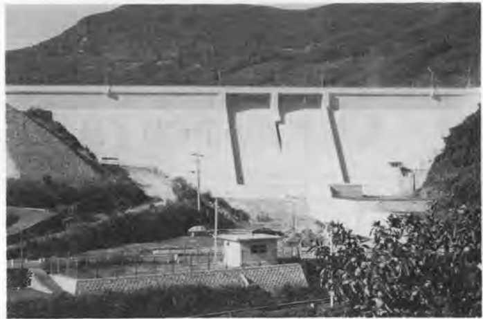
写真-1 完成した長与ダム
