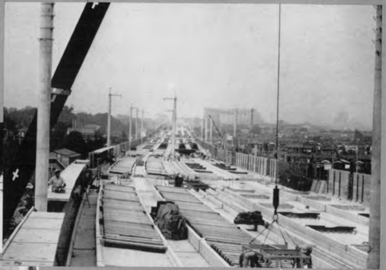
◇ 浦和市内高架橋工事
