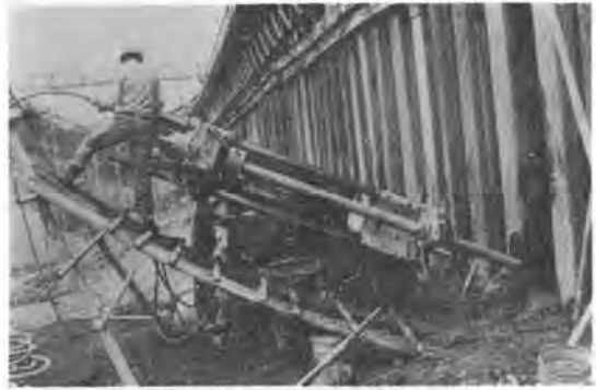
写真-2 パワースイベル型ボーリングマシン TOP-S
