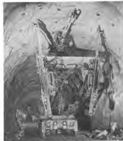
写真-3 ロックボルト用クローラジャンボ
