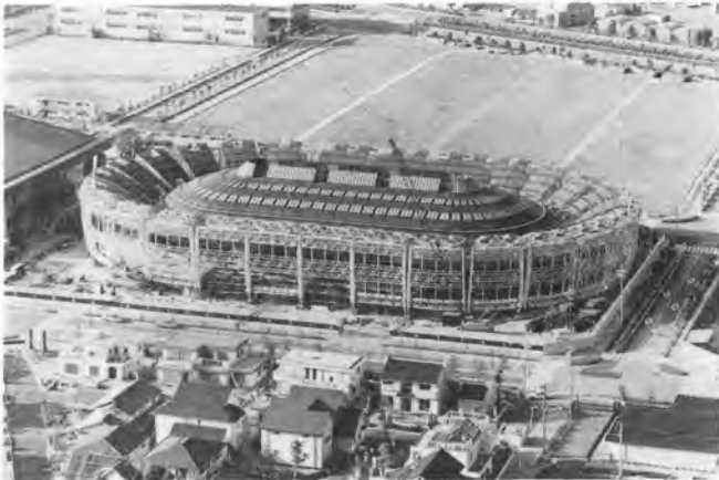
写真-1 プッシュアップ前の現場
