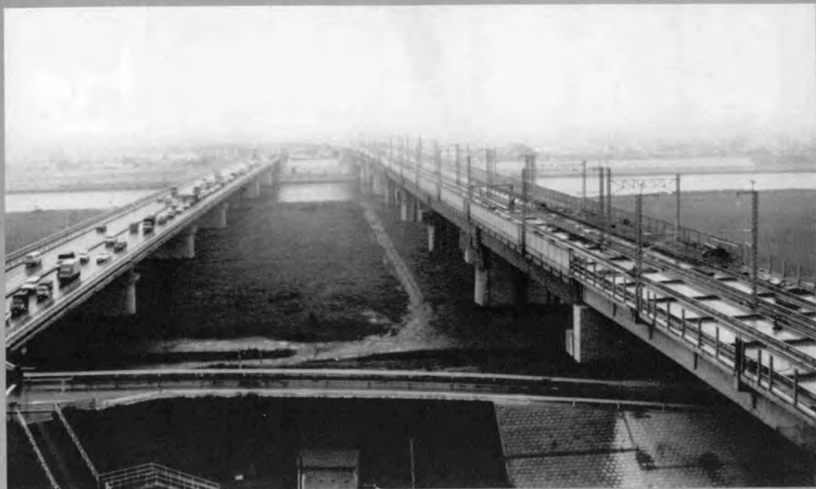
◆ 荒川橋りょう
