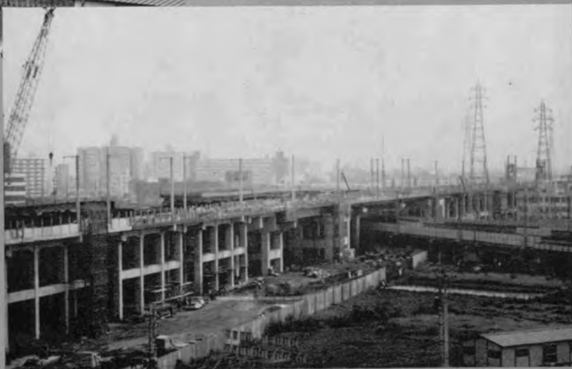
◆ 武蔵野線跨線橋
