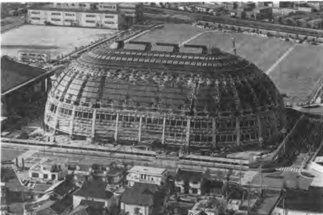
写真-2 プッシュアップ後の現場
