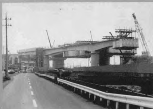
◆ 中川橋りょう (戸田市)
