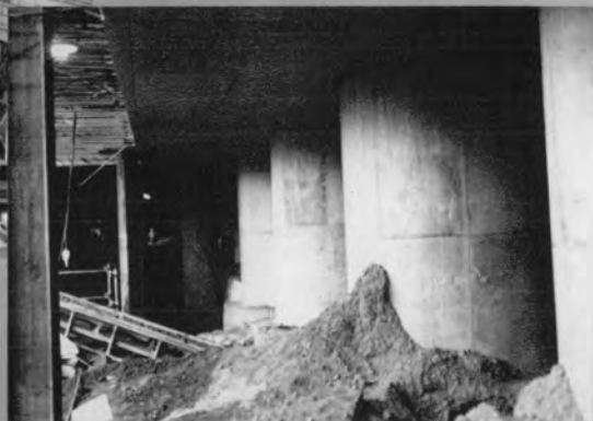
⇨赤羽台トンネルの アンダーピニング
