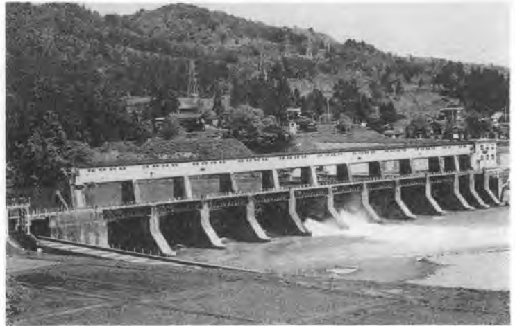
写真-1 既設宮中取水口ダム
