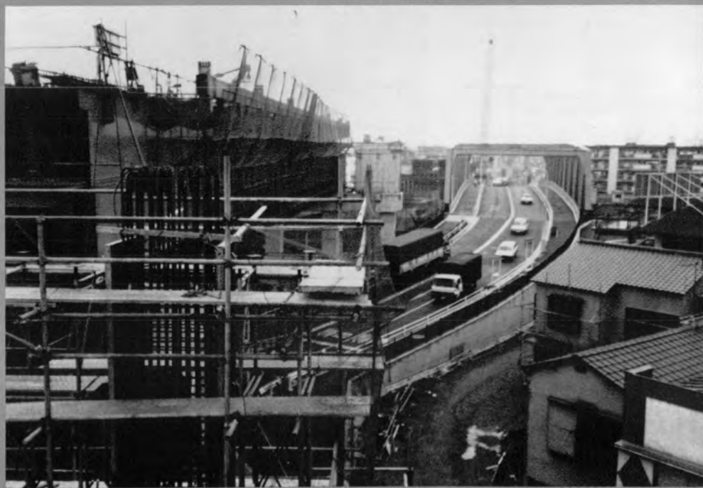
⇨新河岸川橋りょう (北区)
