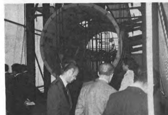
セグメントリング載荷試験
