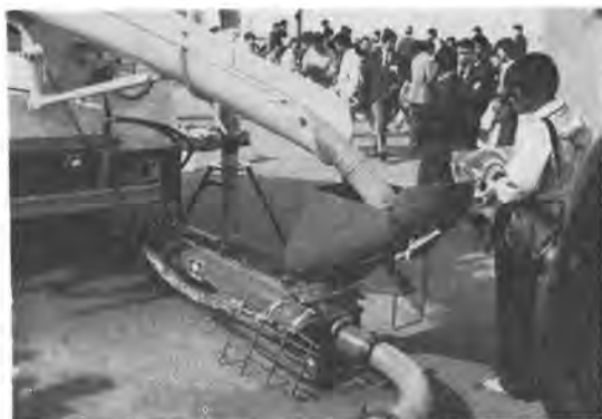
写真一 小型コンクリートポンプ装備のトラックミキサ
