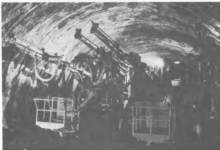
日本道路公団・北陸自動車道市振トンネル上り線(佐藤工業株殿施工)で使用中の油圧2ブームホイールジャンボ MAXIMATIC H207B
