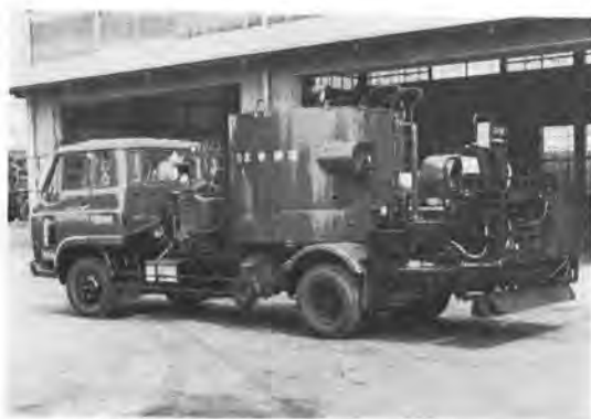
写真-4 3tアスファルトディストリビュータ (伸縮自在スプレイバー付)
