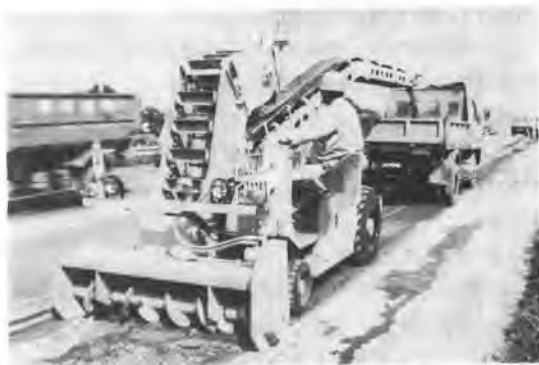
写真-2 路面切削機（酒井重工業 FL-50）
