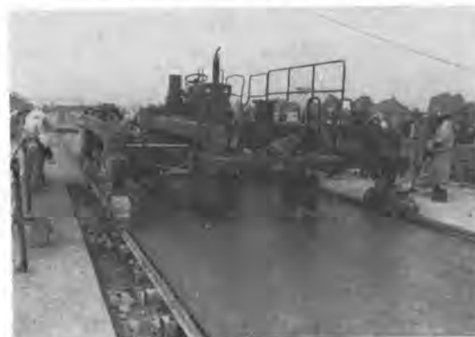
写真—2 移動用車輪を装着したレベリングフィニッシャ
