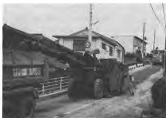
写真-3 アンダーカットスクレーバによる路床土のすき取り
