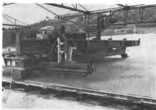
写真-3 高速道路工事に使用された タイングルーピングマシン
