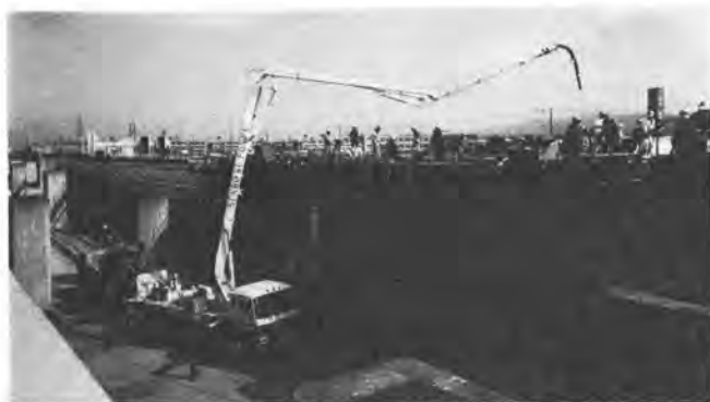
写真-3 石川島播磨製 IPF 100 B 6 N 27 コンクリートポンプ車
