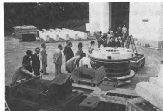
沈埋トンネル可撓性継手実験
