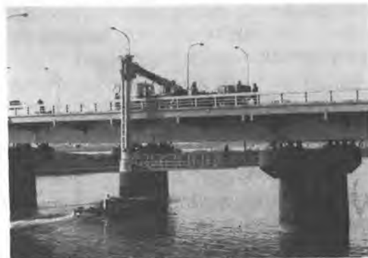
写真—6 橋梁点検車（歩廊式、建設省関東技術）
