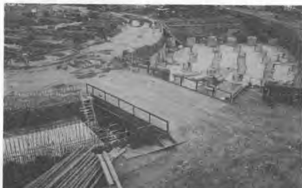
写真-4 ランプ部の場所打ち杭施工状況
