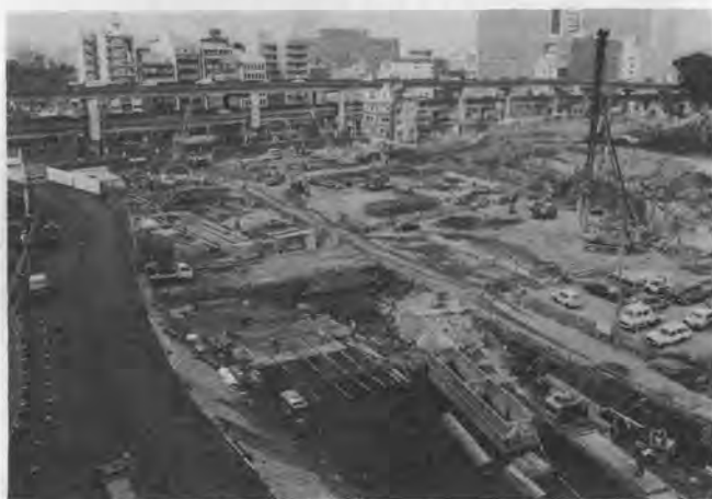
写真-4 計画区道の造成（左端）と既存区道（中央）
