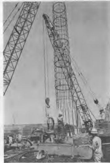
写真-3 鉄筋かご建込状況
