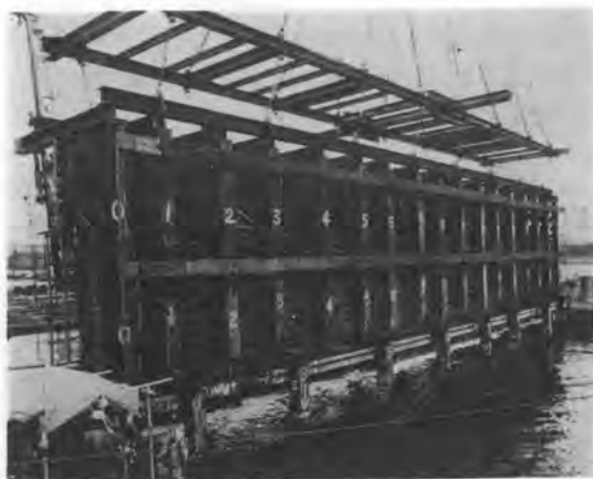
写真-5 鋼製型枠の設置
