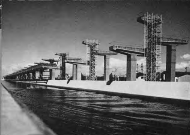
⇨ 高速道路の橋脚と高潮対策護岸工事
