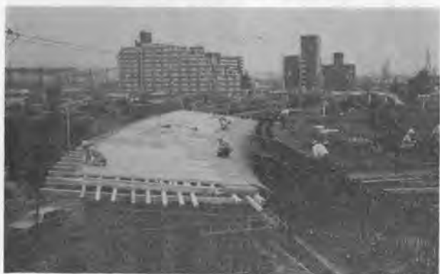
写真-5 張出し床版型枠施工状況（ハンチ部分にゴム型枠を張付けてある）
