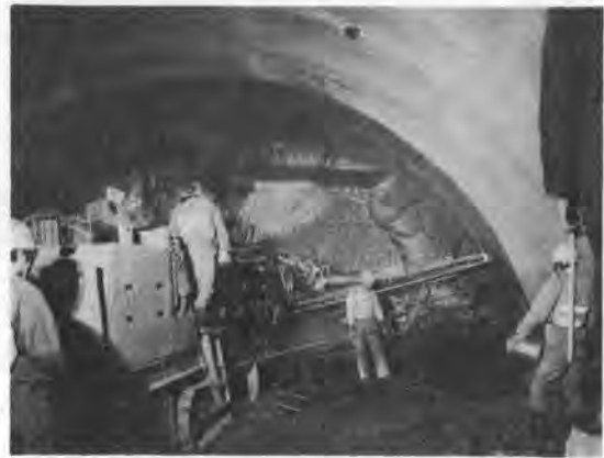
写真-4 ロックボルトせん孔状況
