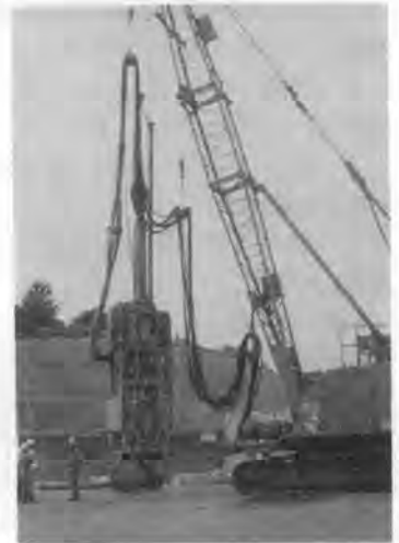
写真-2 ミニハイドロフリーズと 50 t 級クローラクレーン
