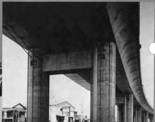
⇨⇨ 9径間連続PC箱桁と 施工中の移動つり支保工
