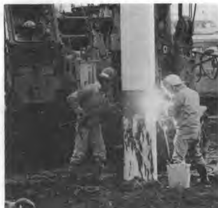
写真-6 足場の例
