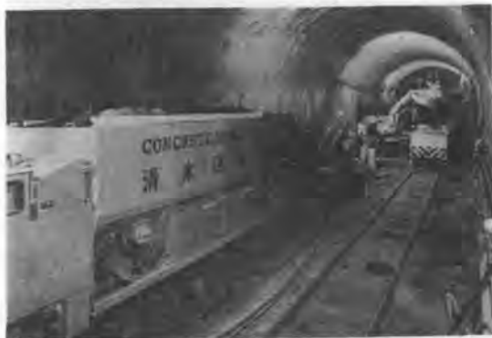
写真-1 坑内作業状況
