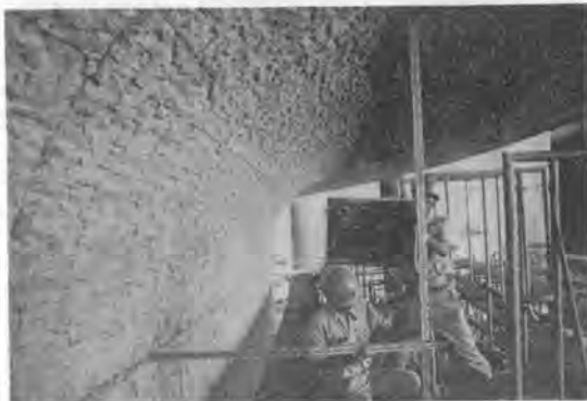
写真-6 外壁面の状況
