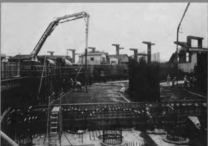
ポンプによるコンクリート打設状況 (加平ランプ付近)
