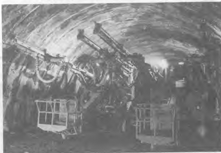
日本道路公団・北陸自動車道市振ト ンネル上り線(佐藤工業株式会社施 工)で使用中の油圧2ブームホイールジ ャンボ MAXIMATIC H207B
