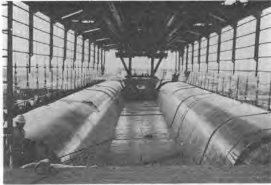
写真-7 型枠組立状況
