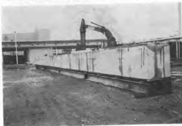
写真-1 流動距離 20 m の強度低下実験のコンクリート供試体
