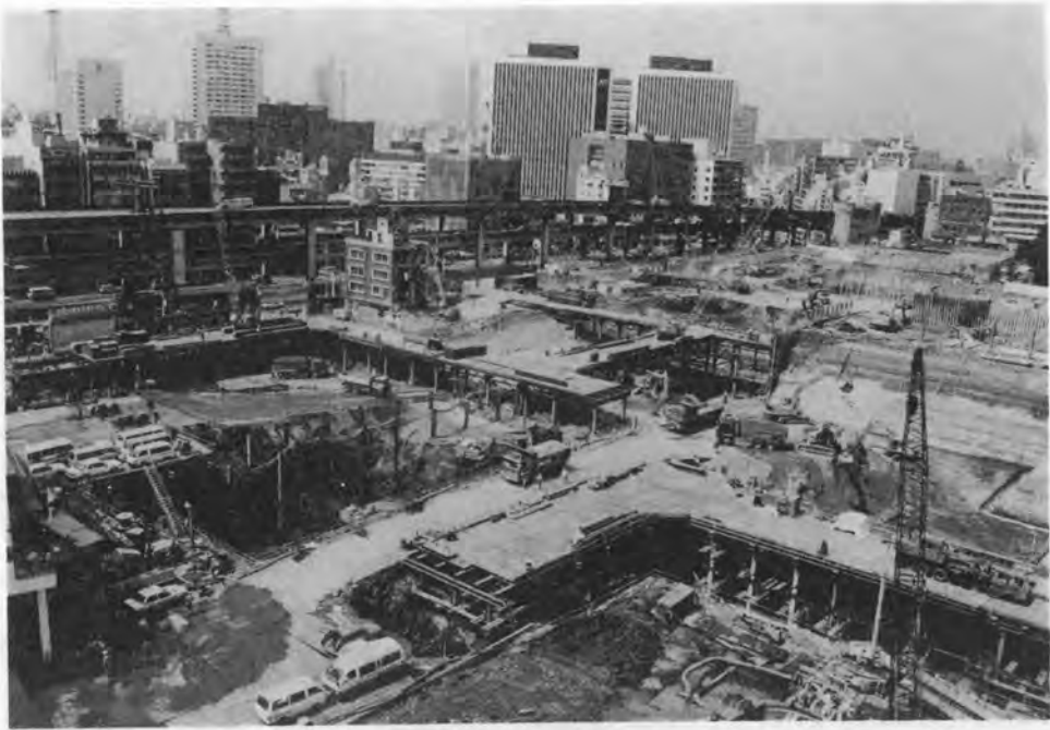
写真-7 土工事状況
