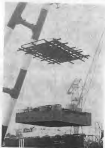
写真-4 大組鋼製型枠の曳航
