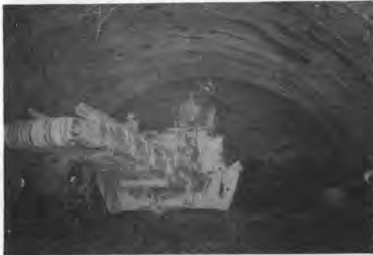
写真-1 ロードヘッダによる掘削
