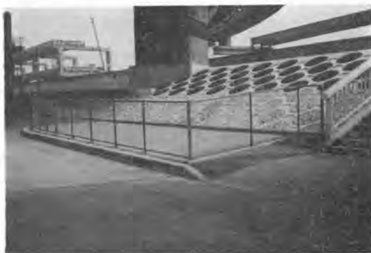
写真-1 高潮対策護岸の背面盛土状況
