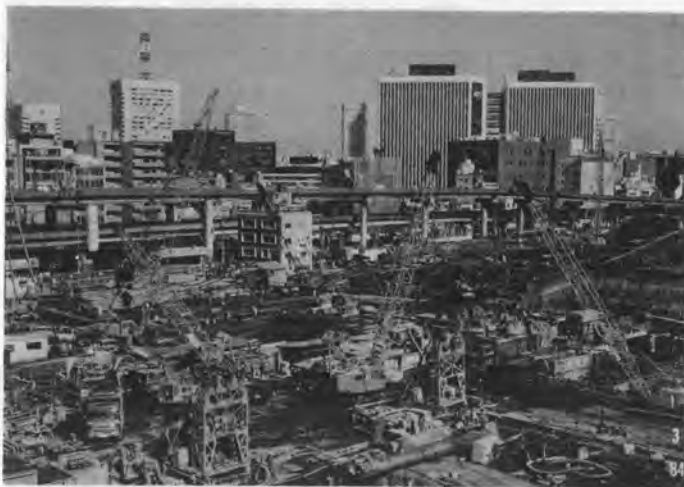
写真-5 地中連続壁工事
