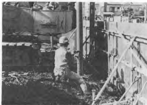
写真-5 掘削ロッドの引抜き
