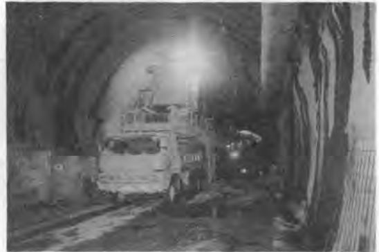
写真-3 トレンローダによるずり出し
