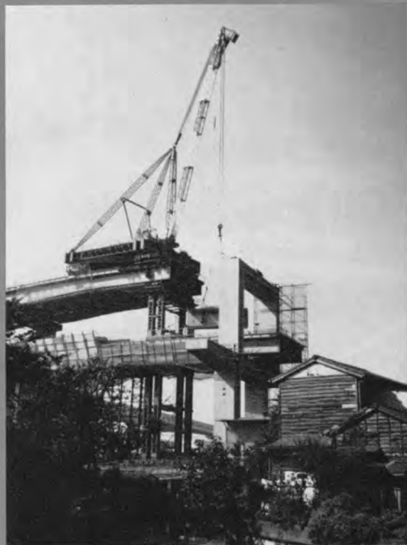
⇨ トラベラクレーンによる架設 (小菅インターチェンジ)
