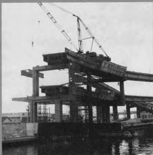
⇨ トラベラクレーンによる架設 (小菅インターチェンジ)
