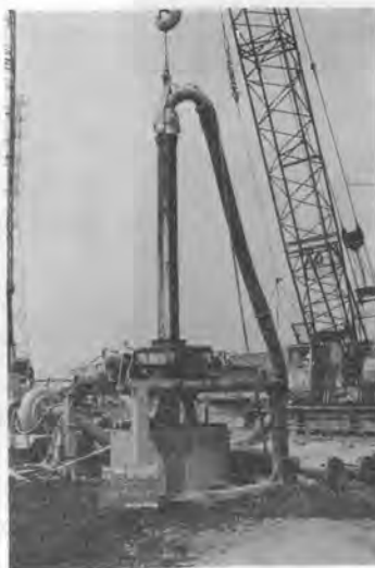
写真-2 リバース杭の掘削状況
