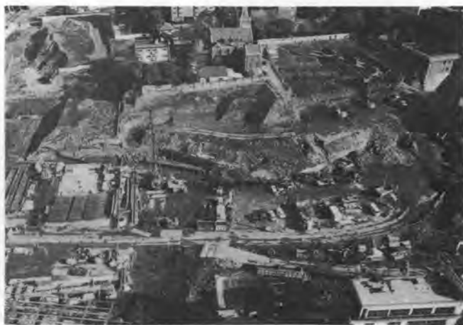
写真-3 造成工事状況
