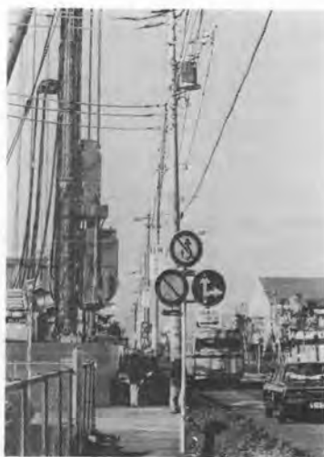
写真-4 隣接工事の例
