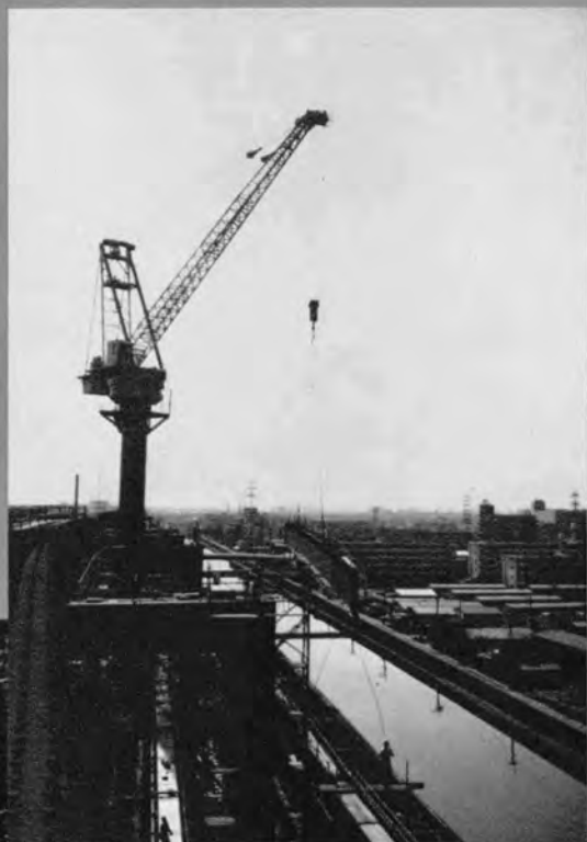
⇨ タワークレーンによる架設
