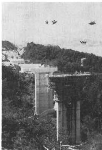
写真-4 コンクリートバケットによる打設
