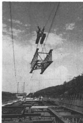
写真-5 上部桁架設
