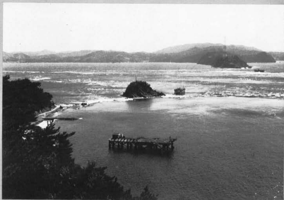
◆昭和51年5月起工前の鳴門海峡
