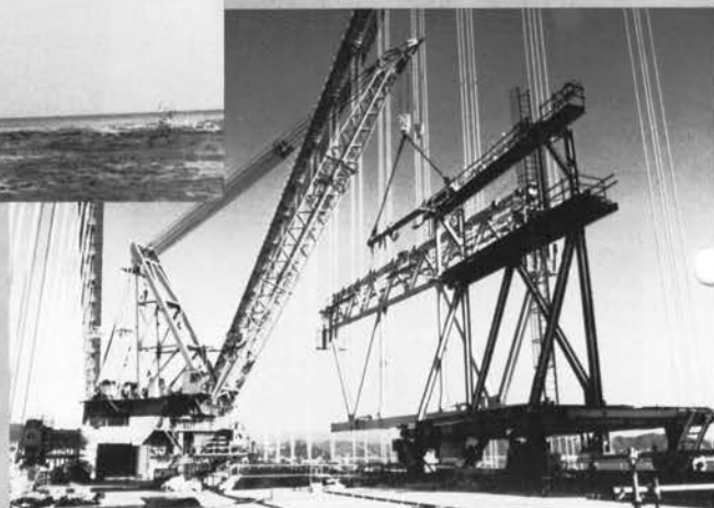
運搬台車から水切中の トラベラクレーン作業状況◆
