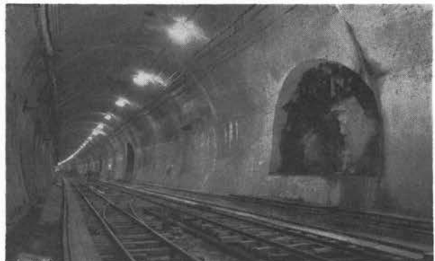
写真-3 切削後、取りこわし完了状況
