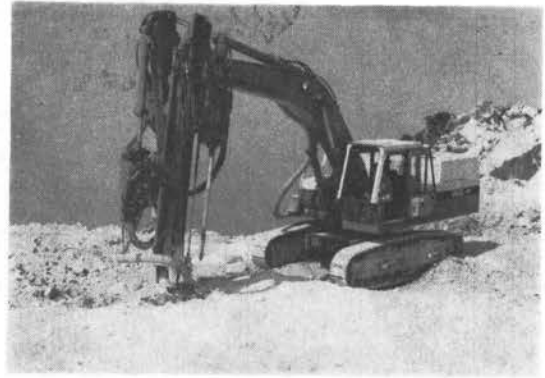
写真-1 施工中のパワースプリッタ
