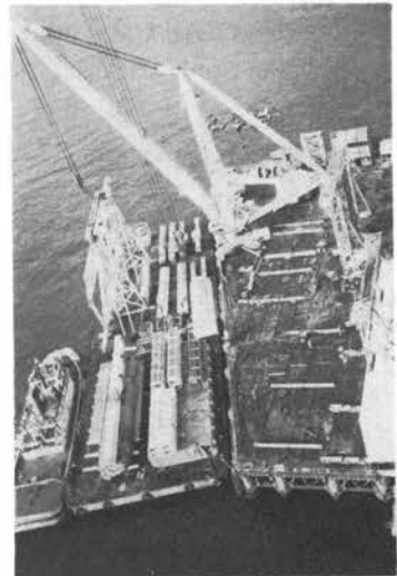
写真-1 水切クレーンによる水切作業状況
