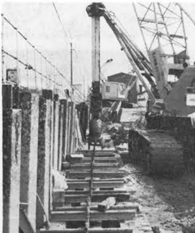
写真-1 RC パネル仮土留壁施工中
