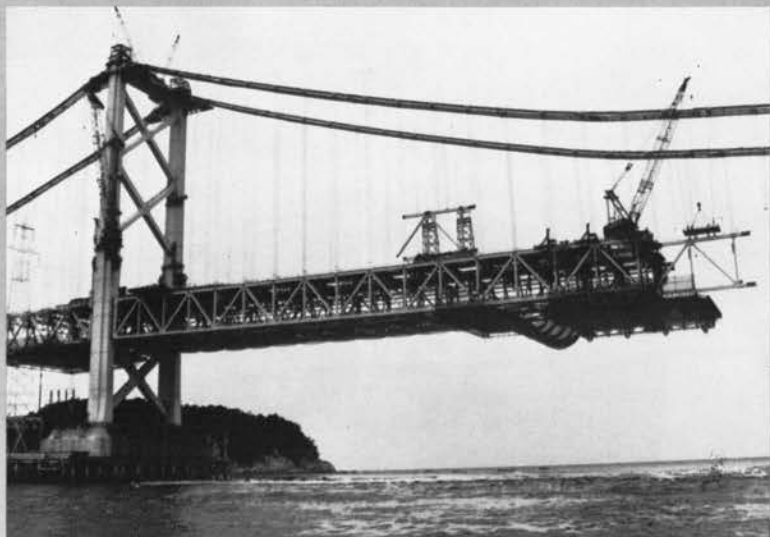
◆補剛桁の架設（無ヒンジ面材架設工法）
