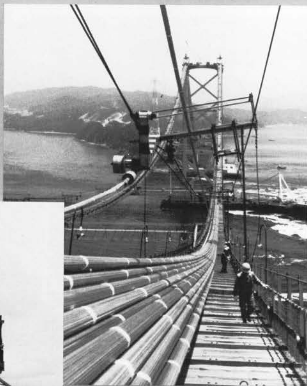
◆ケーブルストランドの架設状況
