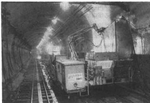
写真-1 切削作業中の状況
