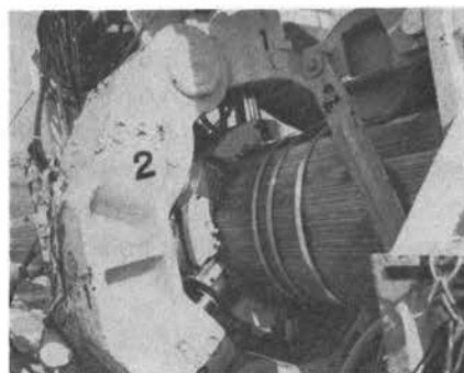
写真-4 ケーブルのスクイズ
