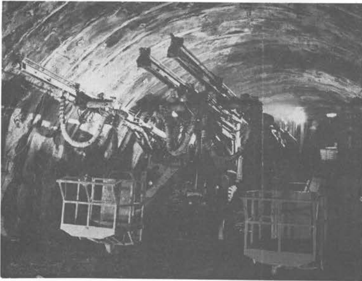
日本道路公団・北陸自動車道市振ト ンネル上り線(佐藤工業株式会社施工) で使用中の油圧2ブームホイールジ ャンボ MAXIMATIC H207B
