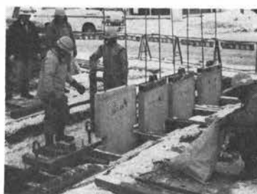
写真-1 札幌地下鉄での冬期施工
