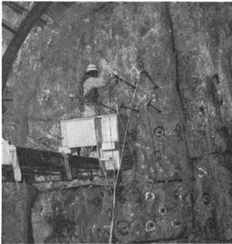
写真-4 ハイドロクラッカーによる割岩作業
