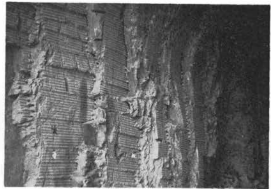
写真-7 掘削後の壁面
