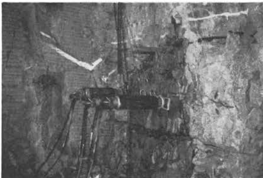
写真-5 油圧くさびによる割岩作業
