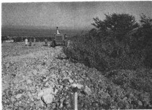
写真—2 試験地施工前状況
