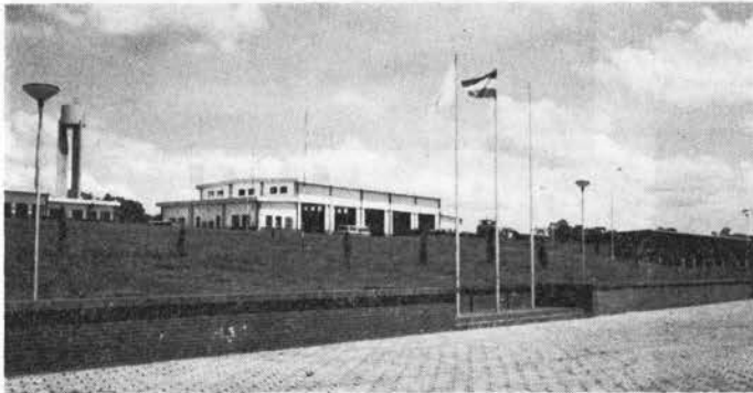
写真-7 無償協力で建設した修理工場
