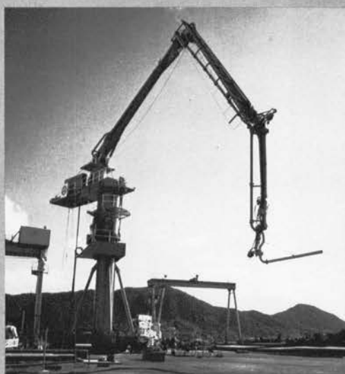
◇コンクリートプレーシングクレーン ：大林組〔先端ブーム位置〕
