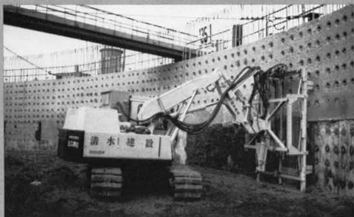
◇自動壁面目荒し機：清水建設 〔目荒し位置・程度〕
