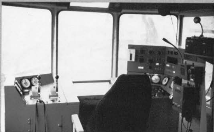
ケーブルクレーン：日立製作所 〔自動運転〕⇨
