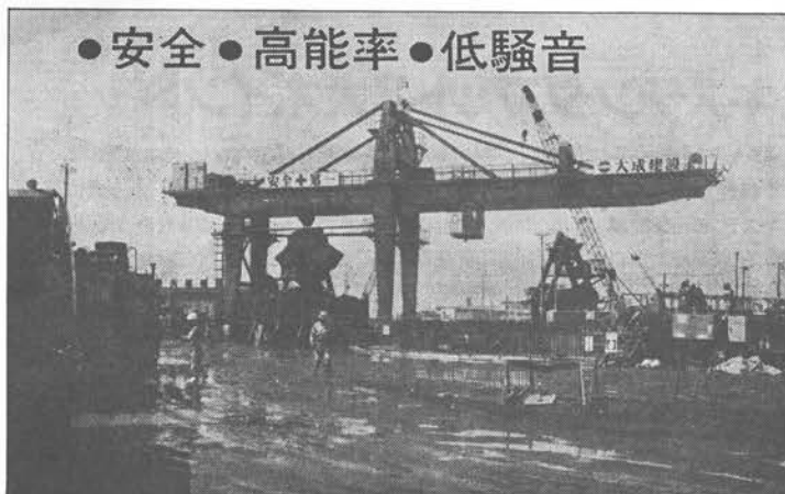
YBM-110型 バケット8M 3 能力1000M 3 /h(地下25Mより)
