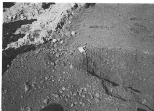
写真-6 2回掛個所断面状況
