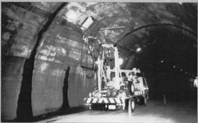
トンネル照明清掃装置：堀田鉄工所 〔洗浄装置，自動洗浄〕⇨
