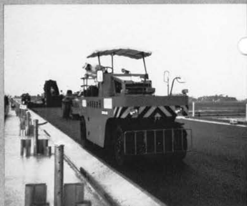
◆自動操縦式タイヤローラ：鹿島道路 〔締固めパターンの自動操縦〕
