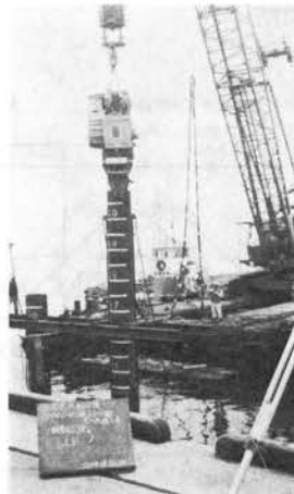
写真-1 鋼管杭の打込み
