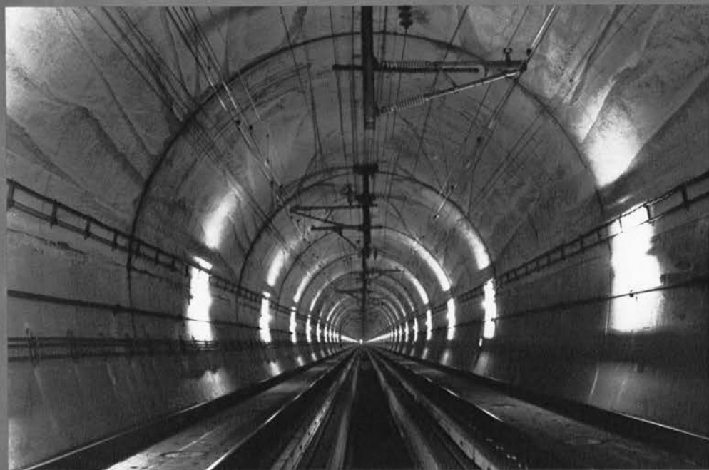
⇨ 完成した陸底部トンネル
