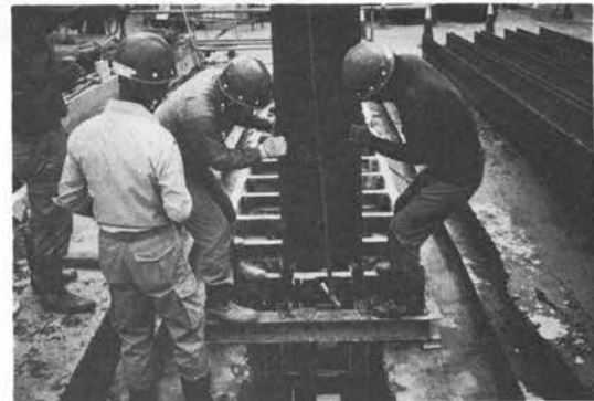
写真-3 親杭の建込み
