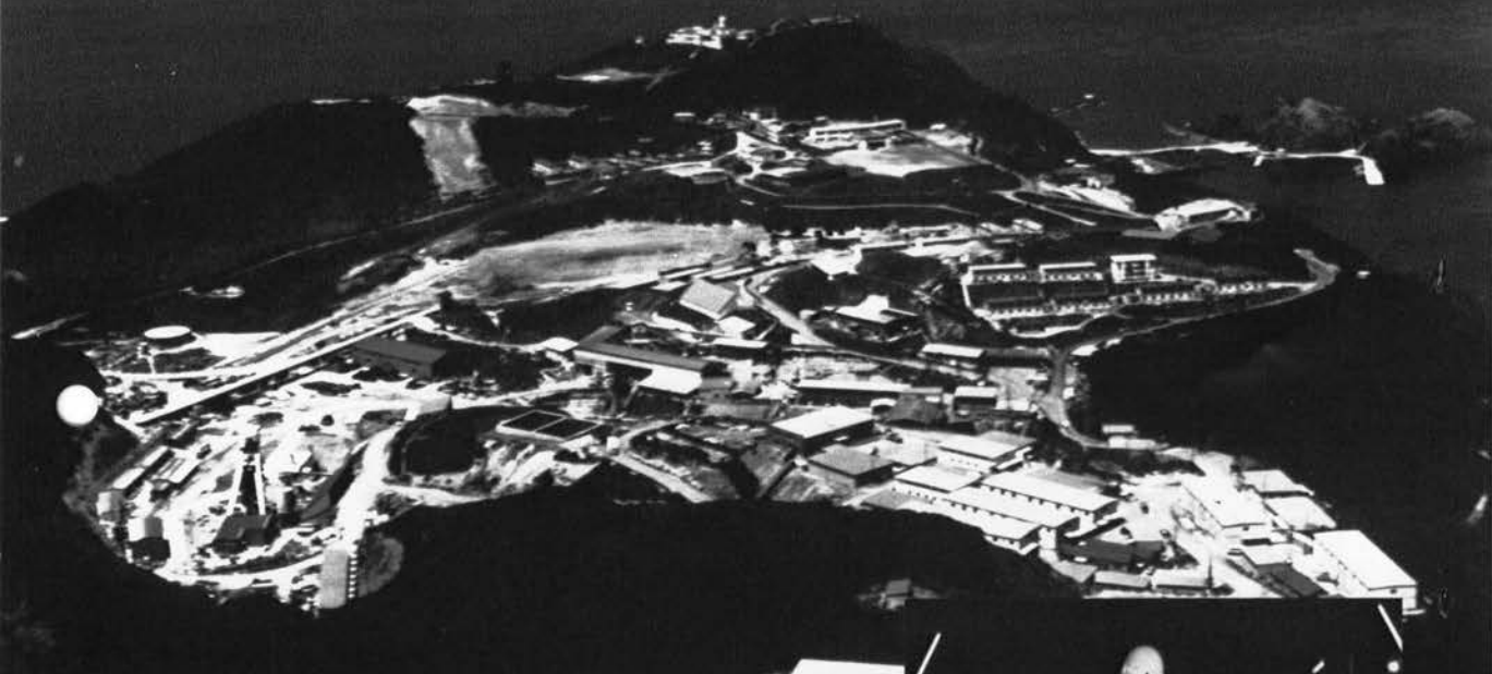
◆ 竜飛工事現場全景(北海道方を望む)
