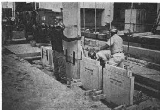
写真-4 PC板の建込み
