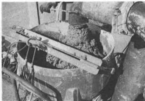
写真-6 コンクリート
