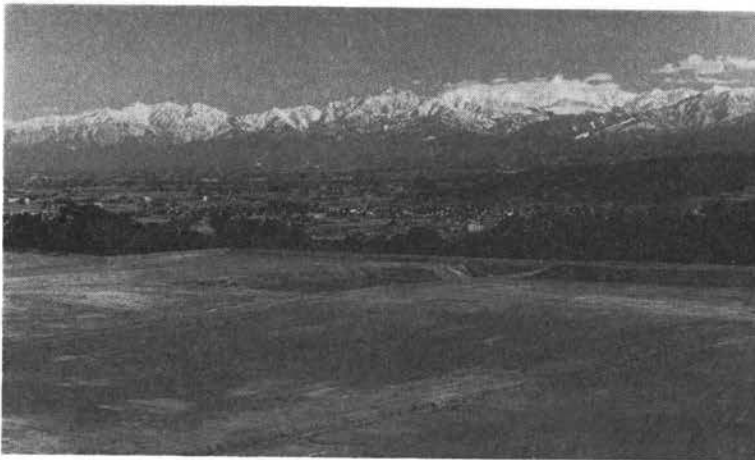
写真-3 造成中の工場敷地，遠景は立山連峰と富山平野
