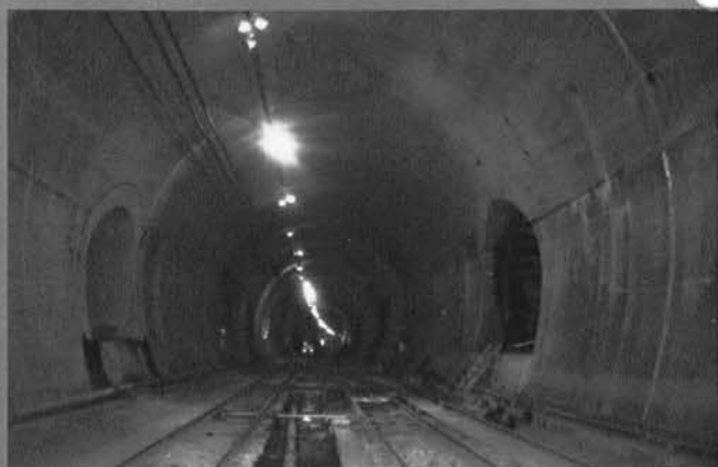
⇨ 定点工事現場
