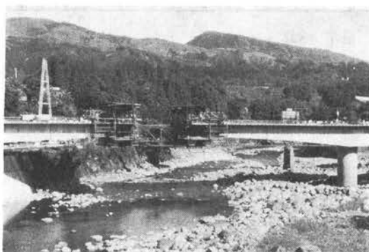
写真-1 宮野原橋（VSL E 5-7 使用）
