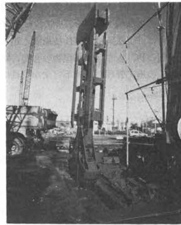
写真-2 MLバケットによる溝掘削
