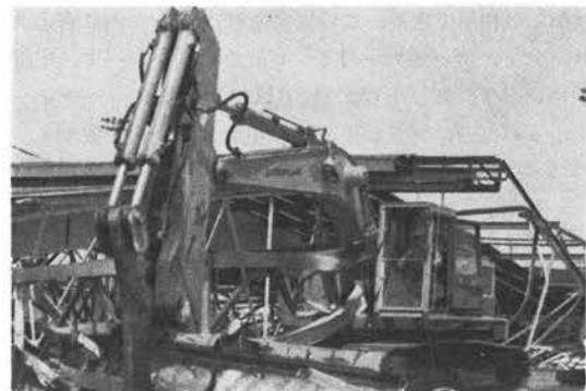
写真-3 鋼材切断機
