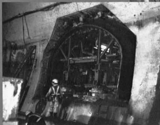
⇨ 工事中の避難用連絡誘導路
