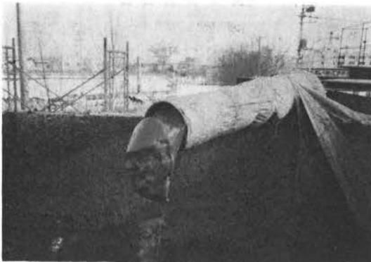
写真-3 排土状況
