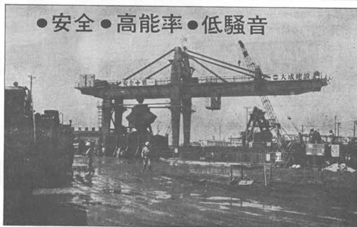
YBM-110型 バケット8M 3 能力1000%/6(地下25Mより)
