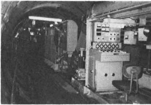
写真-2 BTP 坑内設置状況
