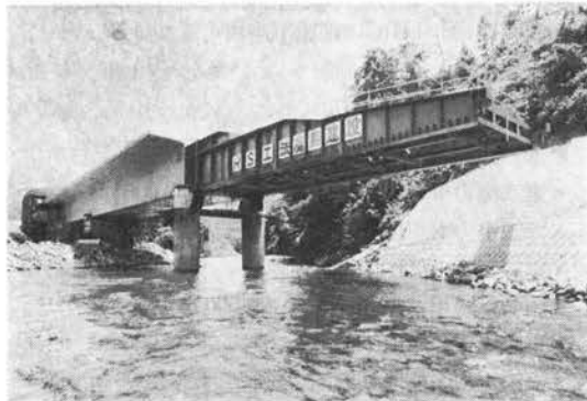
写真-1 米代川橋
