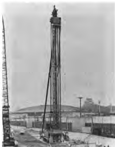
写真-7 5軸ソイルオーガマシン
