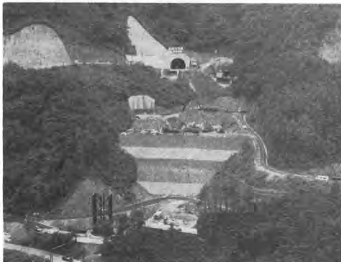
写真-2 テールアルメ土留壁
