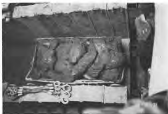
写真-3 ずりトロの中の掘削土
