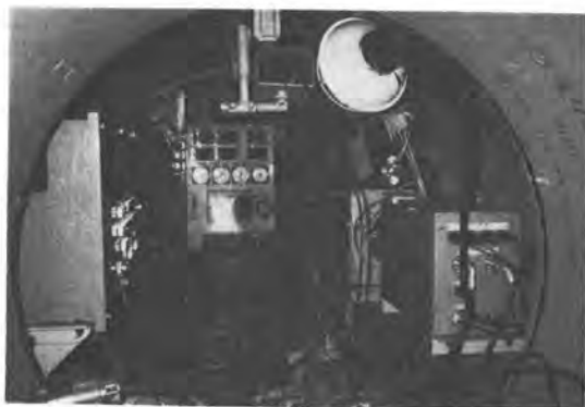
写真-28 ターゲット取付状況（泥水掘進セミシールドへの適用例）
