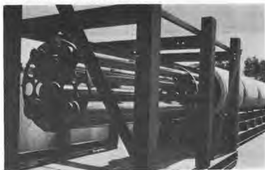
写真-31 懸垂式ケーブル管路保持移動装置
