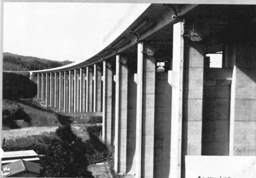
⑤ 大型移動支保工で施工した 小木津高架橋
