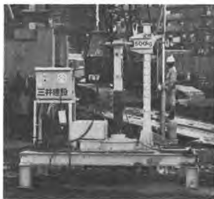
写真—12 パイルジェッター
