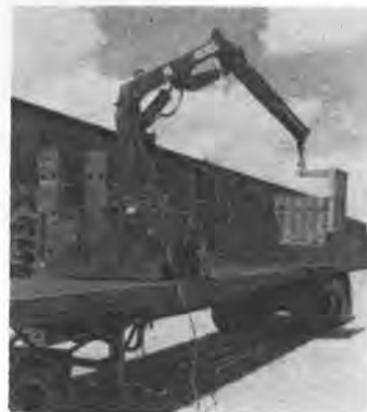
写真-7 ナックルブーム式サービスクレーン
