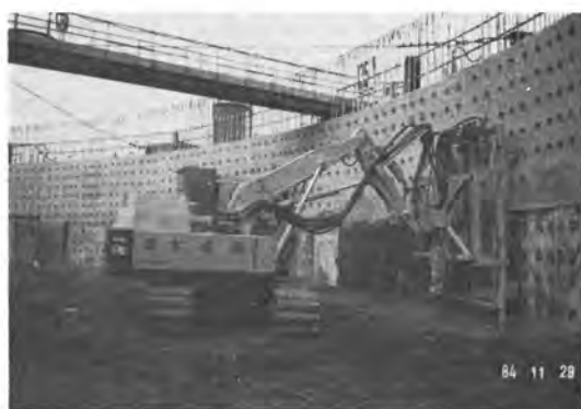
写真-14 自動壁面目荒し装置
