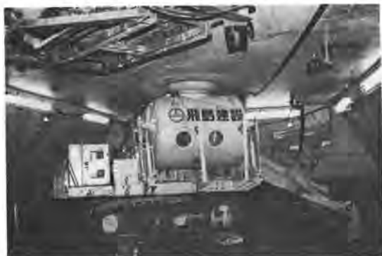
写真-1 耐圧運転室付ケーソン函内掘削機
