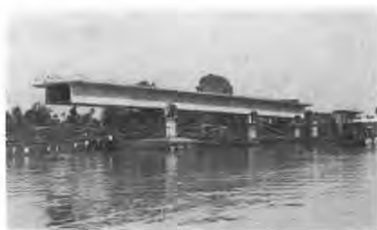
写真-4 パツムタニ橋押出し桁
