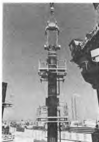
写真-4 自動玉掛外し装置
