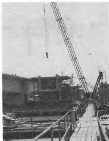
写真-2 63t クレーンによる基準ブロックの設置
