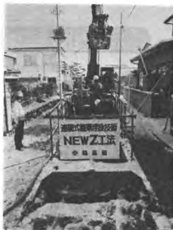
写真-30 New Z (on-III 型) 推進機
