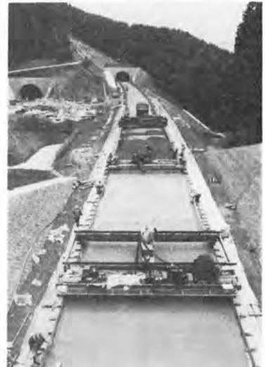
写真-3 コンクリート舗装版舗設全景
