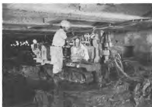
写真-9 MM-R 施工状況
