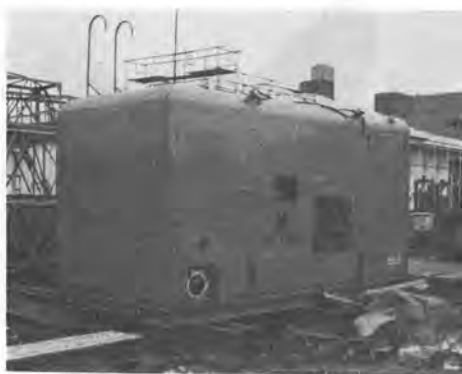
写真-13 杭頭余盛コンクリート除去装置
