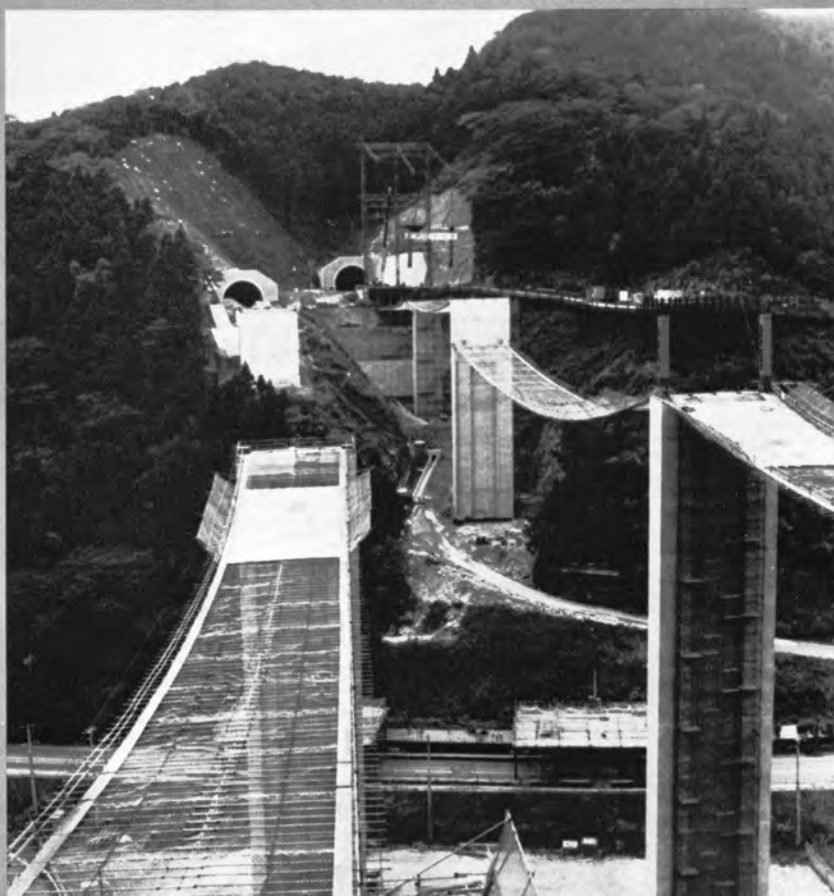
㊦ 宮田川橋上部工 架設準備状況
