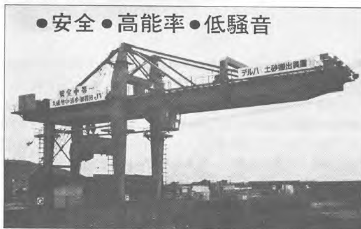
YBM-110型 バケット8M 3 能力1000M 3 /D(地下25Mより)
