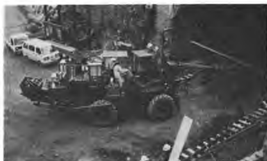
写真—20 吹付ロボットダイナミックローリ
