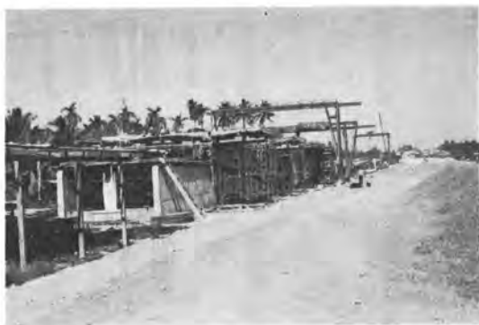
写真-1 ロングライン方式によるブロック製作台
