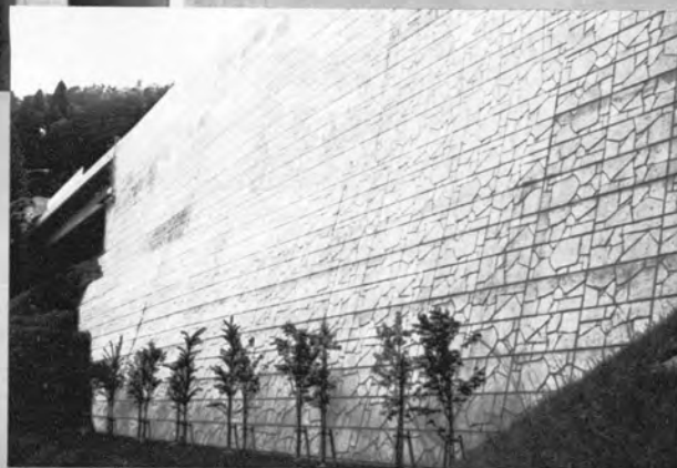
⑥ 高さ 26m の大擁壁（小木津山自然公園）
