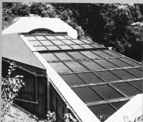
⑦ トンネル間ルーバー （成沢第 1 トンネル～成沢第 2 トンネル間）
