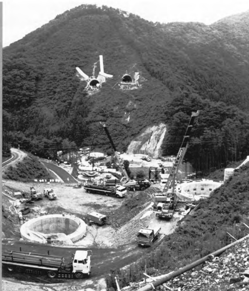
㊦ 鮎川橋基礎工 (大口径深礎 \phi 10\text{m} ) 施工状況
