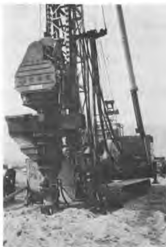
写真-5 マルチバイプロハンマ
