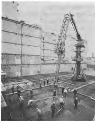
写真-2 プレーシングクレーン
