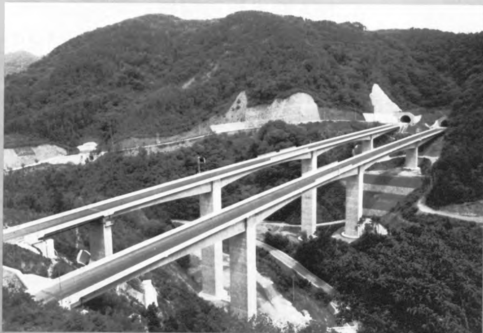
④ 鮎川橋（PC 4 径間連続ラーメン箱桁）完成状況。前方は鮎川工事用道路（急峻山腹切土による新設工事用道路）
