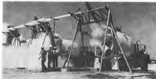
写真-1 窒素ガスによるコンクリートの冷却
