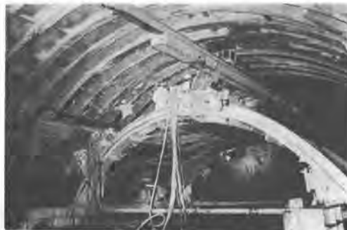
写真-1 TAパイプルーフ工法
