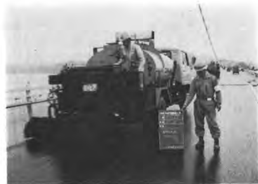
写真-7 ディストリビュータによるタックコートの施工
