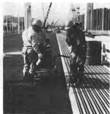
写真-10 注入目地の施工
