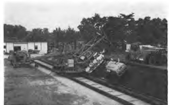
写真-44 傾斜面舗装システム
