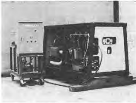
写真-34 アブレイシブルウォータージェット装置
