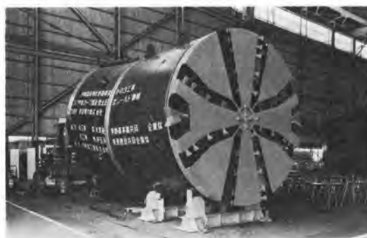
写真-6 川重急カーブ掘進型シールド機
