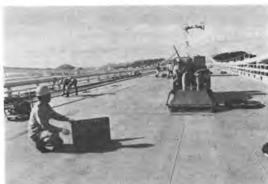
写真-3 大型研掃機による研掃
