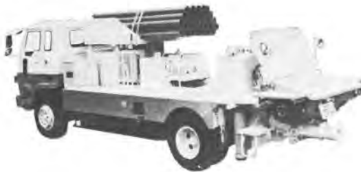
写真-9 石川島 IPF 100 TD コンクリートポンプ車
