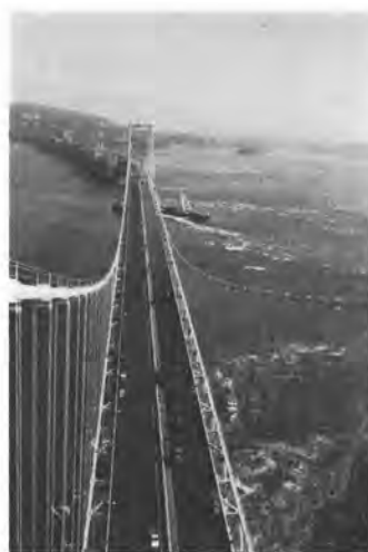
写真-1 舗装工事中的大鳴門橋
