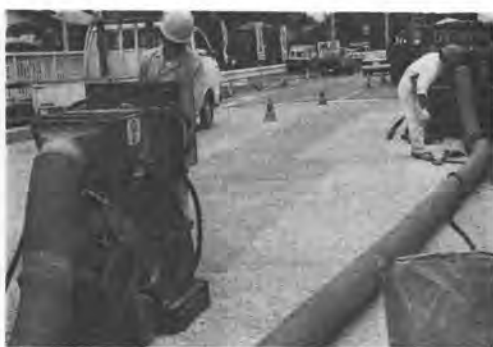
写真-3 ショットブラストによるコンクリート舗装の目荒し
