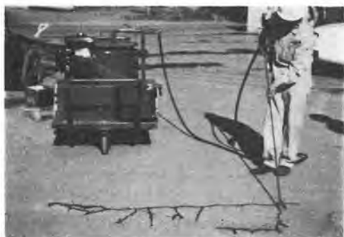
写真-2 クラック注入機
