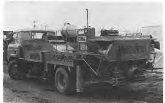
写真-10 新潟 NCP 9 T-25 コンクリートポンプ車
