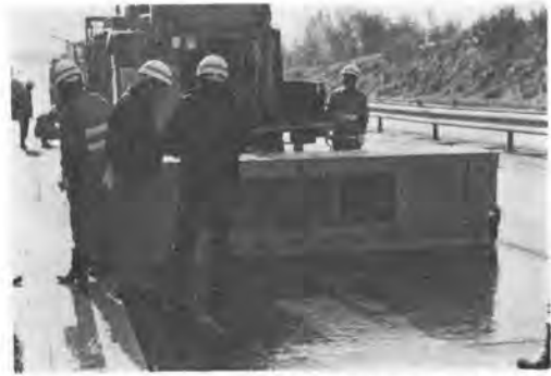
写真-6 ウォータージェットによるグルーピング機械
