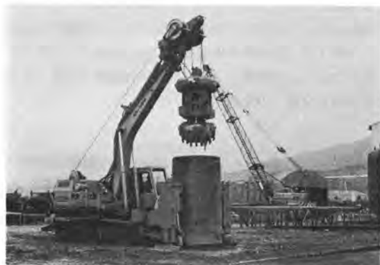
写真-3 共栄土建 MS-HBM-1500 立坑掘削機
