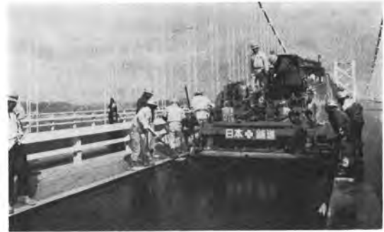
写真-5 グースフィニッシャーによる舗設
