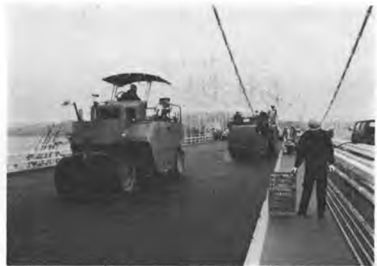
写真-9 改質アスファルトの転圧
