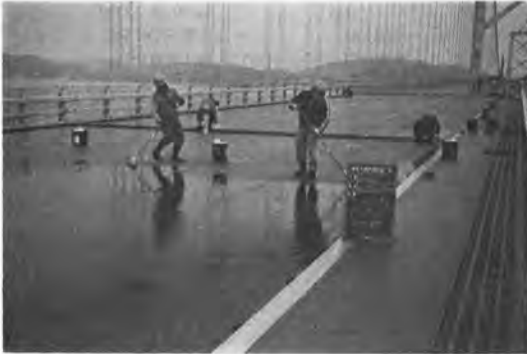
写真-4 接着層第一層の施工
