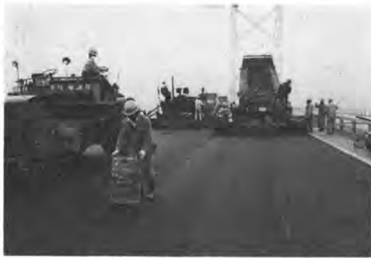
写真-8 改質アスファルトの敷ならし
