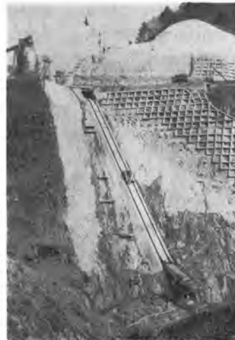
写真-36 無人コンクリート運搬システム
