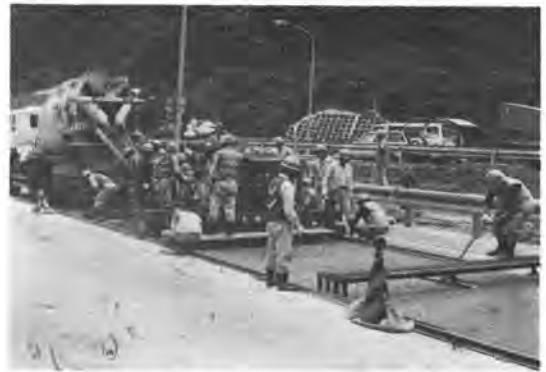
写真-9 専用コンクリートフィニッシャによる薄層コンクリートの施工
