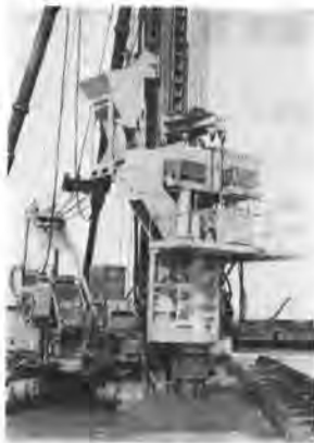
写真-1 秋田港における施工
