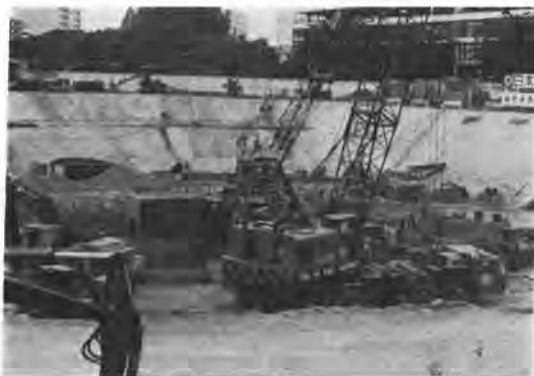
写真-1 現場作業風景
