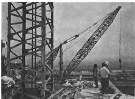
写真-6 解体に使用した三脚デリック
