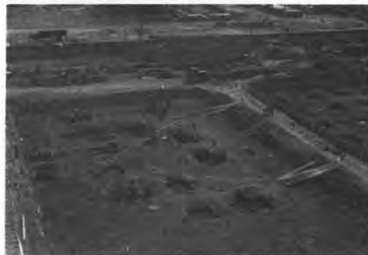
写真-2 機械掘削後のベース部分の手掘り
