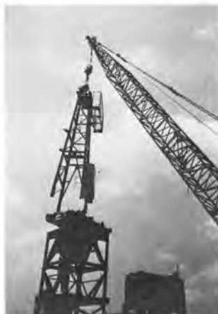
写真-5 解体中のタワークレーン
