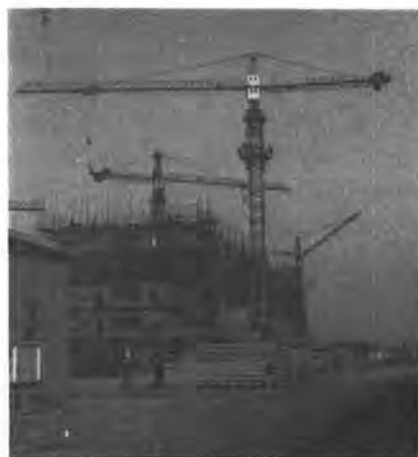
写真-3 タワークレーン
