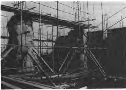
写真-6 冬季コンクリート打設後の養生
