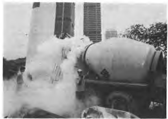
写真-5 液化窒素による生コンクリートの冷却
