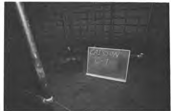
写真-6 クーリングパイプ
