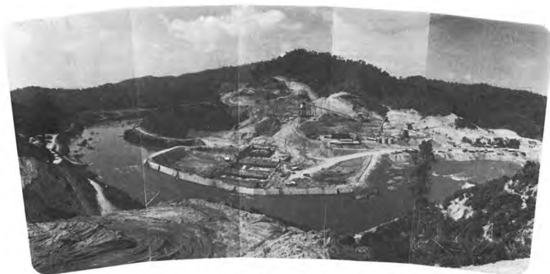
写真-1 半川締切による Stage 1 ダムコンクリート施工
