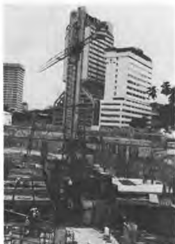
写真-3 基礎上に据付けたタワークレーン
