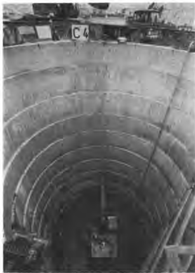
写真-3 掘削状況
