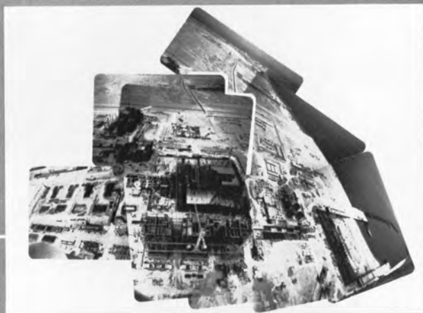
⇨工事現場全景⇨
