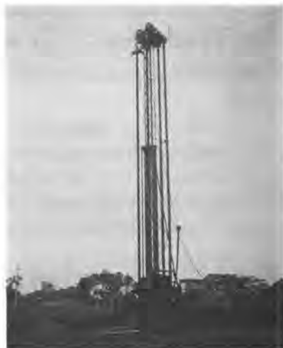
写真1 圧入式打設機
