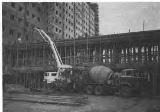
写真-4 わたり戸下のスラブコンクリート打ち
