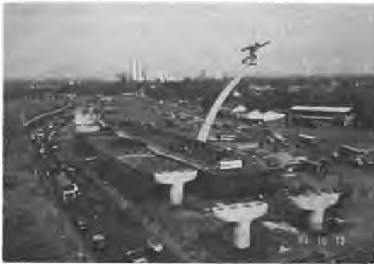
写真-2 第3工区施工中
