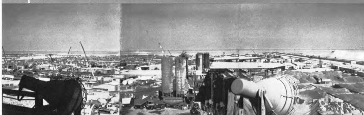
⇨仮設ヤードより工事現場を望む
