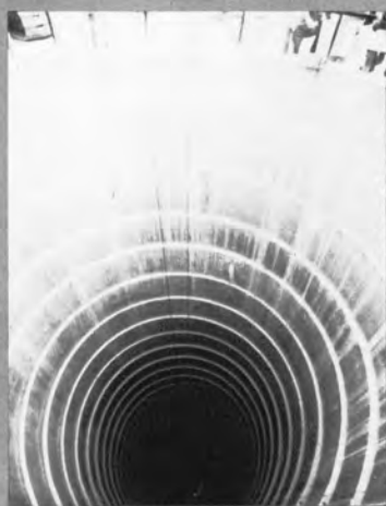
⇨掘削中の深礎内部
