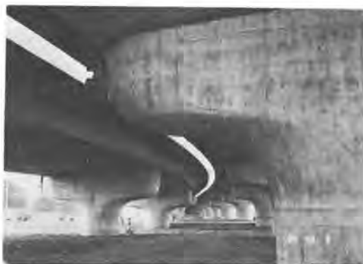
写真-1 第3工区橋脚部
