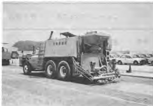
写真-1 施工状況
