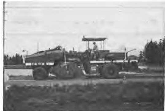
写真-1 施工状況
