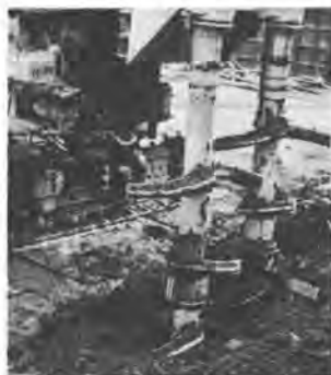
写真-1 施工状況（攪拌翼部分）
