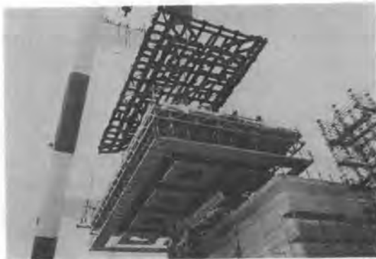
写真-1 防波堤ケーソンスリップフォーム一括撤去
