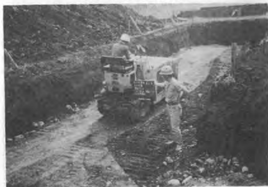
写真-4 実験場の転圧
