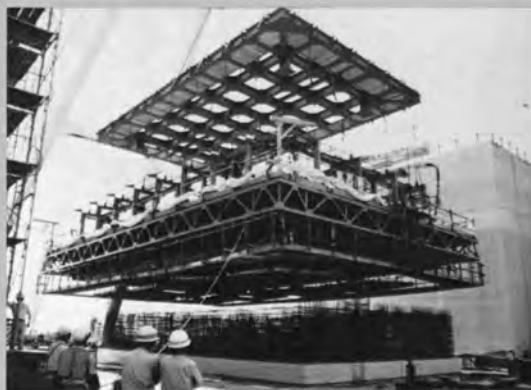
起重機船による スリップフォーム据付◆◆
