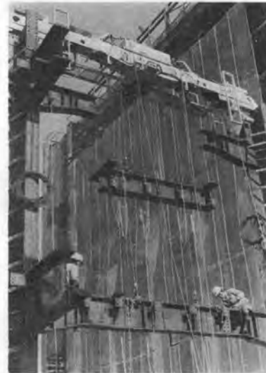
写真-4 大梁の取付
