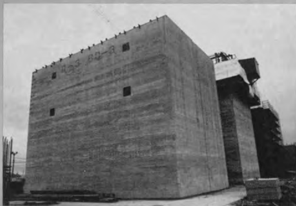
⇨防波堤ケーソン
