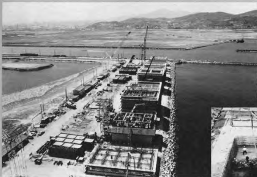
◆ケーソン製作ヤード全景
