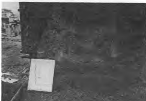
写真-4 仕上り状況
