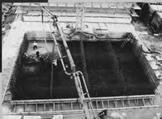
床版コンクリート打設◆
