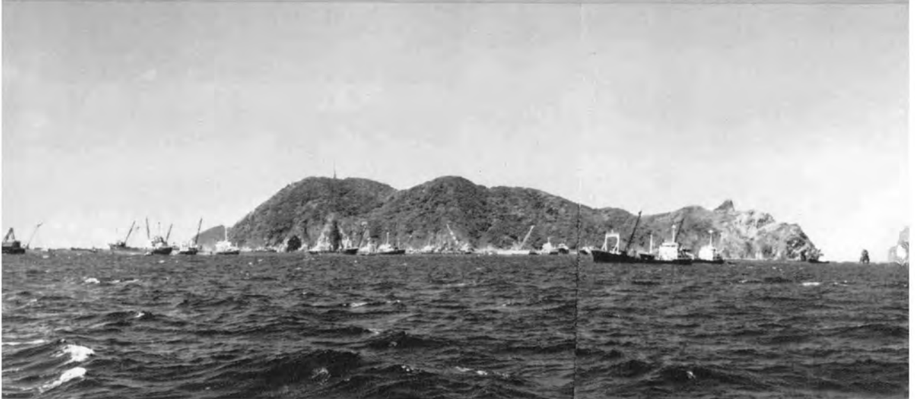
◇海上工事全景
