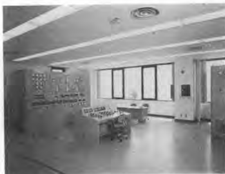
写真-2 排水機場内部の一例
