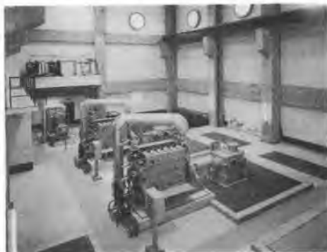
写真-1 排水機場内部の一例
