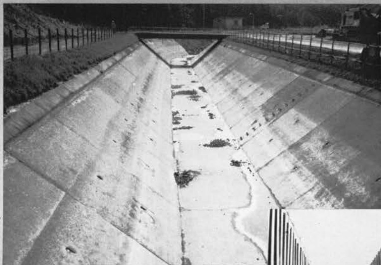
◇愛知用水の既設(旧)断面 この工区は水路外仮回工法を採用しているため、水のない旧断面が見られる
