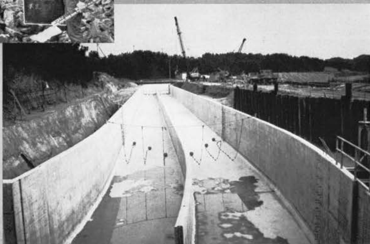
完成した幹線水路断面◇
