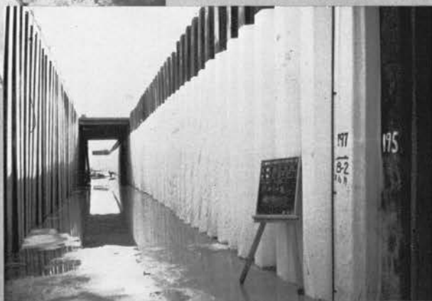
完成した仮回し水路◇
