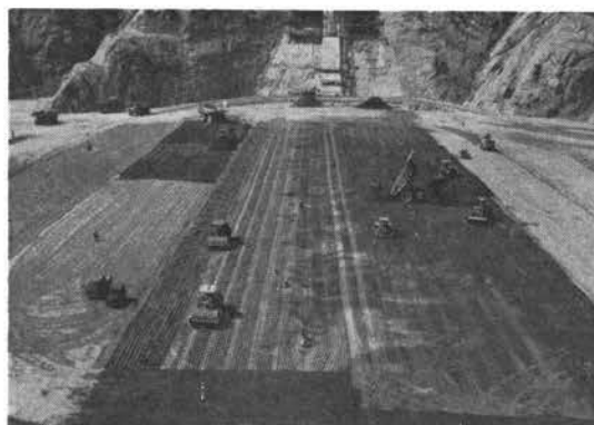
写真-2 コアゾーン撤出し
