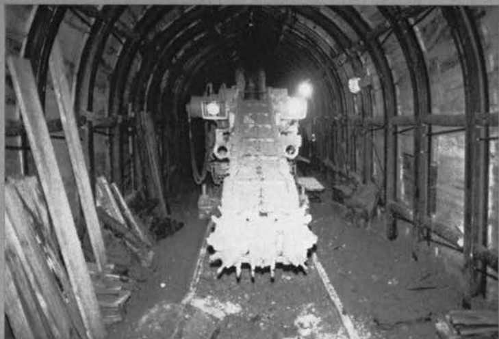
林池Bサイホン岩藤Bトンネル工事 (施工延長S:209.9m, T:420.1m, 掘削機械:カッターローダ)
