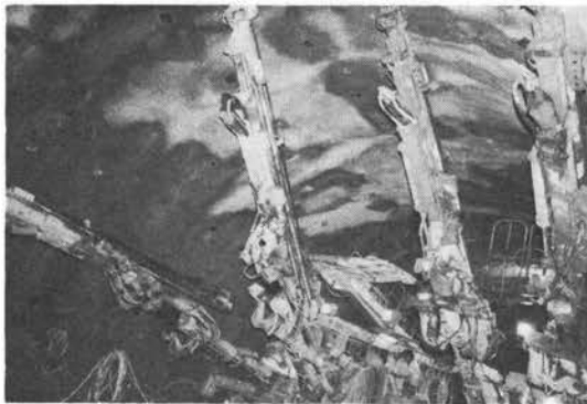
写真-4 断面測定
