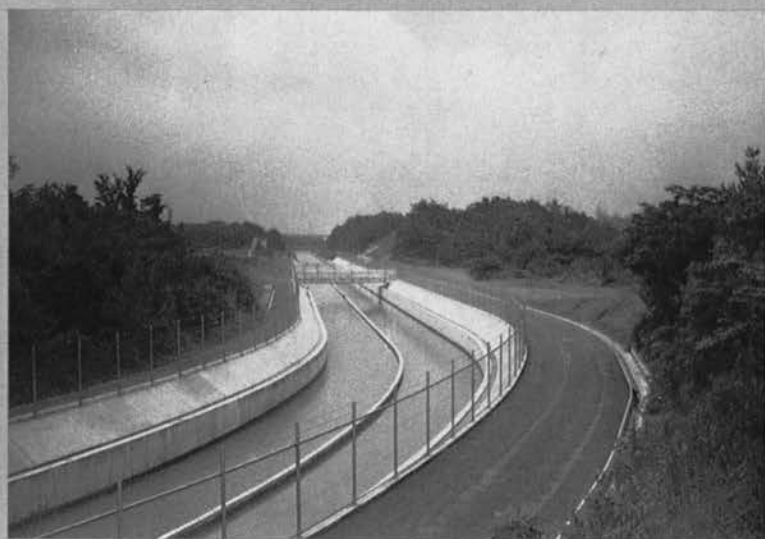
改修が完了した幹線水路◆
