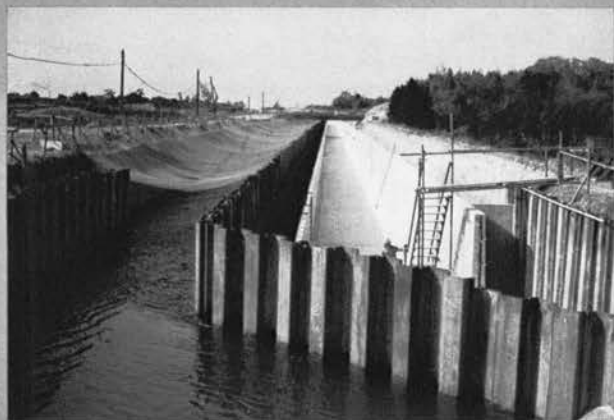
◆第二次仮回し中のコンクリート水路
