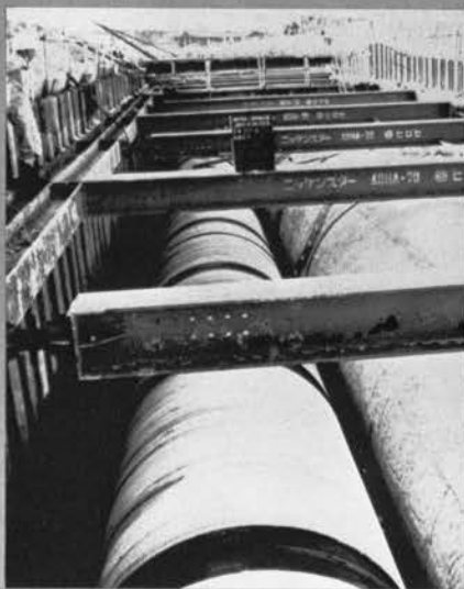
濁池Bサイホン工事 (施工延長200.0m) PC管敷設状況⇨
