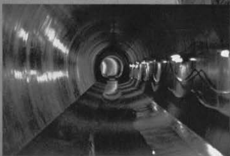
⇨ トンネルの完成状況
