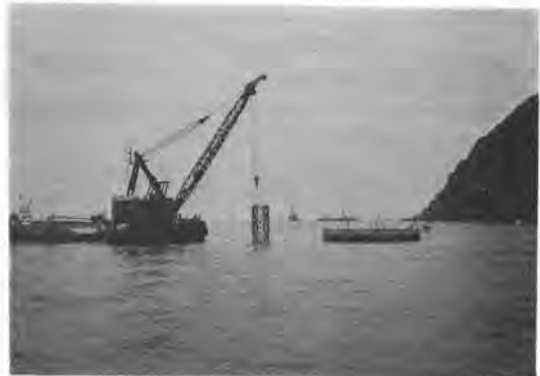
写真-1 施工状況
