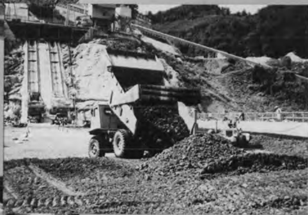
20t ダンプトラックによる コンクリートの運搬⇨
