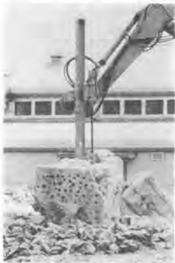
写真-9 オカダアイオン SD 40 サイレントドリル
