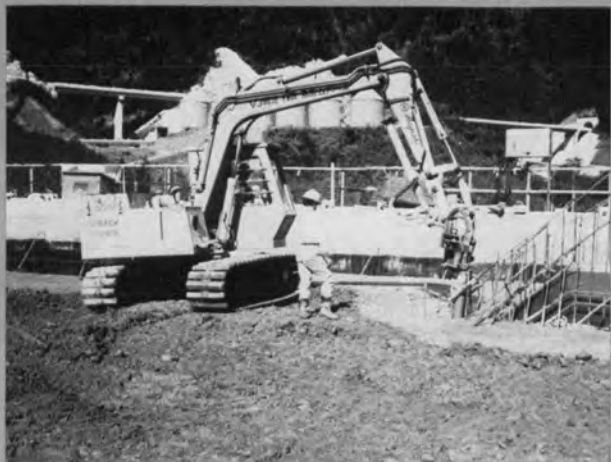
⇨型枠付近の締固め
