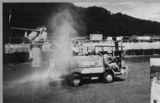
◇夏場の打設面および敷ならし後の 乾燥防止に水噴霧
