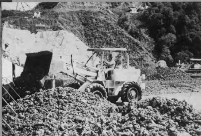
ホイールローダによる 型枠付近のコンクリート運搬◇
