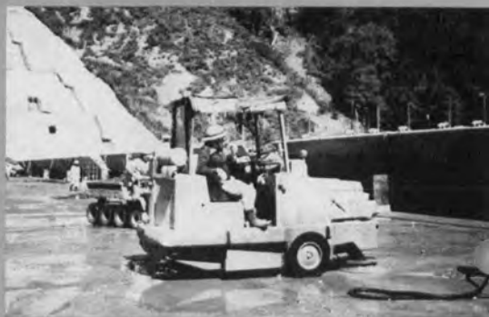
小型スイーパーによる打継面清掃⇨
