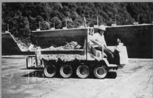
⇨ダンプによる清掃すり運搬
