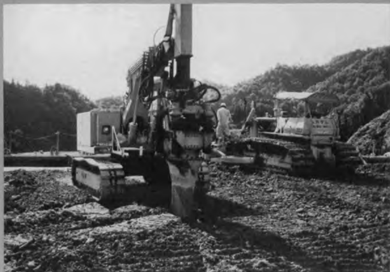
◇PC-120 振動目地切機により横目地の造成
