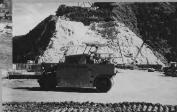
◇25t タイヤローラによる仕上げ転圧◇
