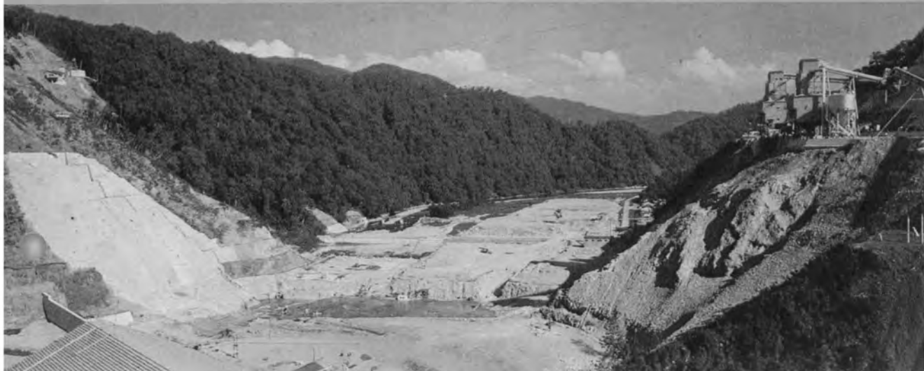
◆上流よりダムサイトを望む
