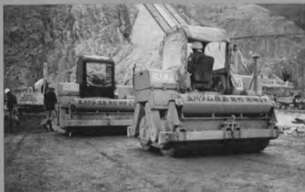
◇振動ローラによる コンクリートの締固め
