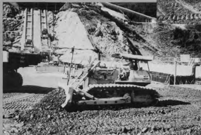
⇨17t 級ブルドーザによる RCD用コンクリートの敷ならし
