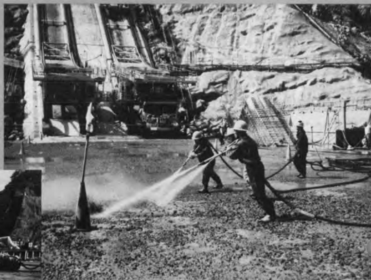
ジェット水による打継面清掃⇨
