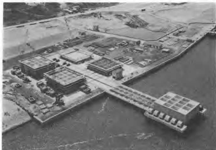
写真-1 シンクロリフトシステムによるケーソン製作進水ヤード
