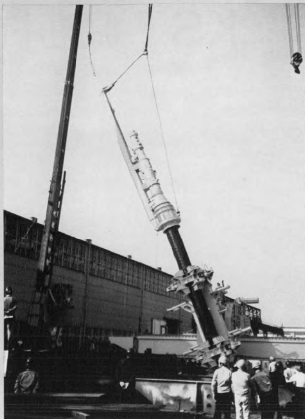
⊕工場試験 パイルホルダの作動およびフライングハンマ セットのテスト中
