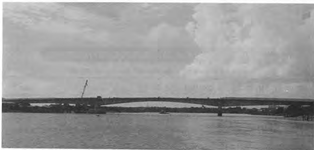
写真-1 完成間近のツワナ橋全景
