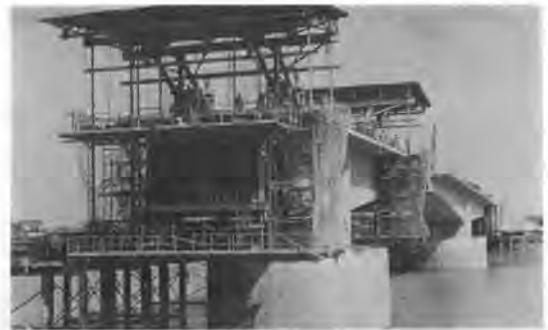
写真-3 ワーゲンによる上部工の架設
