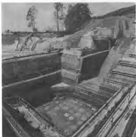
写真-6 発電所基礎掘削終了状況
