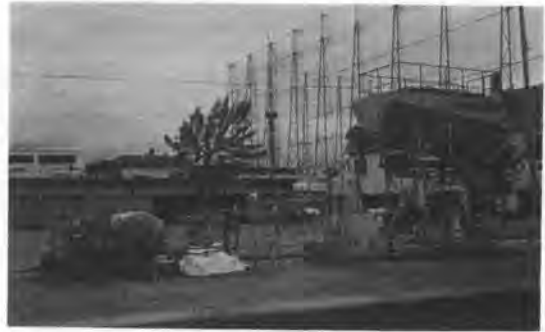
写真-1 システム全景
