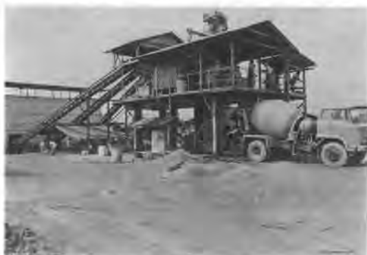
写真-2 パッチャプラント
