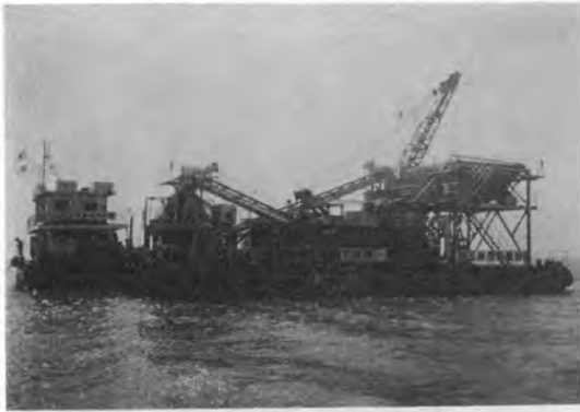
写真-2 運転状況
