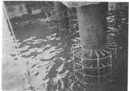
写真-2 鋼管杭補強状況
