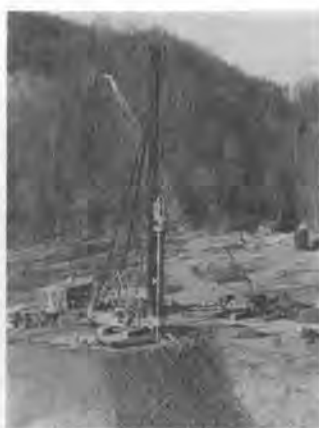
写真-3 SMW 工法
