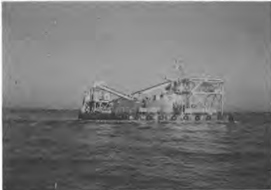
写真-1 KHS号全景
