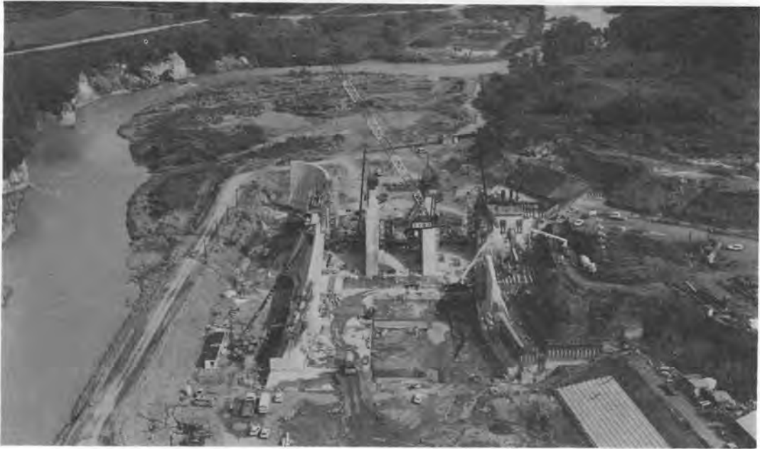
写真-1 ダム施工状況
