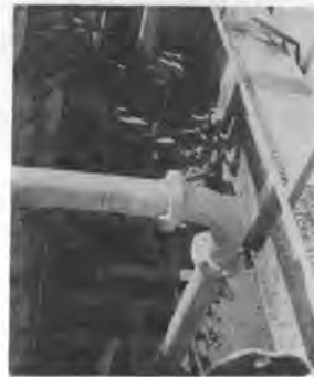
写真-2 施工状況
