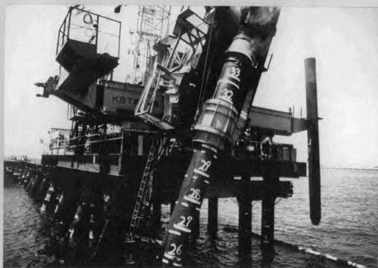
打設中の KST 臨海杭打装置
