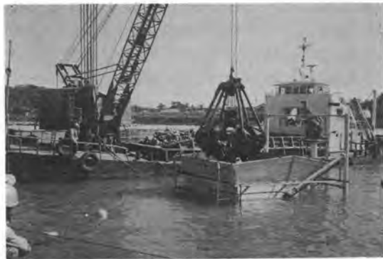
写真-3 ガットによる石材の投入
