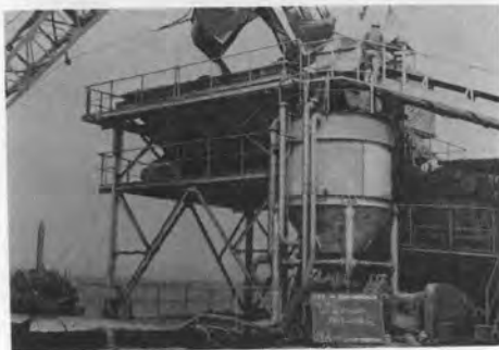
写真-5 土砂投入およびスラリー移送
