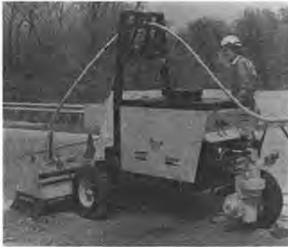
写真-3 コンクリート面切削中のロボット部
