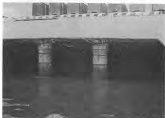
写真-3 鋼管杭補強完了
