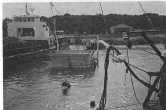
写真-2 ならし機の据付状態
