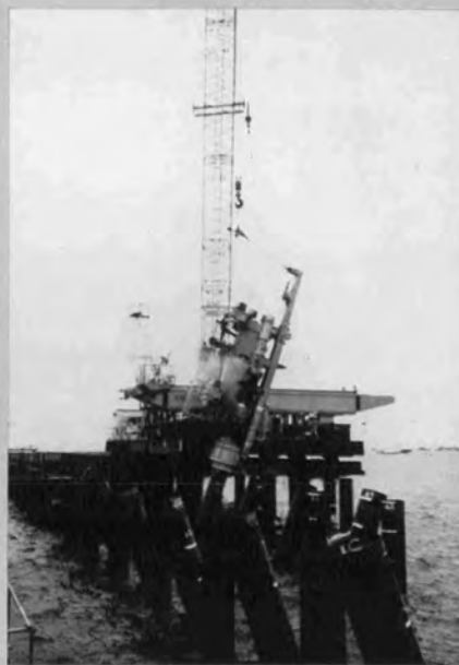
⇨ 第2回打設 (パイルホルダが後退し、杭はフリーとなっている)
