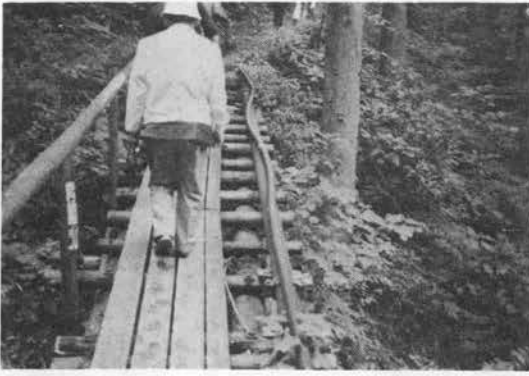
写真-3 輸送管敷設状況（上部のケーブルは通信、制御線）
