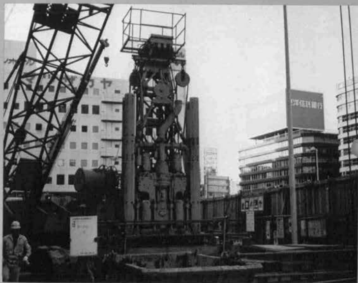
⇨ 連続地下壁掘削機（BW機）
