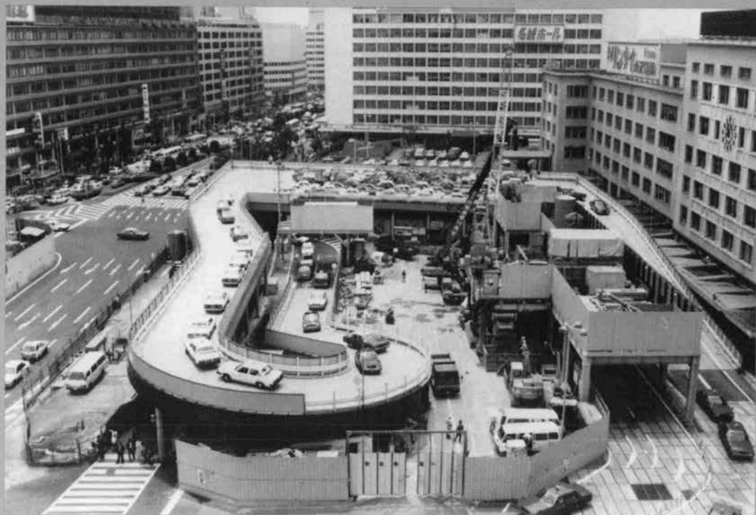
⇨ 駅前広場工事基地（西口）
