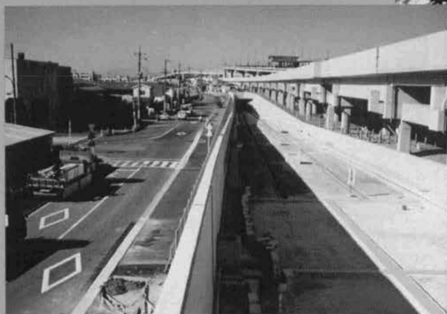
地下トンネルから高架橋への移行部 (右側の高架橋は国鉄京葉線)
