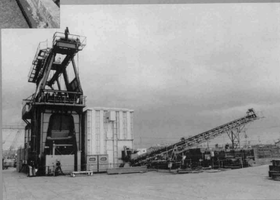
高濃度残土 処理設備全景⇨
