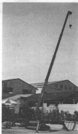
写真-7 東亜(日熊)クローラクレーン TC 304
