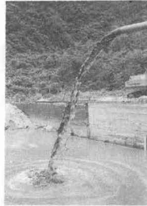
写真-6 砂スラリーの排出状況
