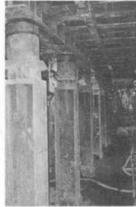
写真-2 名鉄下仮受状況
