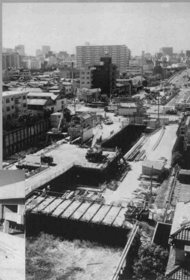
月島駅掘削状況
