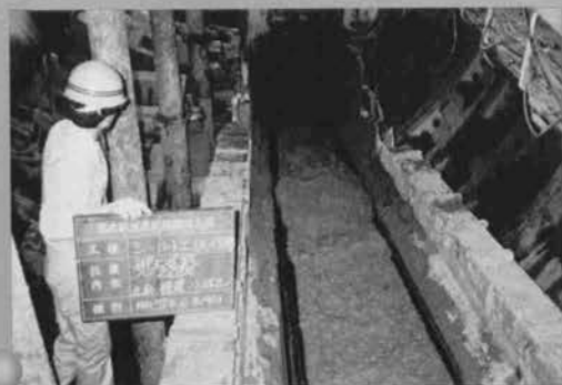
⇨シールド掘削排土状況
