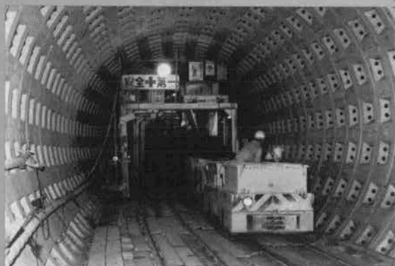
⇨セグメント部掘削土搬出中
