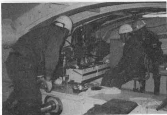
写真-3 操作状況
