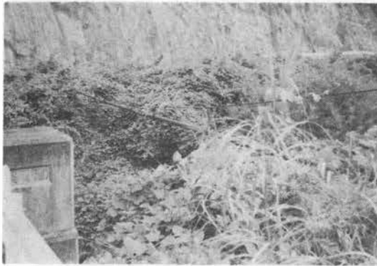
写真-4 輸送管敷設状況（ケーブルはワイヤでつっている）
