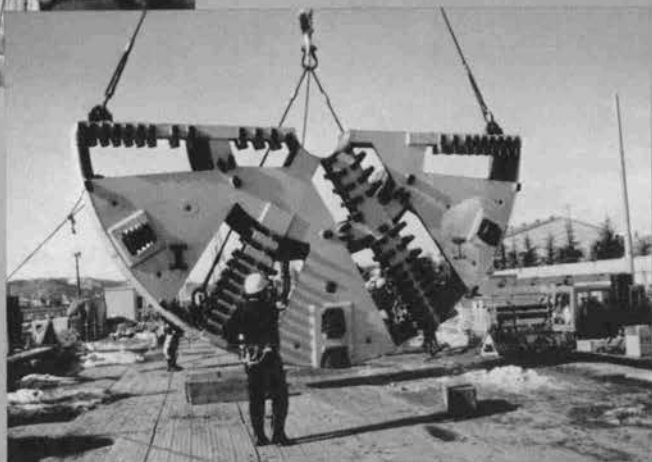
⇨カッターヘッド（半割）投入状況⇨
