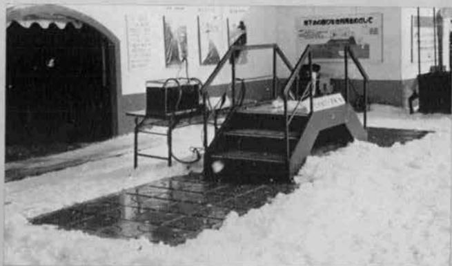
無散水消雪システム◇ (日本地下水開発)
