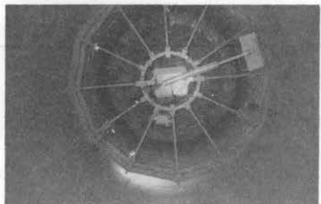
写真-1 施工中の状況
