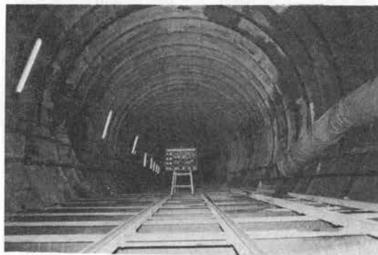
写真-3 鋼製支保工組立て部
