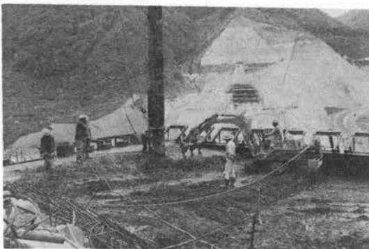
写真-3 固定式スプレッダ打設状況
