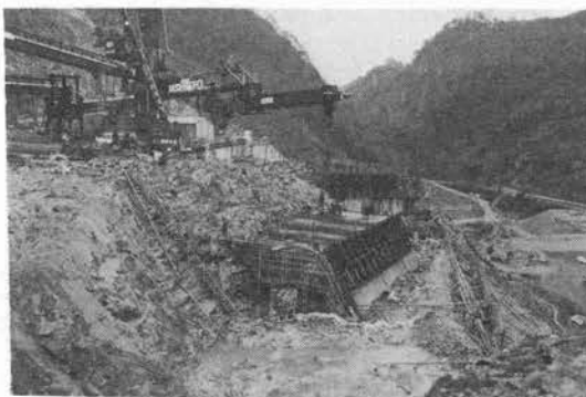
写真-2 固定式スプレッダ打設全体
