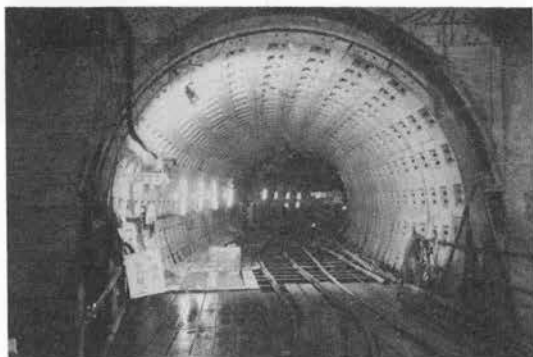
写真-2 セグメント組立て部
