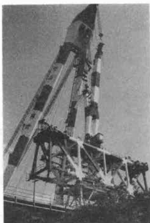
写真-1 クレーン船によるクリーバクレーンの一括架設
