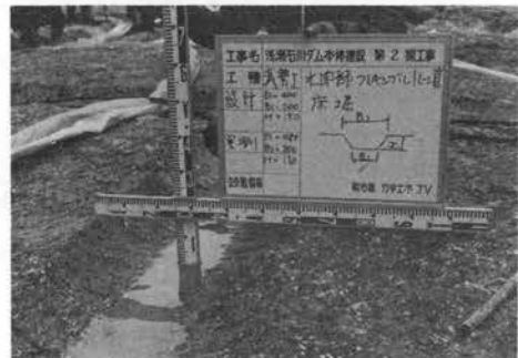
写真—3 ドレーン溝切削出来形
