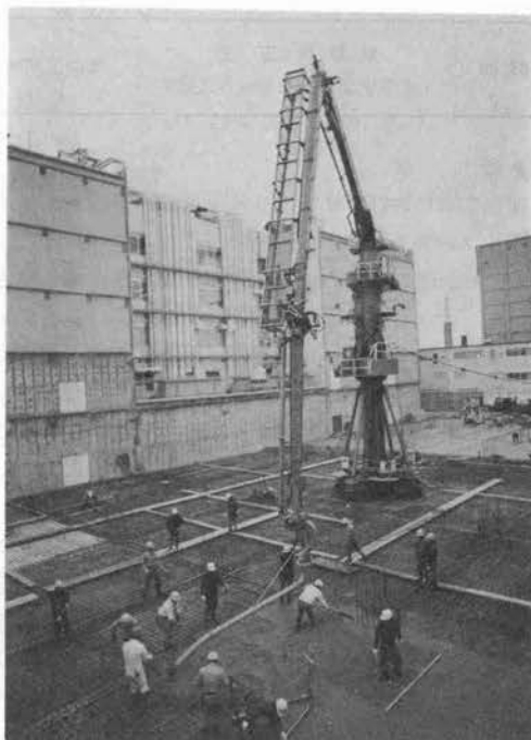
写真-1 ブレーシングクレーン
