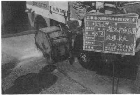
写真-4 切削状況
