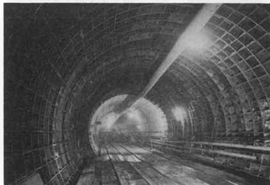
写真—1 トンネルの拡大部
