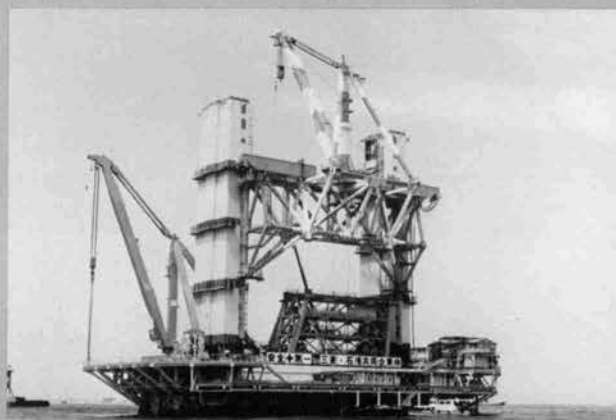
⇨塔柱第5段架設完了（5P）
