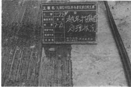
写真-5 越冬打継面処理状況
