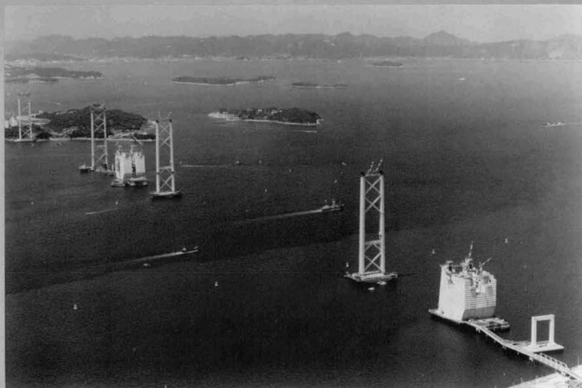
♡ 完成した南・北備讃瀬戸大橋主塔
