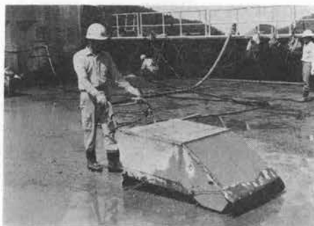
写真-1 レイタンスクリーナ移動状況 (2号機)
