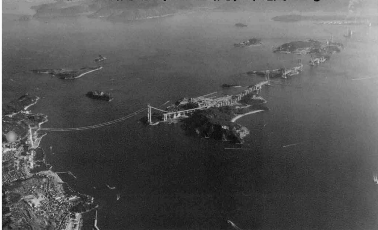
◆ 児島・坂出ルート全景 (岡山県下津井上空より S61.2)
