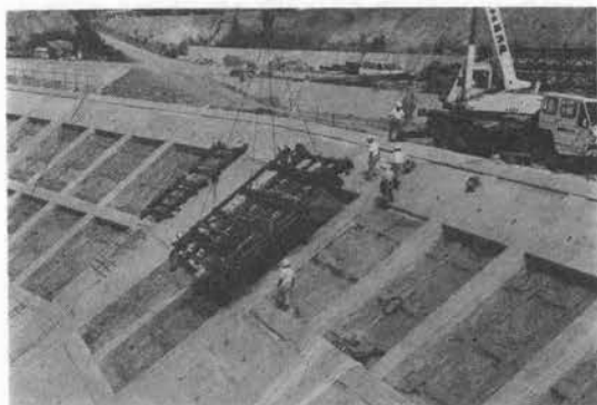
写真-6 型枠設置状況
