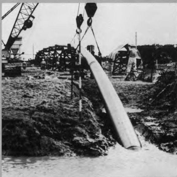
⇨地中へ引込まれていく長尺本管（φ400mm）
