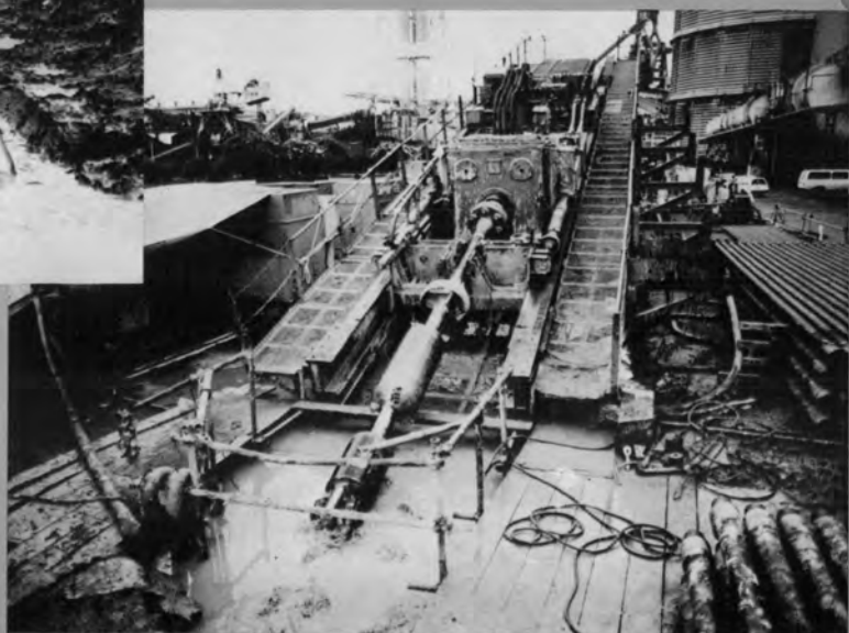
⇨カッタ、リーマ等が発進側へ出て本管引込み完了
