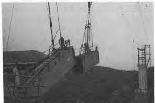
写真-3 アーチ肋の架設
