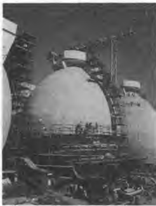
写真-4 回転足場（外部）
