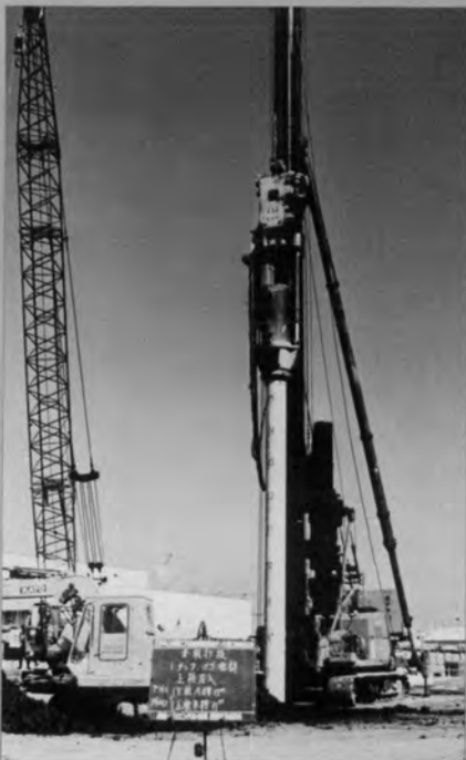
⇨ 抗打機による基礎工事
