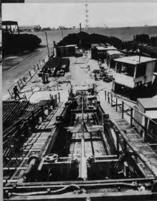
⇨ 発進側より到達側を望む⇨
