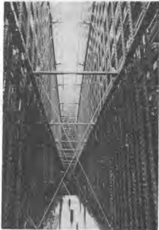
写真-4 ユニット鉄筋の組立状況
