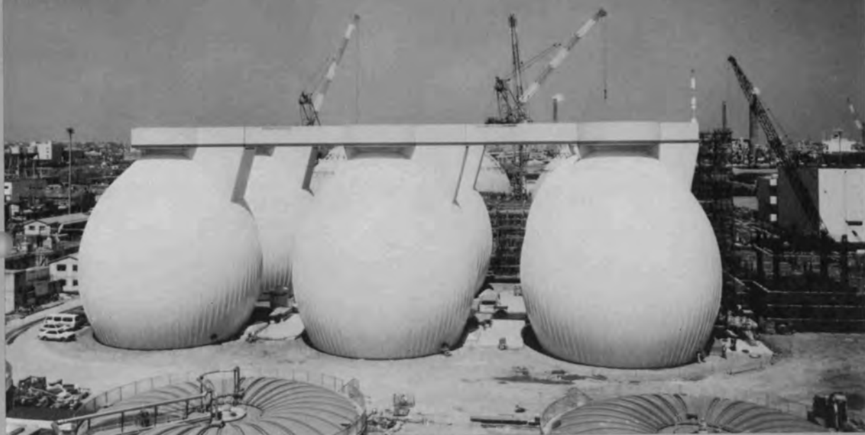
⇨ 工事完了後の全景
