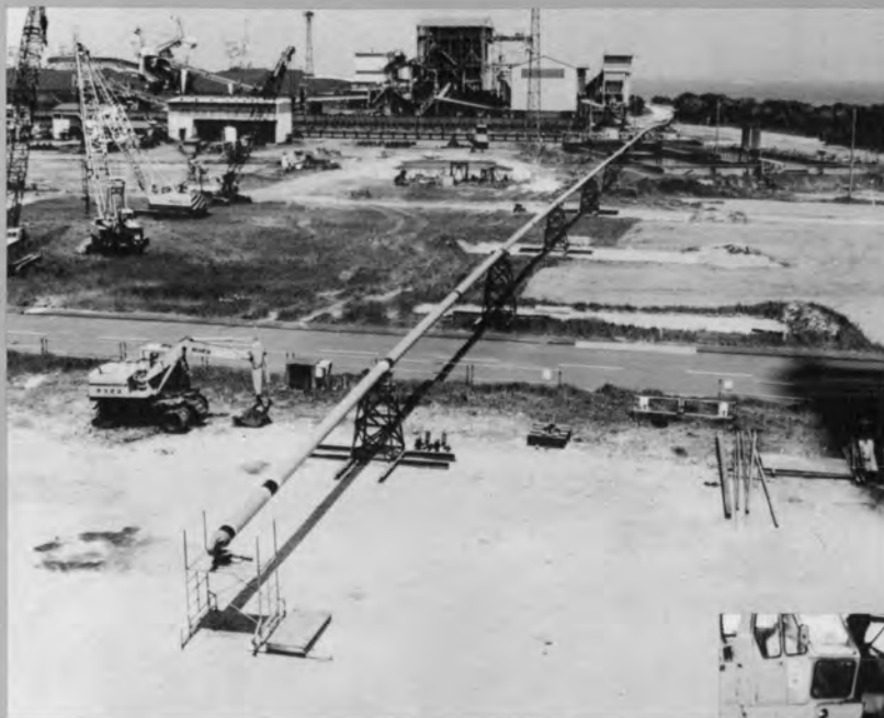
⇨到達側で事前に製作され、ローラスタンド上で引込みを待つ長尺本管（約1.4km）
