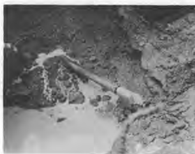
写真-5 パイロットビットが対岸に到達
