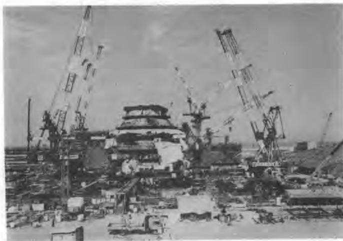
写真-1 工事現場全景
