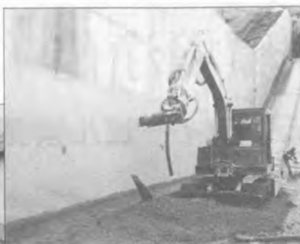
コンクリート壁削り
