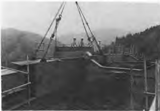
写真-4 アーチ閉合桁
