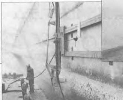
岸壁ハツリ作業
