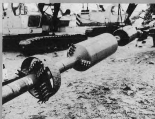
⇨カッタ、リーマ、スイベル等が取付けられ本管引込み準備完了
