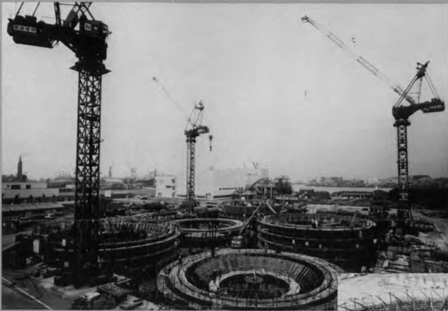
⇨ 工事施工中の全景
