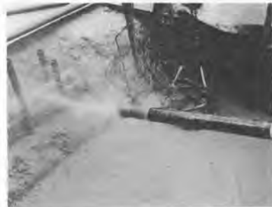
写真-2 パイロットビットが泥水を噴射しつつ回転しパイロット孔掘削の開始
