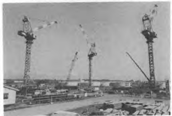
写真-2 タワークレーン
