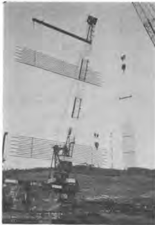
写真-3 ユニット鉄筋のつり込み状況
