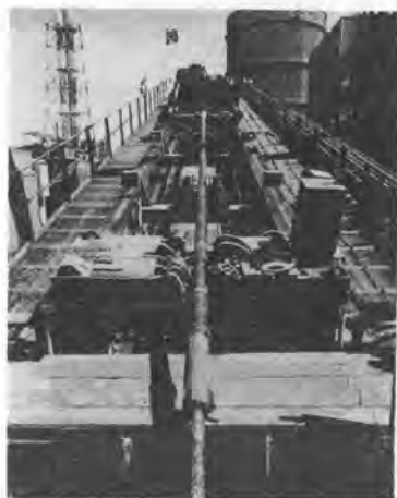
写真-4 ウォッシュオーバーパイプによる掘進開始
