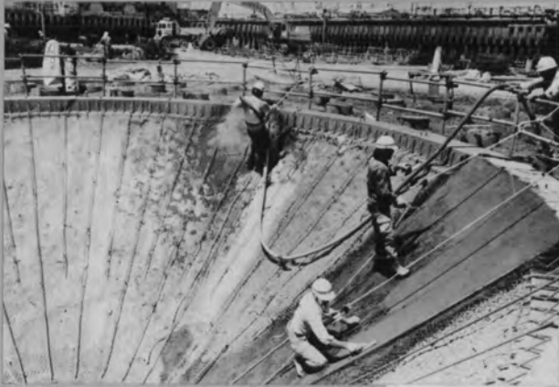
⇨ 円錐部のり面のコンクリート吹付状況
