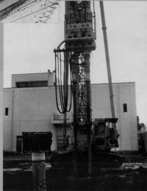
⇨ 深層混合攪拌機による地盤改良
