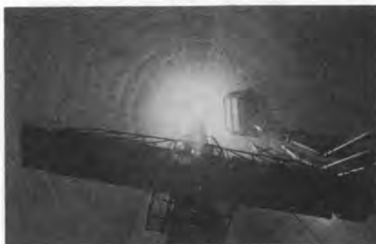
写真-3 回転足場(内部)
