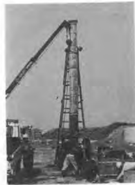
写真-1 ディープウェル工 (さく孔状況)
