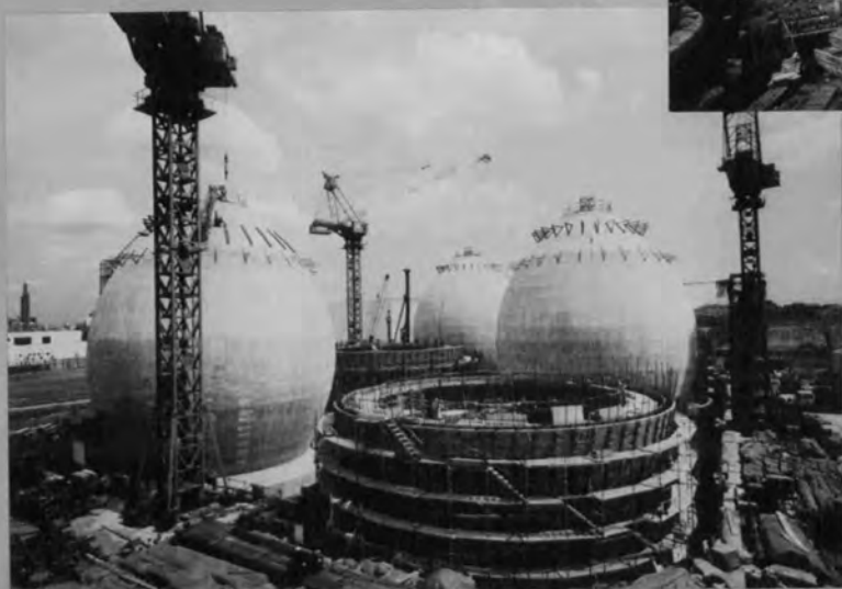
⇨ クライミング足場施工中と 解体後の状況
