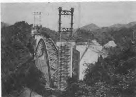
写真-2 ケーブルクレーンと斜り塔
