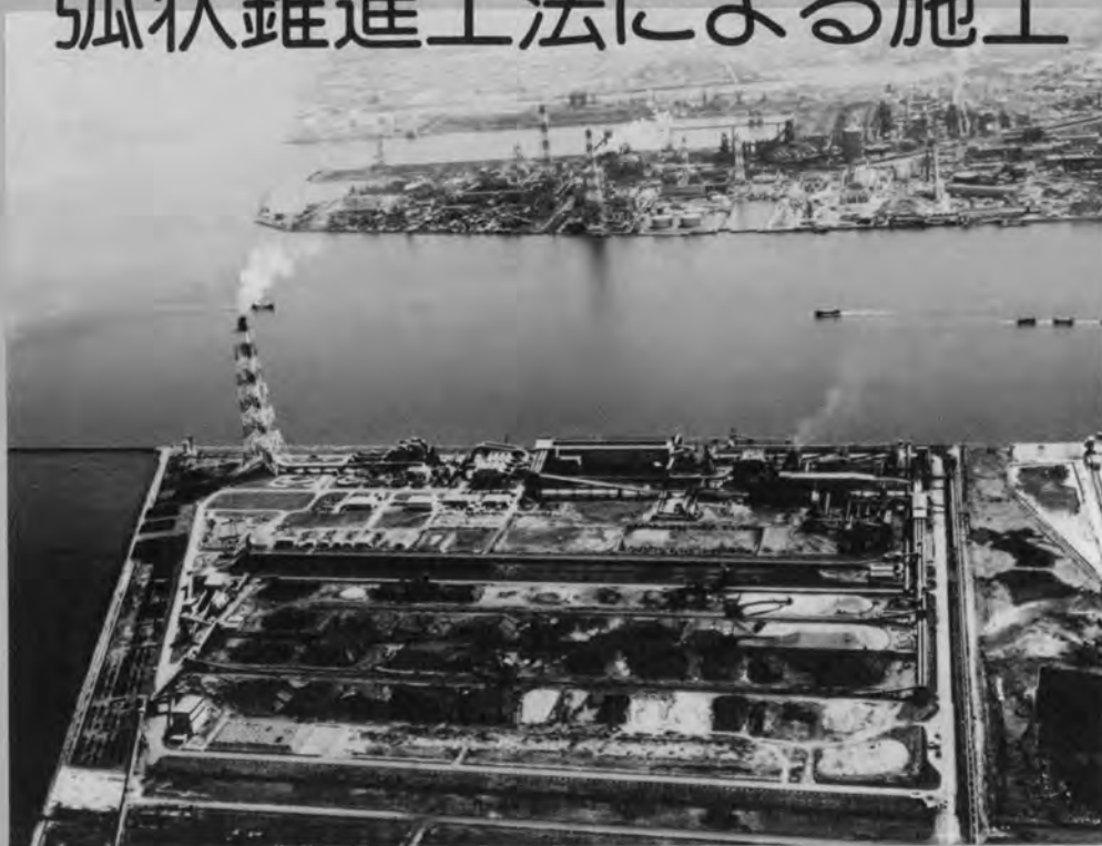
⇨ 施工場所の全景（洞海湾）
