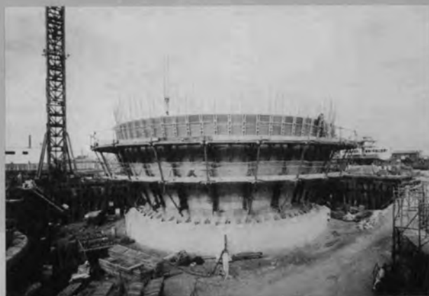
⇨ 外側クライミング足場取付け状況
