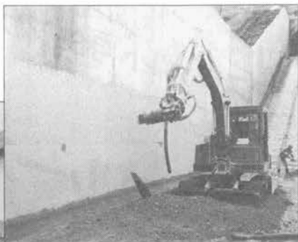
コンクリート壁削り
