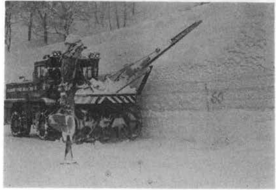
写真-13 高雪堤処理装置
