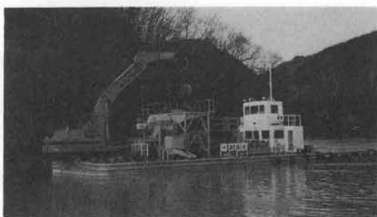
写真-1 全自動クラムシェル浚渫船
