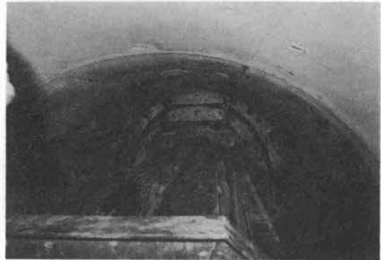
写真-4 ニートルビーム方式による型枠脱型
