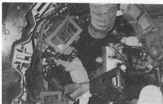
写真-2 狭小断面下での推進機内
