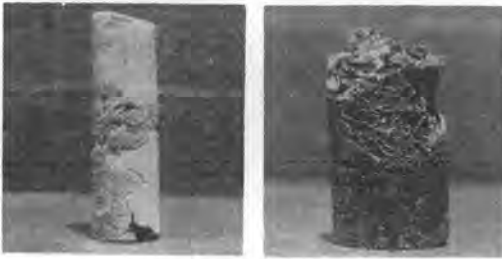
写真-3 グラウト材の充填状態 (コアサンプルによる観察)
