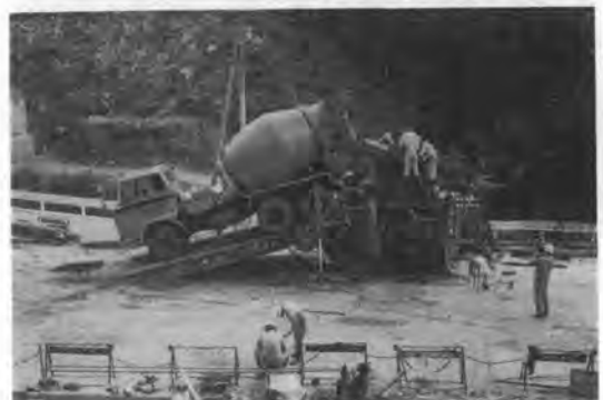
写真-3 生コン投入状況
