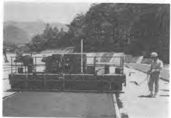
写真-16 フラットローラ
