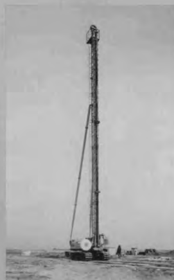
◆OV, PVCドレーン打設機
