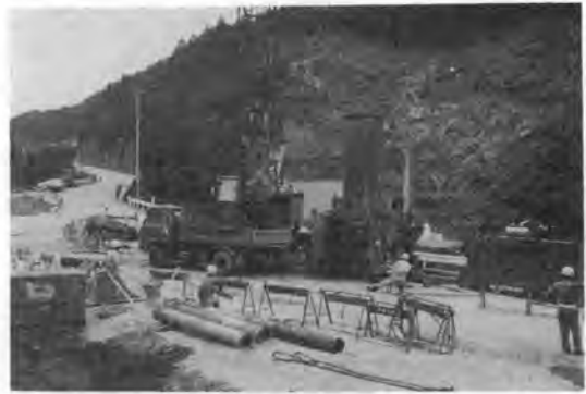
写真-4 施工状況
