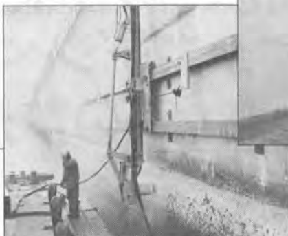
岸壁ハツリ作業
