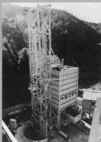
◆立坑開削および本坑ずり 搬出設備
