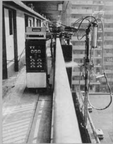
⇨ 自走式手摺壁外面吹付ロボット
