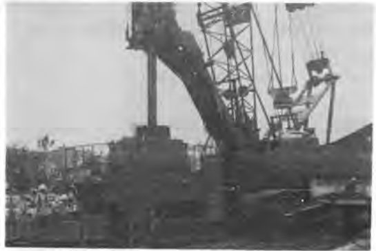
写真-1 掘削状況 (アースドリルでの中掘り作業)
