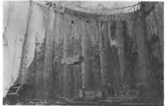
写真-1 オープンコラム工法による立坑
