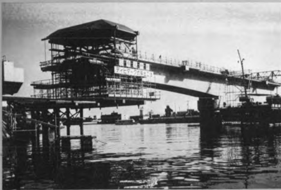
⇨ CBS 工法による PC 橋
