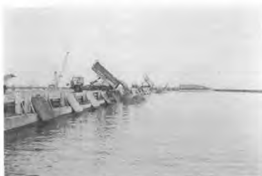
写真19 浮棧橋埋立工法
