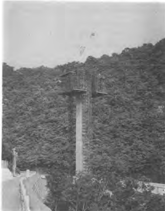
写真-1 中筋第1橋
