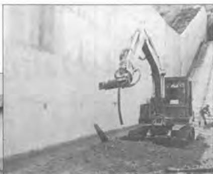
コンクリート壁削り
