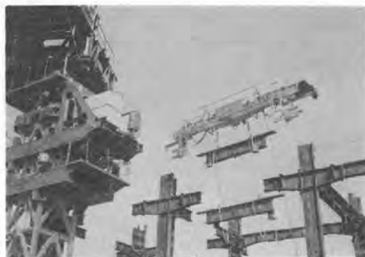
写真20 鉄骨建方装置
