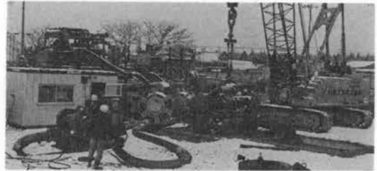
写真-3 掘削状況
