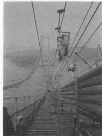
写真-1 エアスピニング作業
