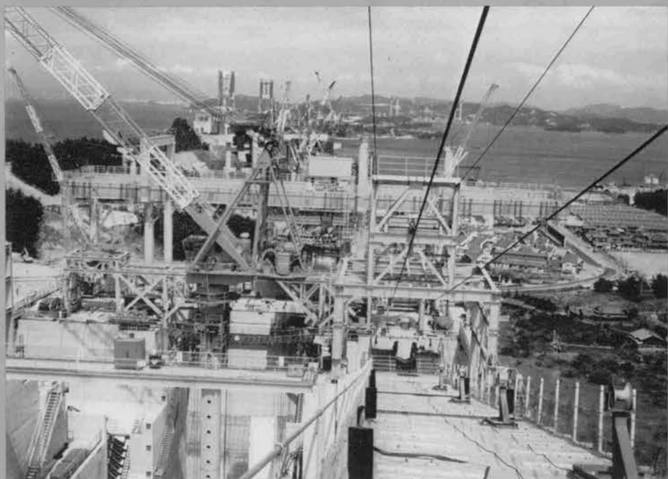
◆アンカレイジ部におけるストランド引出し設備
