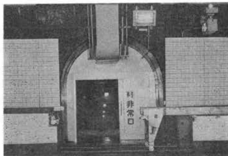
写真—1 避難連絡口部移動橋
