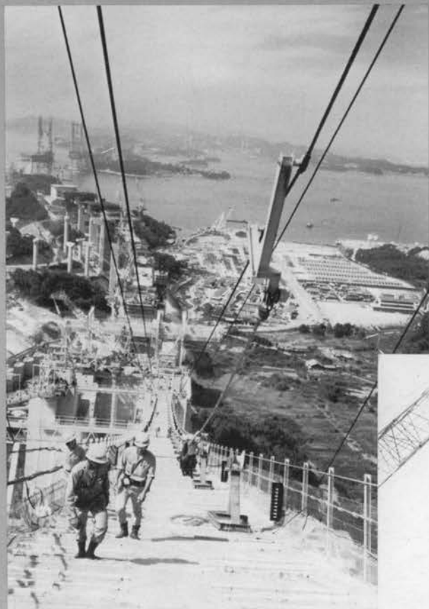
Ⓐ キャリヤによるストランドの引出し
