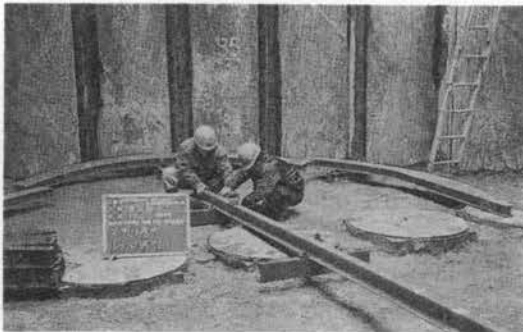
写真一 台車用レールの据付
