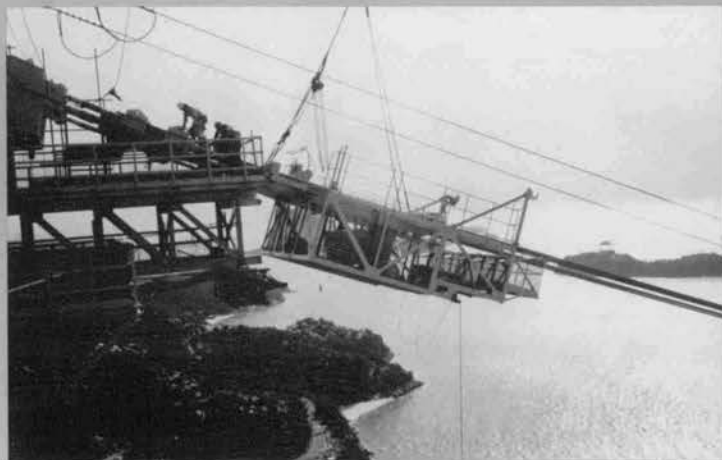
キャットウォーク床組◆ 架設用台車の架設
