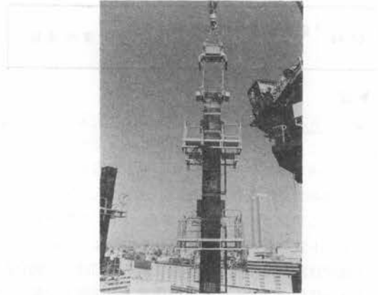
写真-1 鉄骨建方オートクランプシステム
