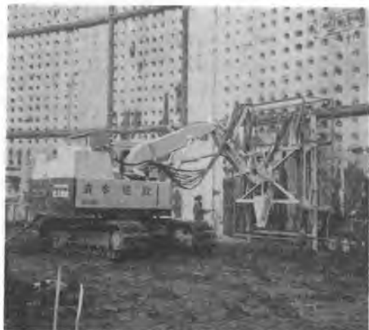
写真-1 自動壁面目荒し施工状況
