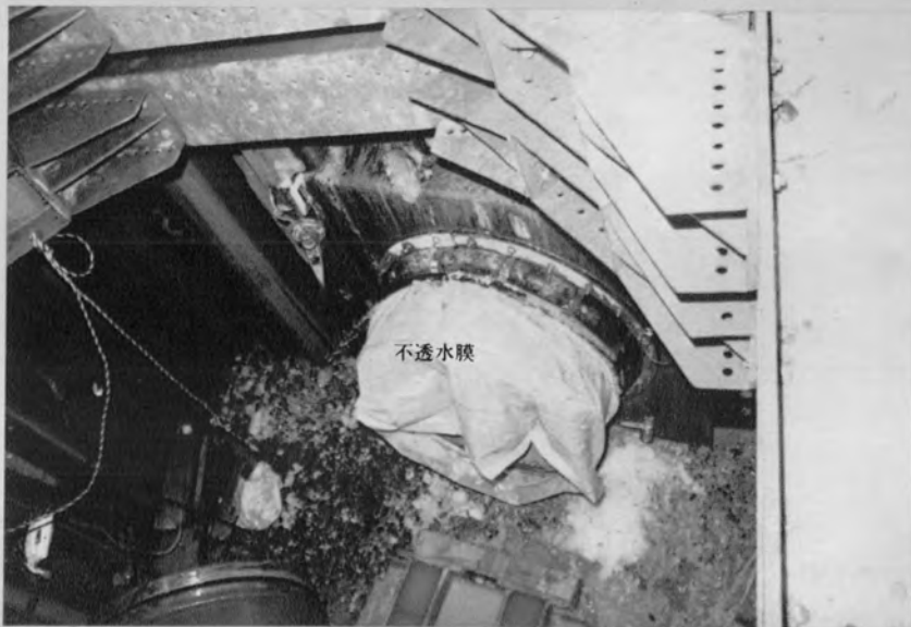
⇨到達立坑での不透水膜 （推進工法）
