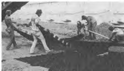
写真-3 ジオウェブの打設
