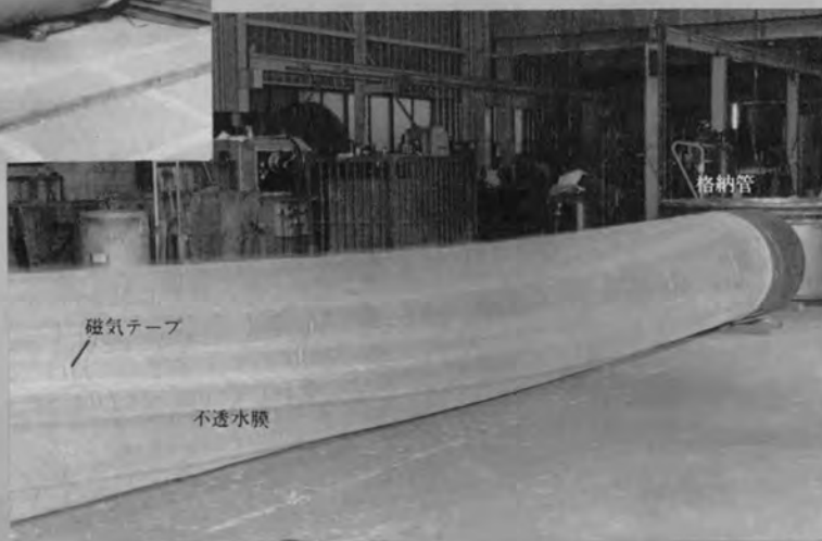
不透水膜の引出し（推進工法）⇨
