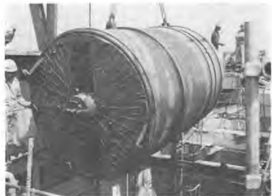
写真-2 マシンつり込み状況
