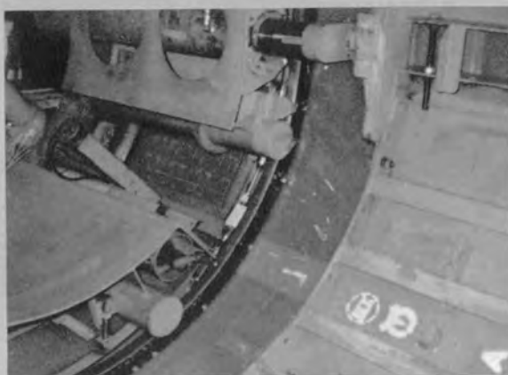
被膜装置（シールド工法）⇨
