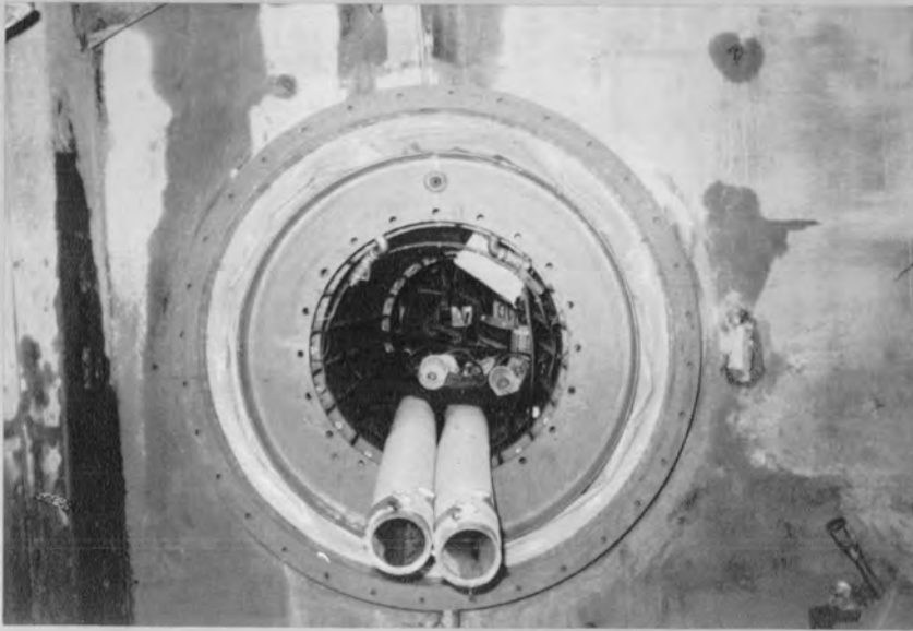
⇨不透水膜（坑口膜）取付け （推進工法）
