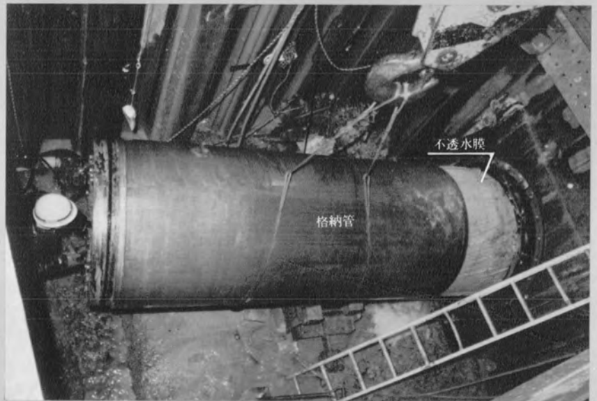
到達立坑での格納管取出し⇨ （推進工法）
