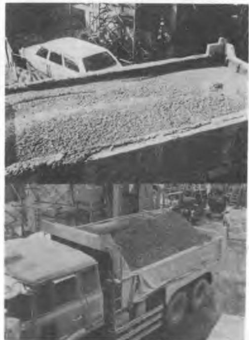
写真-1 ダンプへの積込状況(上:加泥注入,下:消泡土)
