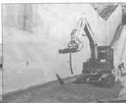
コンクリート壁削り
