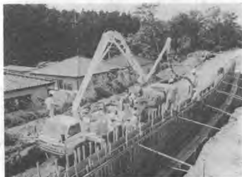
写真-8 石川島 IPH 30 B-1N 13 コンクリートポンプ車
