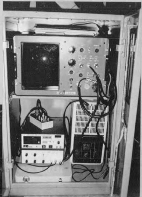
⇨ 後続台車（右側ボックスに崩壊探査装置が入っている）
