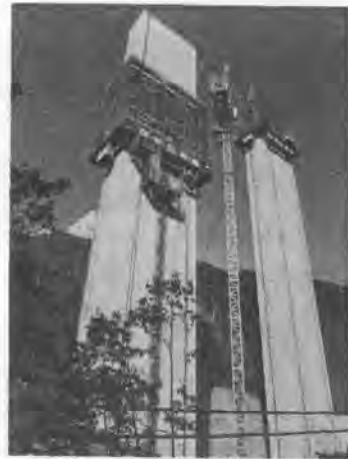
写真一 施工状況
