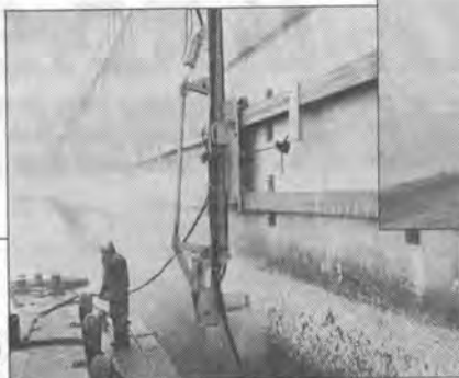
岸壁ハツリ作業
