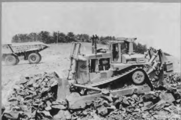
ブルドーザ 86t 級による リッピング後の集土作業
