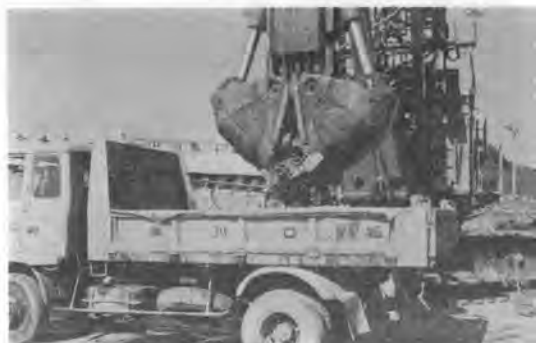
写真-5 爪シェルと掘削状況
