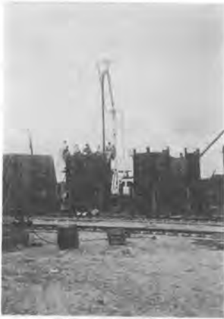
写真-2 短管の製作
