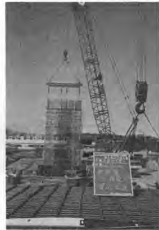
写真-7 金網取付け状況
