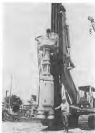
写真-1 小型アースオーガのリーダに装着した MACH-100 R
