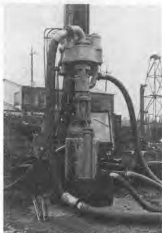
写真-5 リバース給気、排気ホースの接続
