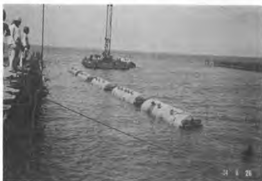
写真-6 長管の曳航
