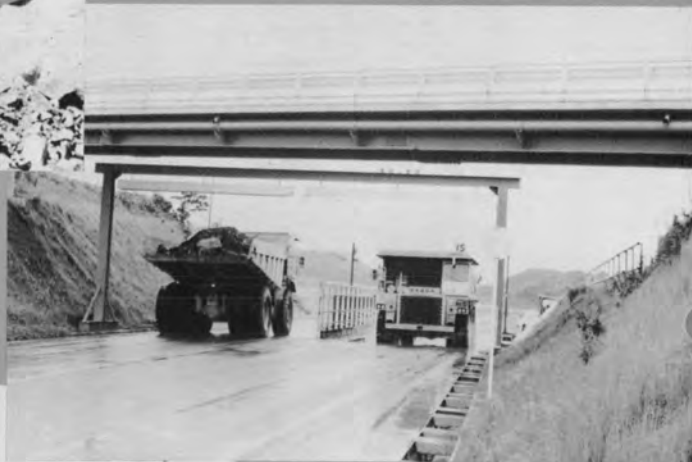
⇨捨土運搬作業 (45tダンプトラック)
