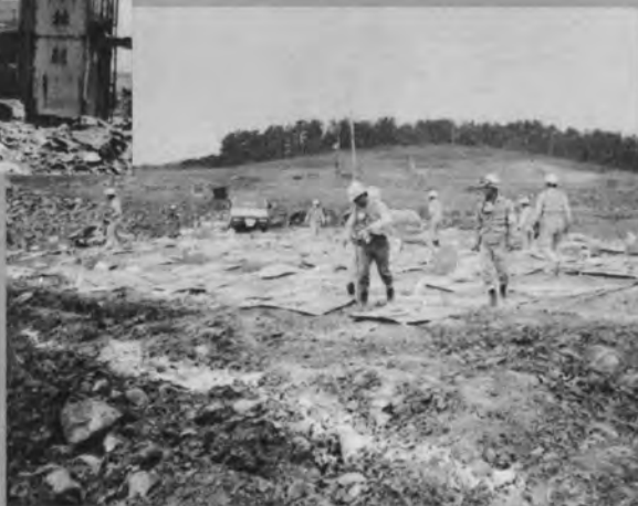
装乗作業 (1孔当り 3号桐ダイナマイト) 100g + ANF \bar{o} 袋詰 750g 2本
