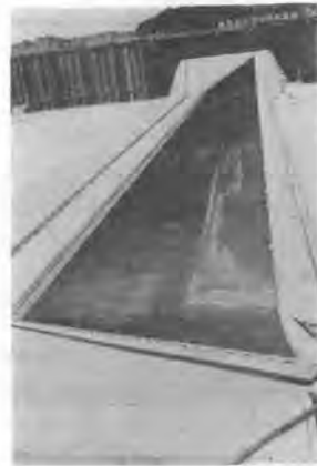
写真-5 袋体据付状況(右岸ゲート)
