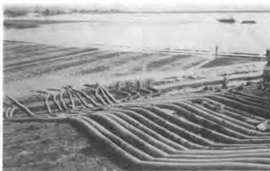
写真-9 吉田川（鹿島台町）の減水と排水
