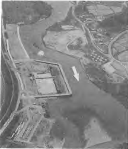
写真-1 第1期工事
