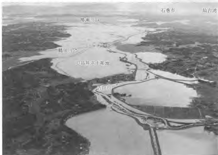
写真—1 吉田川の氾濫（上流より鳴瀬川合流点方面を望む）
