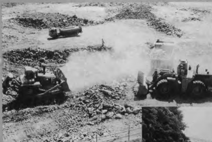
⇨大型重機の組合せ作業 （86t級ブルドーザ+10.3m 3 級ホイール ローダ+45t級重ダンプトラック）
