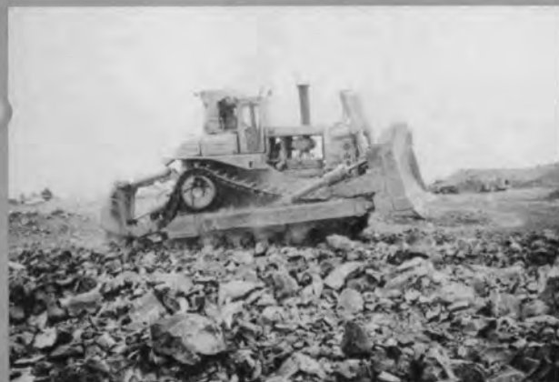
86t級ブルドーザによるリッピング作業
