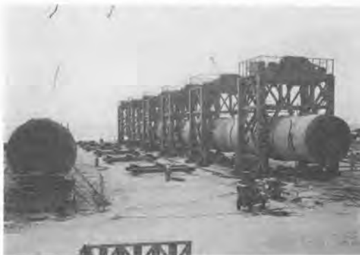
写真-4 100 t 門型クレーン 6 基による長管のつり上げ
