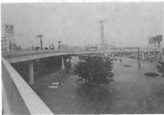
写真-2 仙台市内冠水状況(国道45号)
