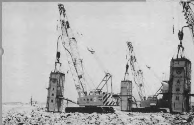
大型ロックブレイカによる砕岩作業
