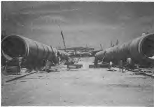
写真-3 長管の製作ヤード
