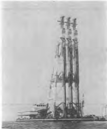
写真-2 海上施工機全景
