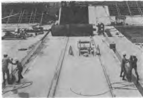
写真-4 袋体展張状況
