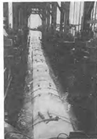
写真-5 長管の進水
