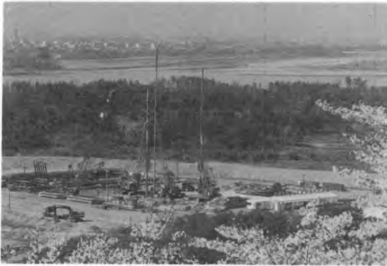
写真-3 現場全景
