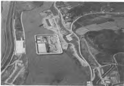
写真-2 第2期工事
