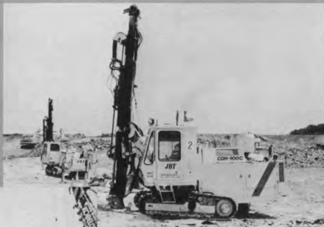
全油圧クローラドリル、 せん孔長 3.0m で施工中
