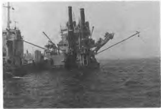
写真-3 スパッドキャリッジ装置
