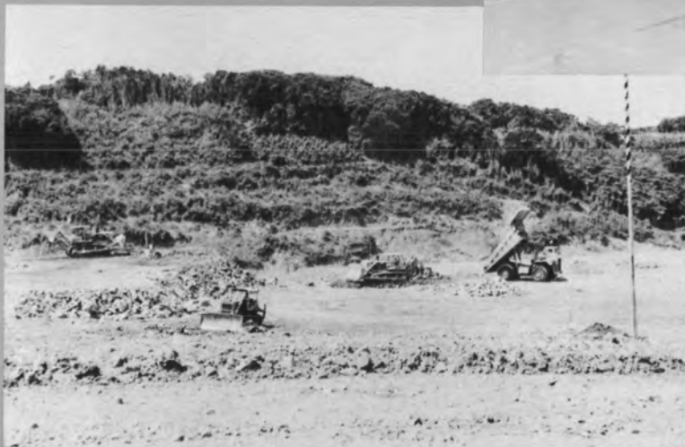
⇨土捨場での45t級ダンプ トラックによる捨土
