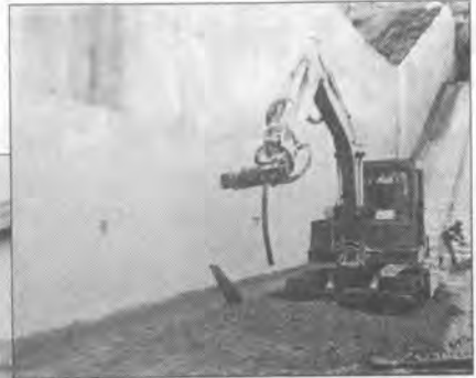
コンクリート壁削り
