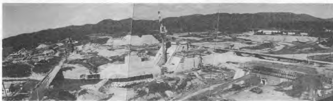
写真-1 現場全景
