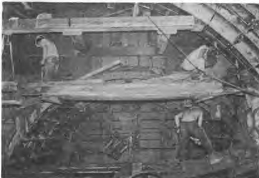
写真-2 シールドチャンパー施工状況
