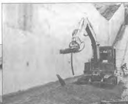
コンクリート壁削り
