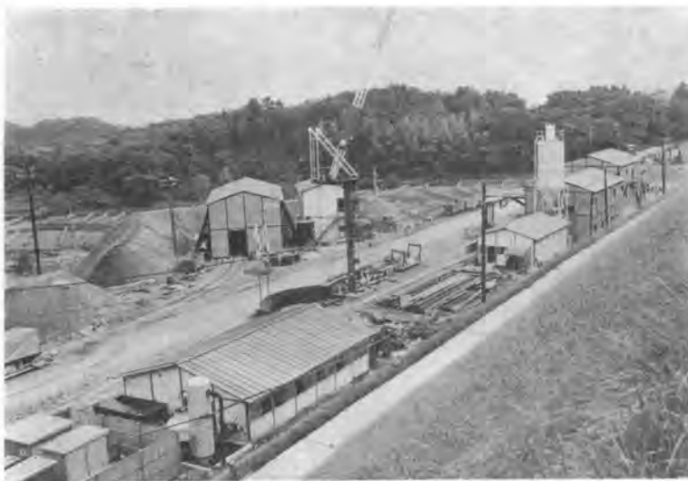
写真—1 坑外仮設備全景
