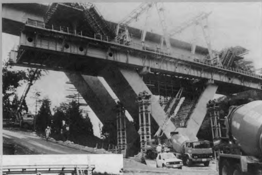
⇨ V脚斜材部の施工
