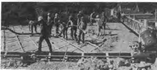
写真-1 ダイヤモンド状に配置された金属ダクト
