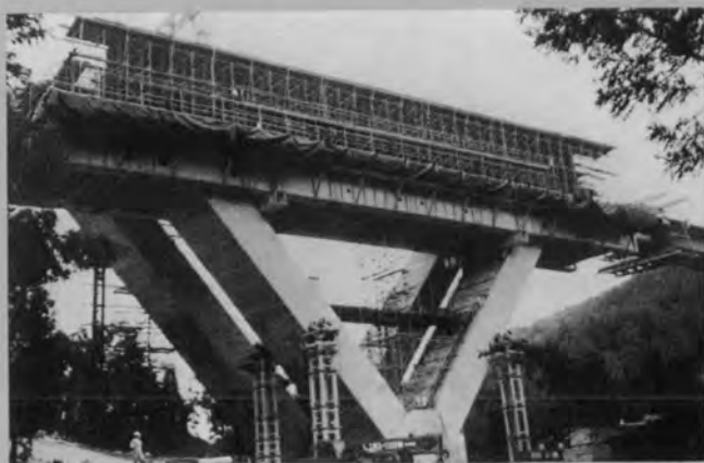
⇨ V脚柱頭部の施工
