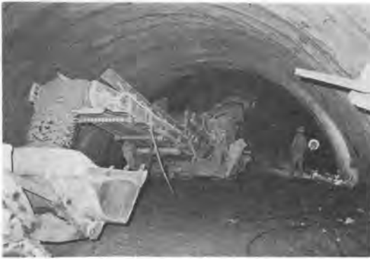
写真-2 上半掘削状況
