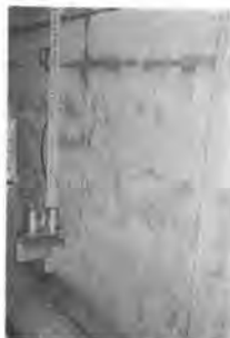
写真-9 傾斜計設置
