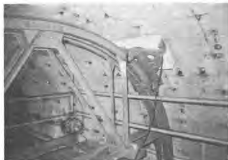
写真-6 送・受信アンテナで計測中
