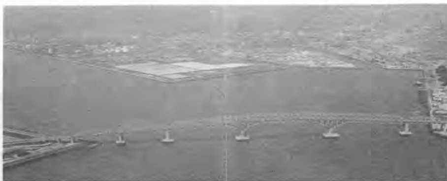
写真-2 宇部・美祢高速道路
