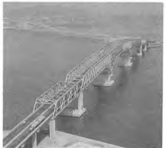
写真-1 興産大橋
