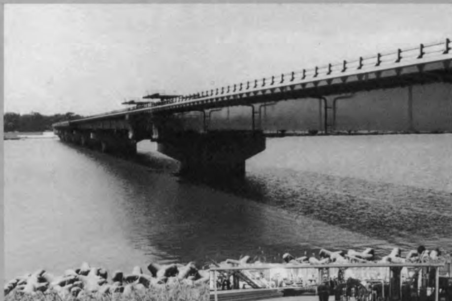
完成の真近い利根川橋
