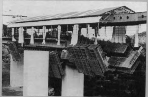
⇨ 移動支保工の移動
