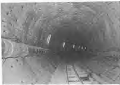
写真-2 坑内曲線部
