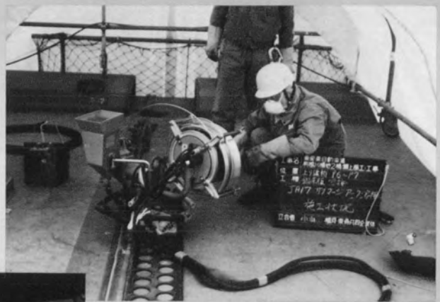
⇨鋼床版のサブマージアーク溶接
