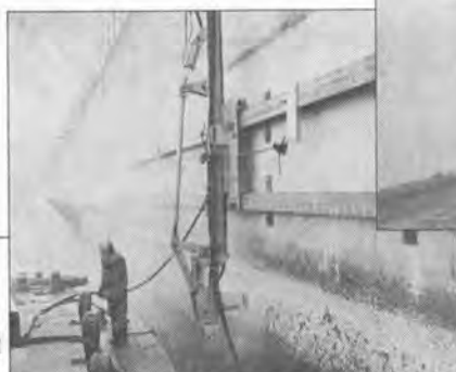
岸壁ハツリ作業
