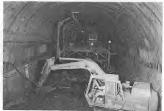
写真-3 大背掘削状況
