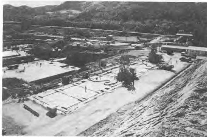
写真-6 連壁掘削中
