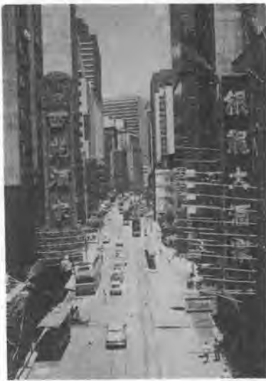
写真-1 ステーショントンネル地上部
