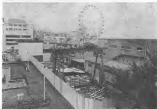
写真-1 現場全景
