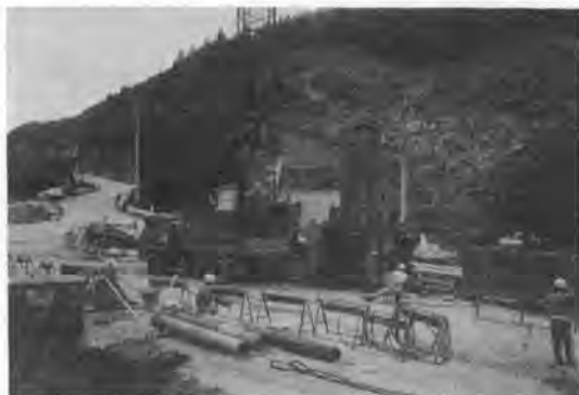
写真-4 日立 CD 1500 回転式ケーシングドライバ
