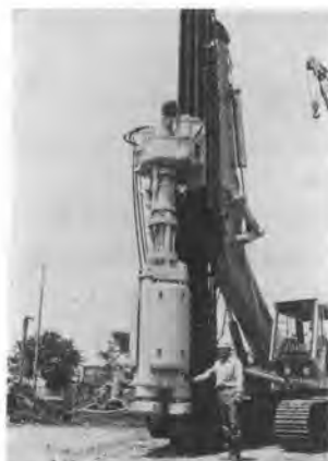
写真-3 利根マッハ工法用ウォータエアハンマドリル
