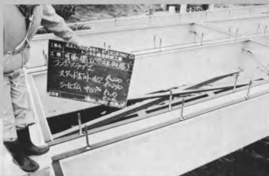
⇨プレキャストスラブのためのスタッド ホルト、シールゴムを設置する
