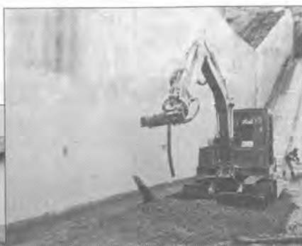
コンクリート壁削り
