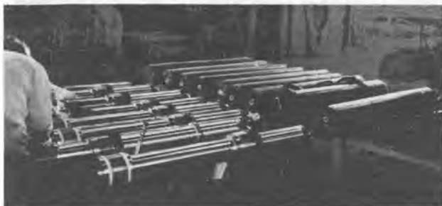
▲シールドジャッキの整備工場
