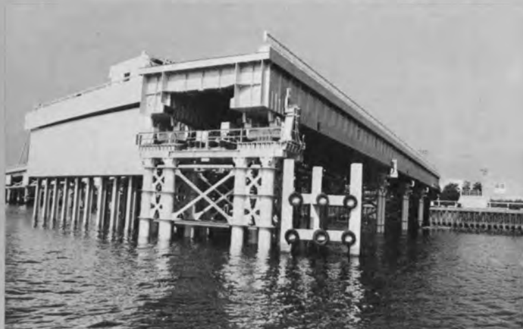
⇨閉橋時 航路から見る (左側に京浜島踊場の電波吸収体 およびP 2 ～P 5 橋脚が見える)
