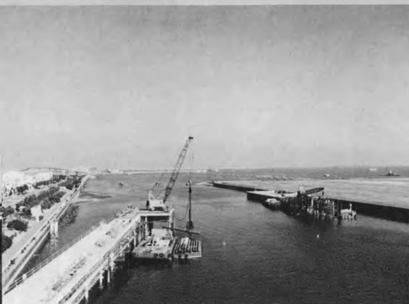
⇨京浜島側・クレーンで杭打設、羽田側・空域制限 のため昼作業なし（夜間作業のみ）
