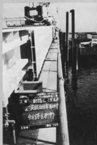
⇨電波吸収体取付 電波吸収体のすき間が1/4 波長 となっており、この間で電波が消滅する
