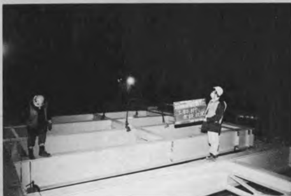
⇨80 t クレーンでブロック化 された上部桁を架設する
