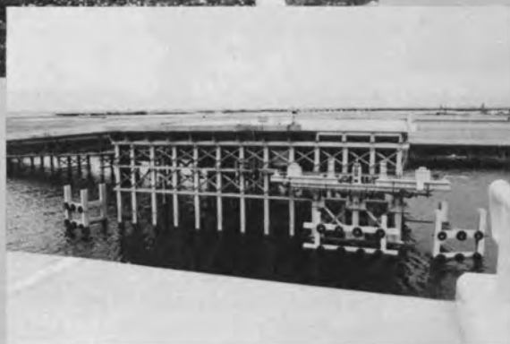
京浜島側から P 1 橋脚、羽田側踊場を見る (P 1 橋脚上に移動台、ガイドブロック、 リフトジャッキがある)
