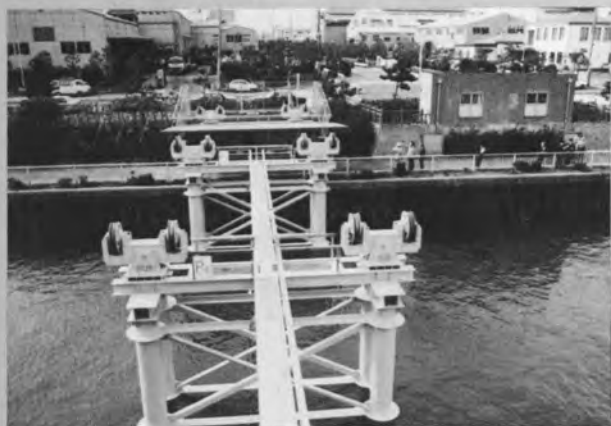
⇨閉橋時 京浜島踊場からP 4 ～P 6 橋脚を見る (橋脚上に車輪沓がある)
