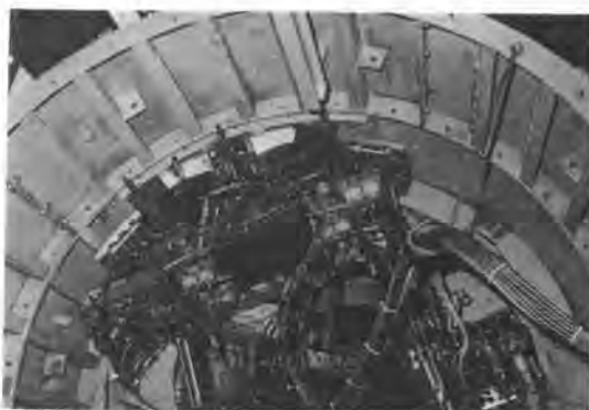
写真-3 セグメント組立状況
