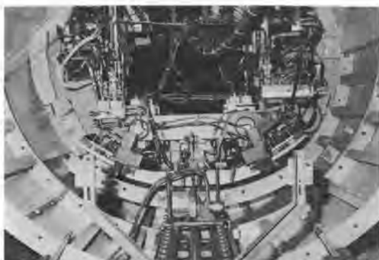
写真-1 セグメント自動組立ロボット
