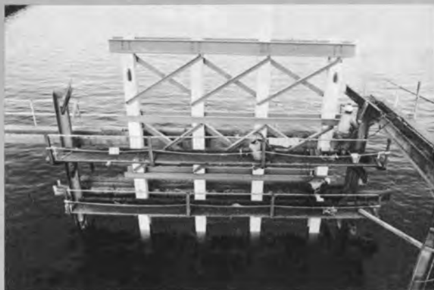
継材取付 インサイトドリルでホルト穴を開けてホルト接合する
