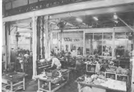
▲油圧ポンプ、モータ、バルブ整備工場
