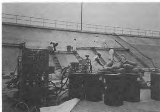
写真—7 LNG タンク防液堤斜面部吹付状況 (USA)
