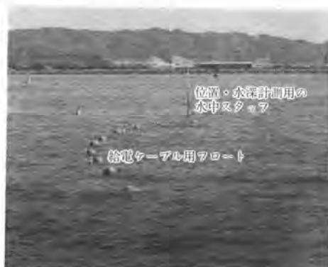
写真—4 海中施工状況
