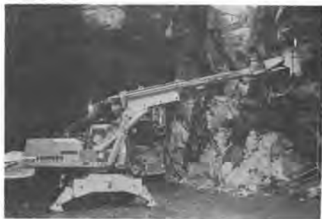
写真-2 油圧ハンマによるこそく作業
