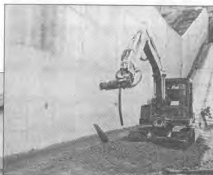
コンクリート壁削り
