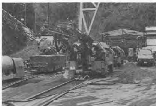
写真-1 HD-50 2ブームガントリジャンボ
