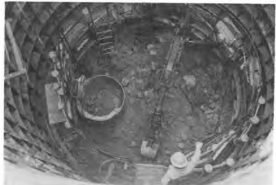
写真-3 バケットによる掘削
