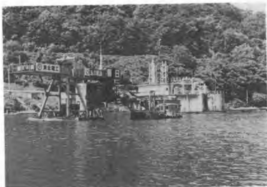
写真-1 浚渫中のグラブ浚渫船
