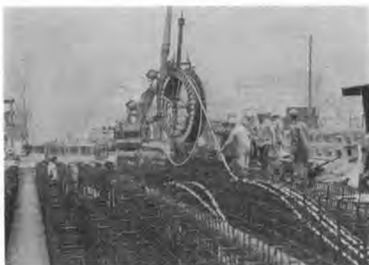
写真—4 Ulenberg 橋の施工状況
