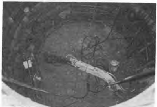
写真-4 ブレーカによる掘削
