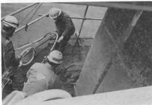
写真—6 ドルフィンコンクリートへの吹付状況
