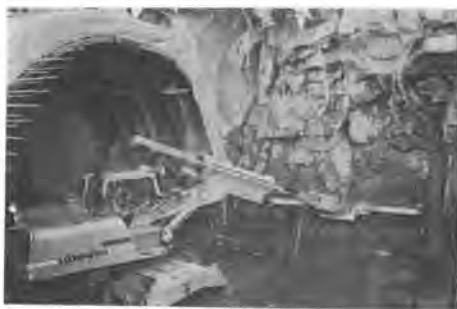
写真-3 ドリフタによるボルト穴さく孔作業
