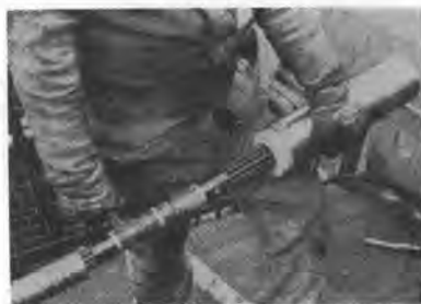
写真—5 ファイバ製テンション材 (アンカー部)
