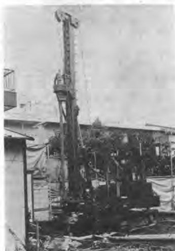
写真-10 日車 BH 杭施工機 NB-60 コンドル
