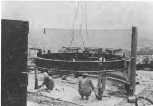
写真-2 旋回リング（現場組立中）
