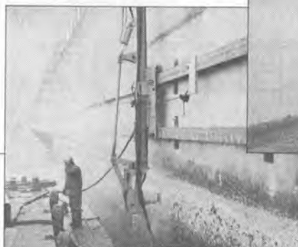
岸壁ハッリ作業
