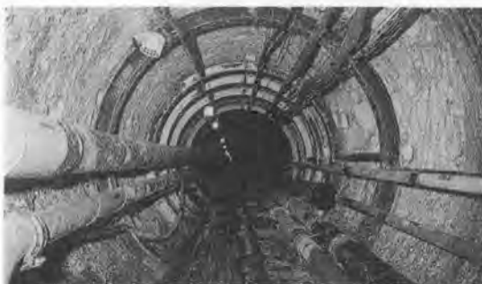
写真-2 坑内状況（リング支保工）
