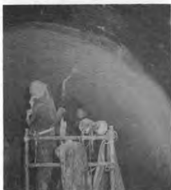
写真—4 トンネルアーチ部吹付状況
