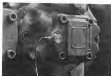
写真-1 加速度計の取付
