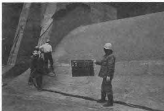
写真—5 ダム越流部吹付状況
