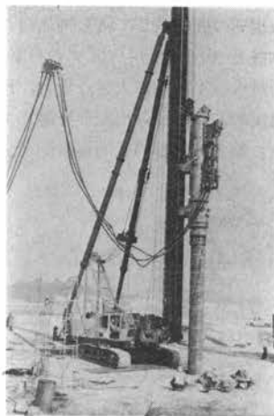
写真-4 海田大橋工事
