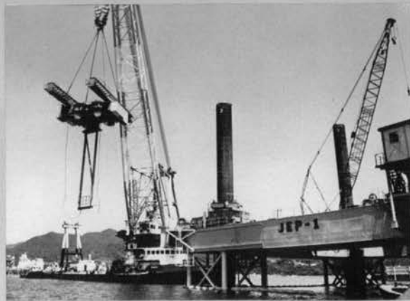
⇨2,000t全旋回クレーン船による テンプレート塔載状況
