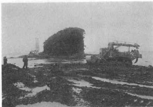
写真-2 (b) 岩浚渫状況
