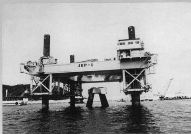
⇨フロータ取付のための 昇降状態の作業台船
