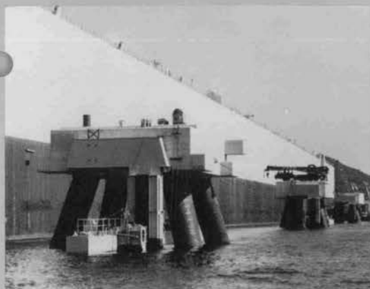
⇨ 完成した海上アンカー
