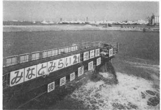
写真-4 薄層散布状況
