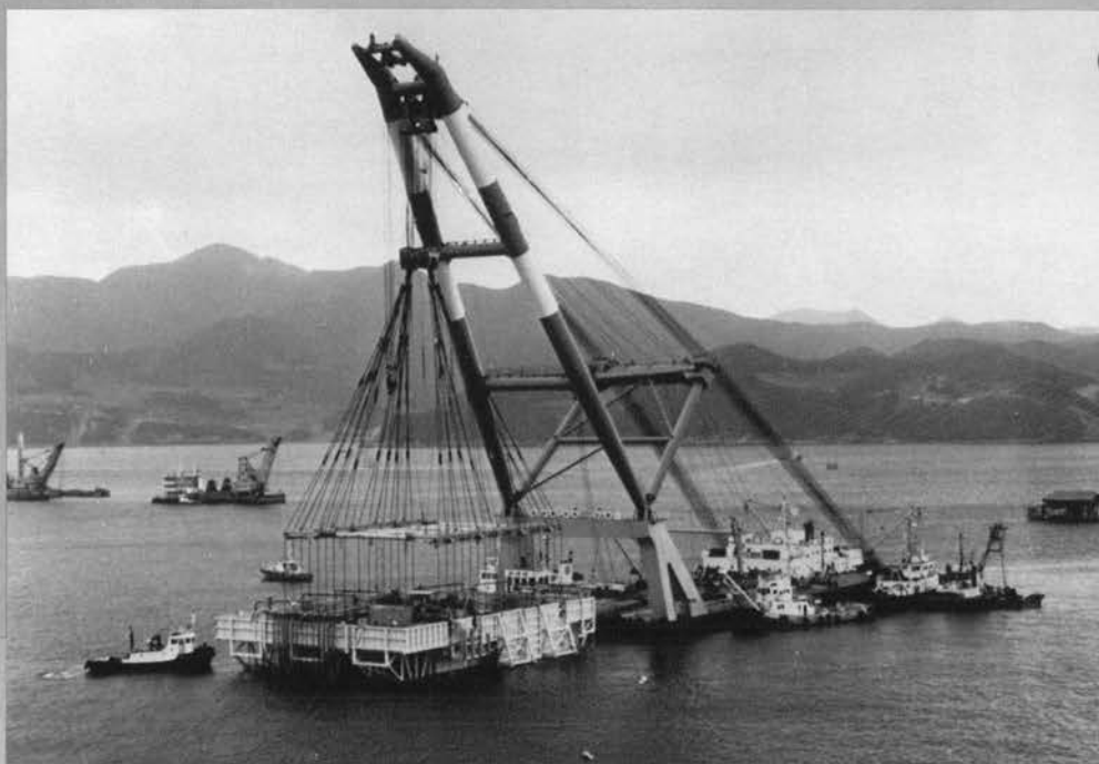
⇨荷役ケーソンドルフィン本体据付状況
