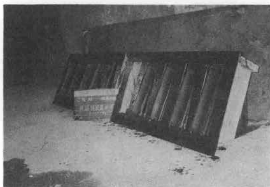
写真-4 型枠設置状況
