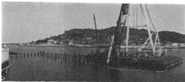
写真-3 中電小野田カーテンウォール工事
