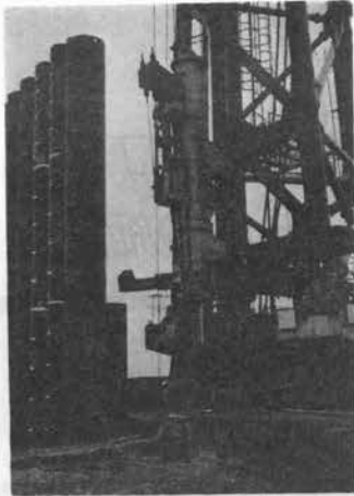
写真-5 広島マツダ埋立岸壁工事
