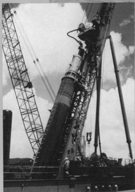
⇨メンク MRB 1500 による 鋼管杭打込み
