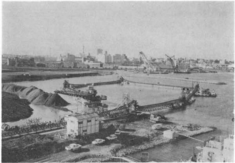
写真-3 FCS 稼働状況
