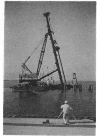
写真-4 斜杭の建込み
