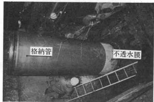
写真-1 到達立坑での格納管取出し
