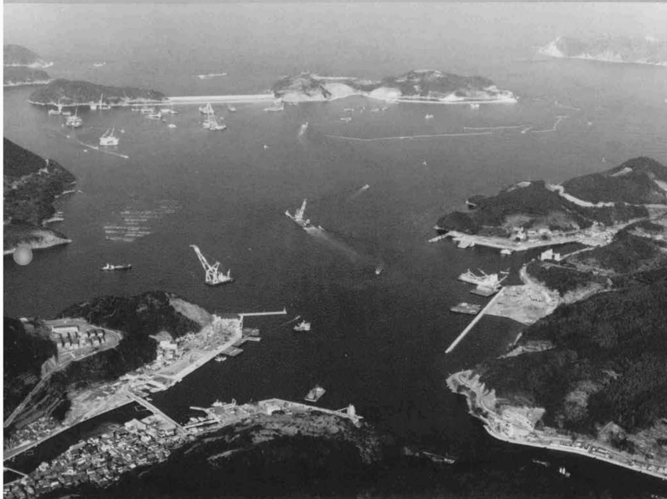
⇨ 施工中の基地の全景
