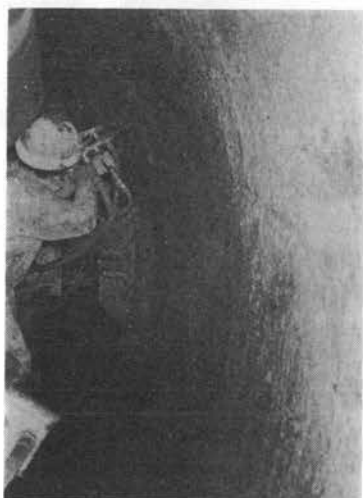
写真-1 TBM カッターヘッド直後の施工状況
