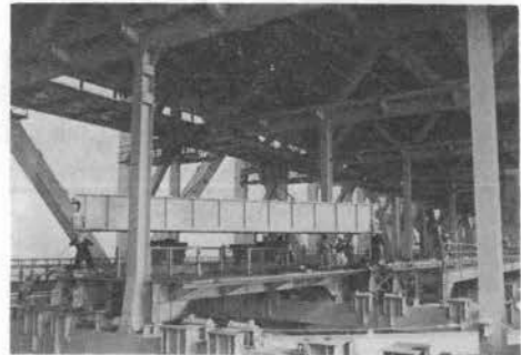
写真-15 鉄道桁架設状況 (IB, 昭和 61 年 4 月)
