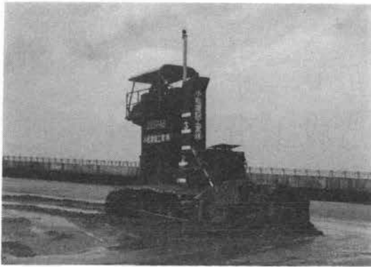
写真-1 試運転状況（陸上）
