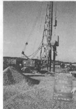
写真-4 GCP 打設状況
