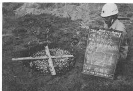
写真-6 GCP 杭出来形状
