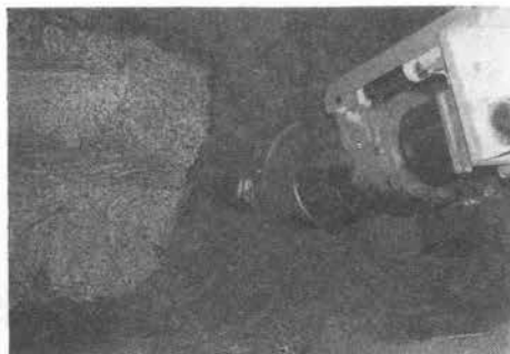
写真-3 中硬岩（花崗岩）切削状況
