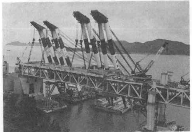
写真-8 11 パネル架設状況 (HB, 昭和 60 年 9 月)
