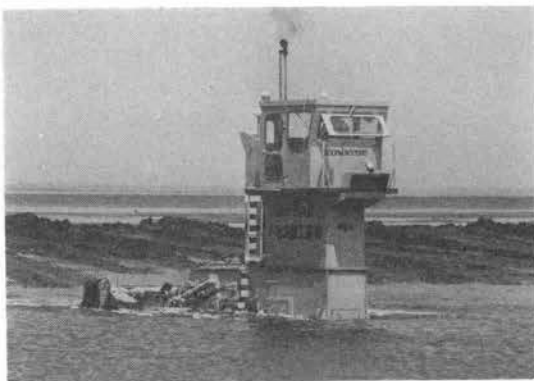
写真-8 掘削押土
