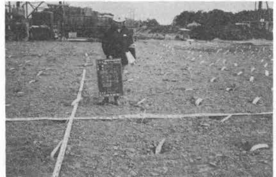
写真-9 PD 打設後状況
