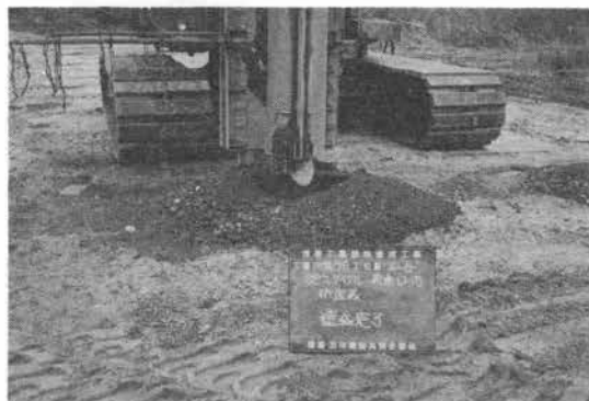
写真-5 GCP 杭造成完了状況
