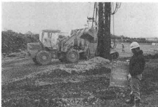
写真-7 GCP 施工機への砕石投入
