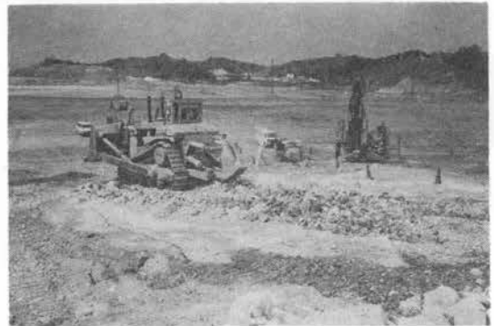
写真—6 空港造成工事2次破碎状況
