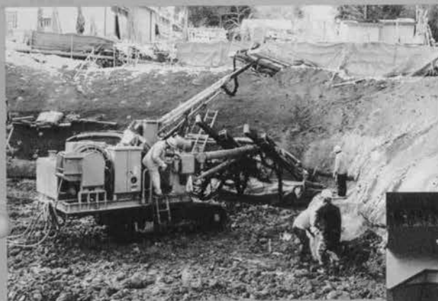
⇨2ブームクローラジャンボによる ロックボルト孔のさく孔
