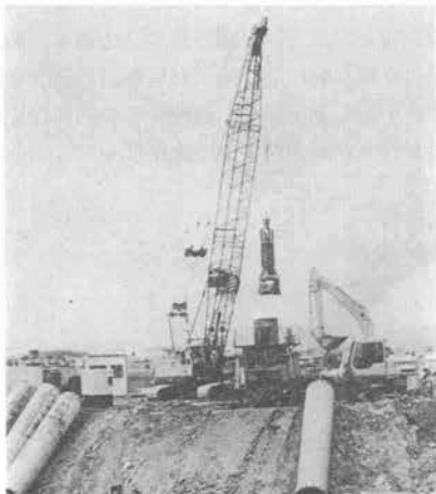
写真-6 日立 CD 1500 回転式ケーシングドライバ
