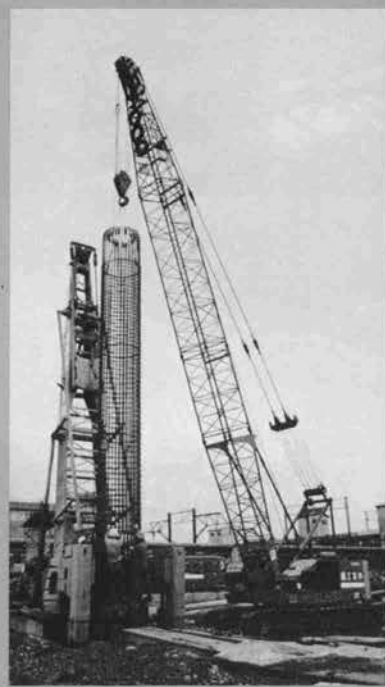
⇨クローラークレーンによる場所打 RC 杭の鉄筋かご建込作業
