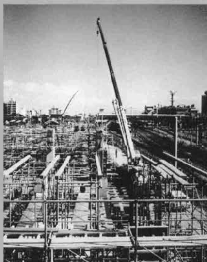
⇨高架橋、梁、スラブ部の 型枠・鉄筋工、荷役作業
