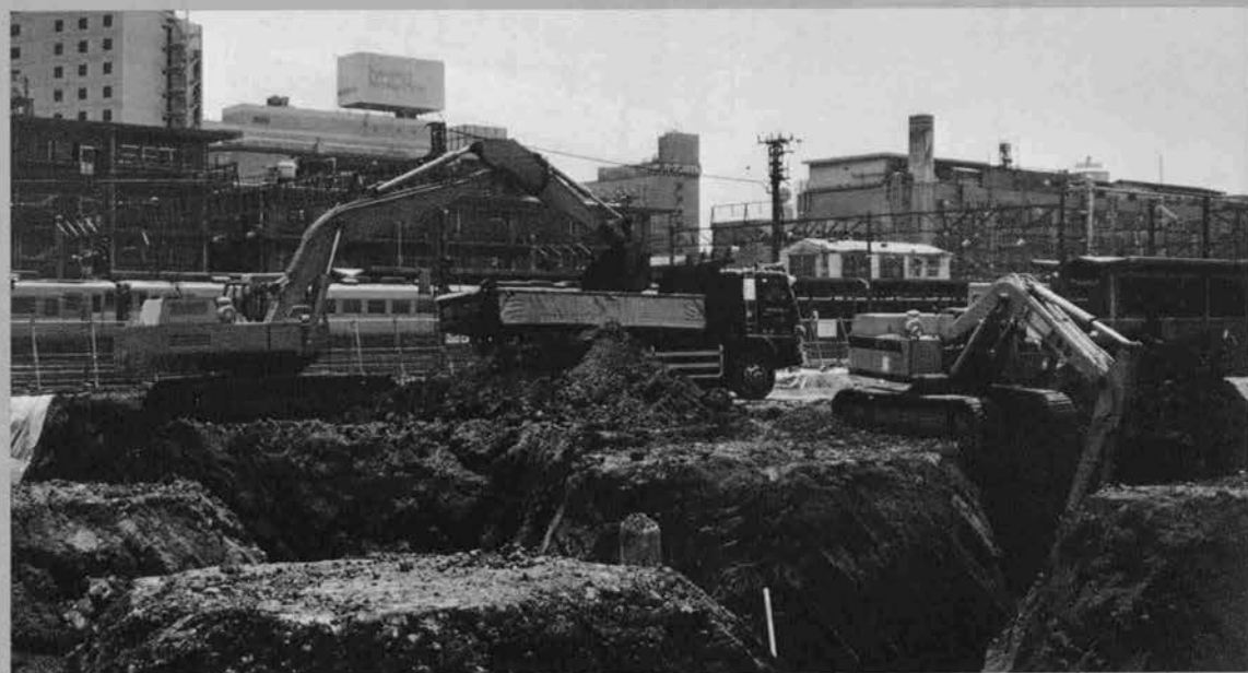
⇨高架橋基礎掘削，運搬作業
