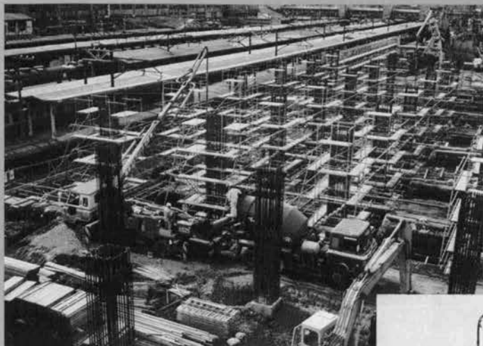
⇨コンクリートポンプ車による 駅部高架橋基礎コンクリートの打設
