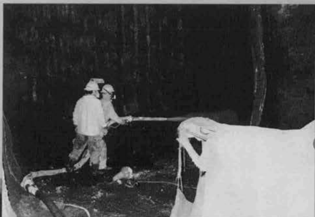
⇨コンクリート吹付工
