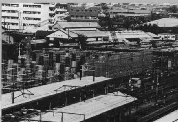
⇨クライミングクレーンとクロー ラクレーンによる高架橋、梁、 スラブ部の支保工、型枠・鉄筋 工、荷役作業
