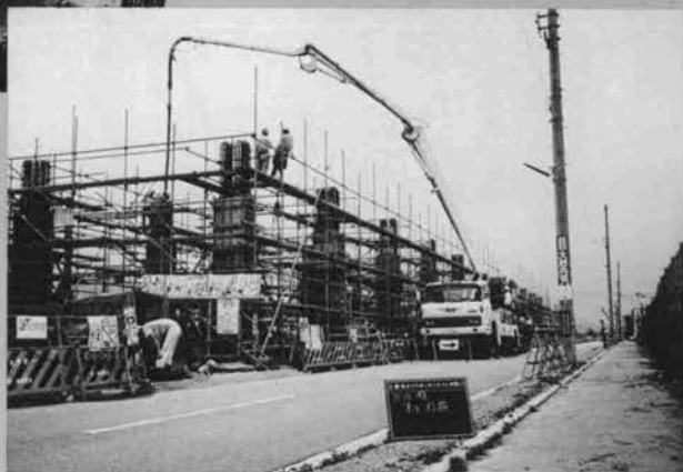
コンクリートポンプ車による ⇨高架橋柱コンクリートの打設
