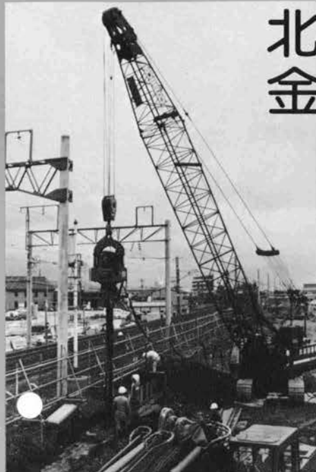
⇨パイプハンマによる 鋼矢板の打込作業
