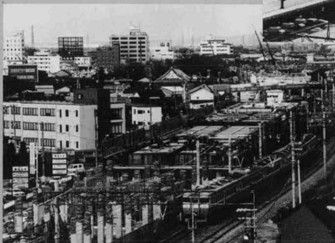
⇨高架橋、梁、スラブ部施工状況
