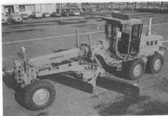
写真-2 2枚ブレード除雪グレーダ
