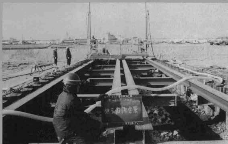
◆ 高圧噴射改良施工状況
