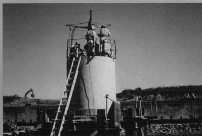
◇ PC 鋼棒緊張状況
