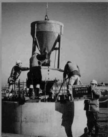
◇ 中詰コンクリート打設状況
