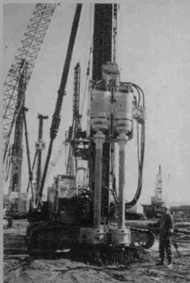
◆ CDM 施工状況
