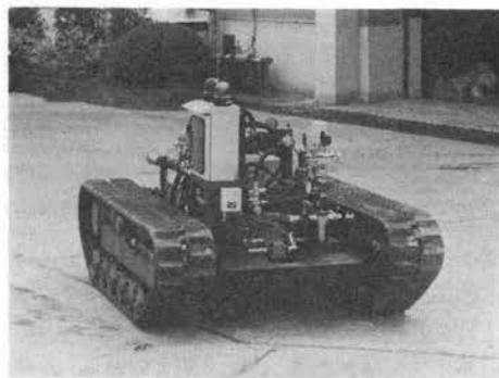
写真一8 遠隔操縦草刈車実験装置
