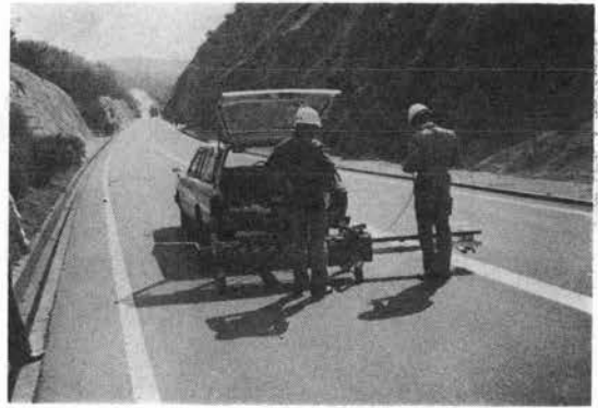
写真-1 現場での計測状況
