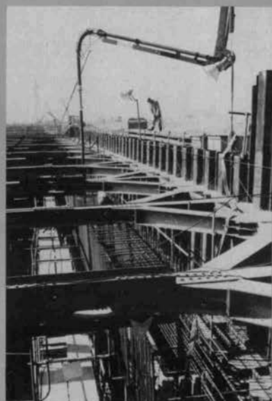
◆ アクセス道路コンクリート打設状況
