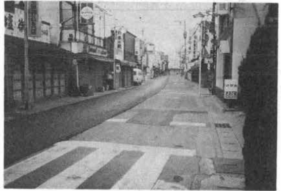
写真-2 施工前後の路面状態
