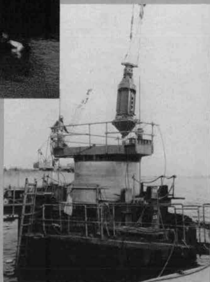
◇ PC ウェル内掘削状況
