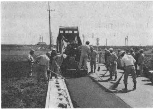
写真-1 ミニリベパと仕上り面
