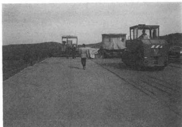
写真-2 アスファルトフィニッシャによる路盤材料の敷ならし (右・通常のスクリード、左・ハイコンパクションスクリード) (西独フェーゲル社提供)
