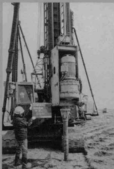
オーガによる先行さく孔状況
