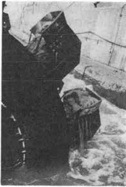
写真-1 掘削状況 (供試土砂B) (ホイール式)
