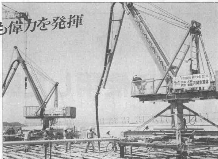
(本四架橋現場設置例)
