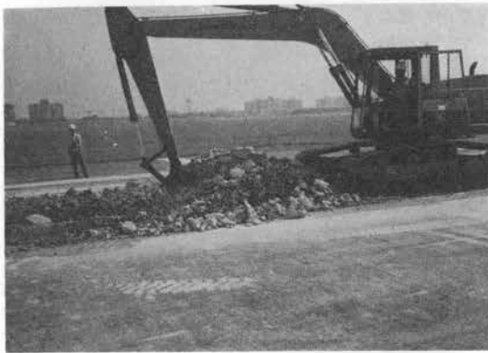
写真-4 破碎したコンクリートの掘削
