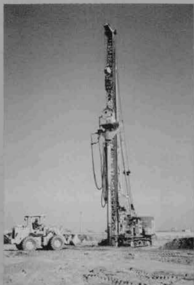
◆サンドコンパクション施工状況
