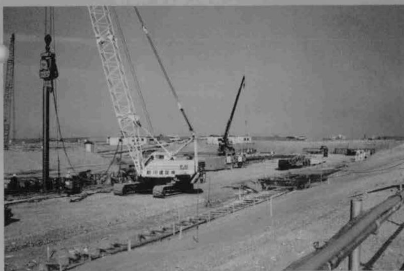
◆ シートパイル打設状況
