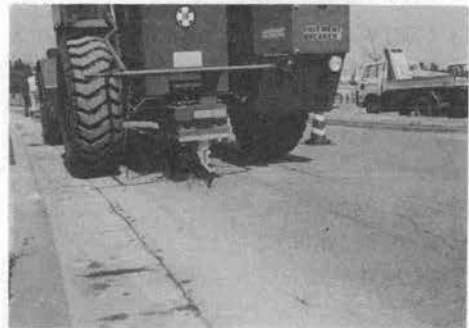
写真-5 アスファルト舗装のナイフing
