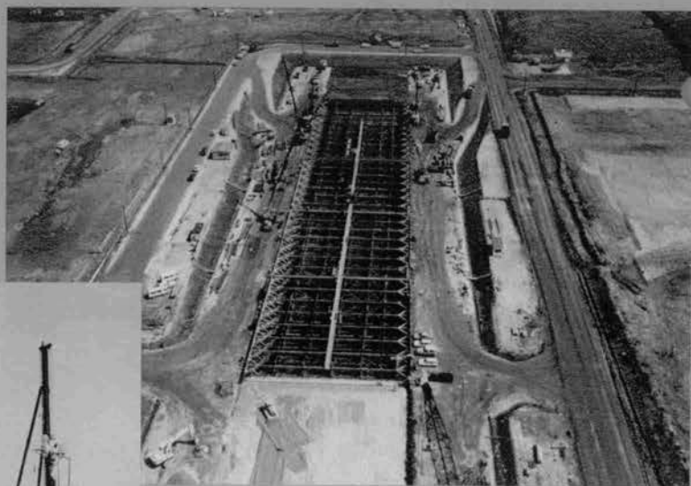
アクセス道路山留工事状況
