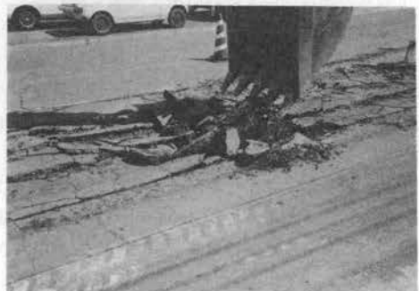
写真-6 ナイフingしたアスファルト舗装の掘削
