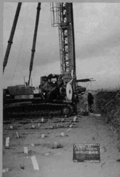
ベーパードレーン打設状況
