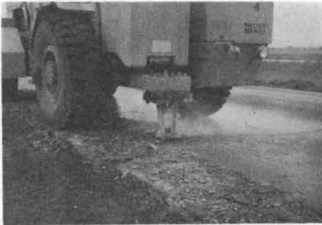
写真-3 コンクリート破碎中の PB-4
