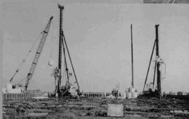
ケミコバイル打設状況
