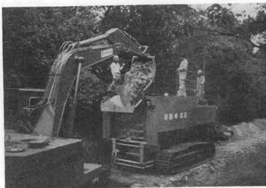
写真-7 ハードベース FRB 工法における 2 次破碎
