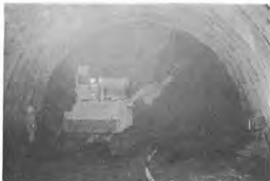
写真-2 吹付ロボット
