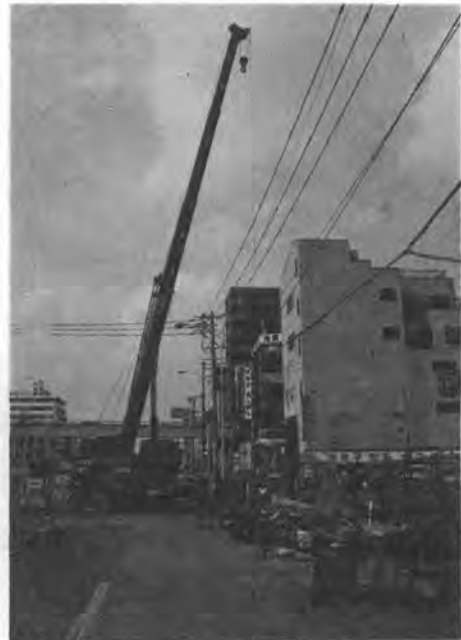
写真-2 躯体据付状況
