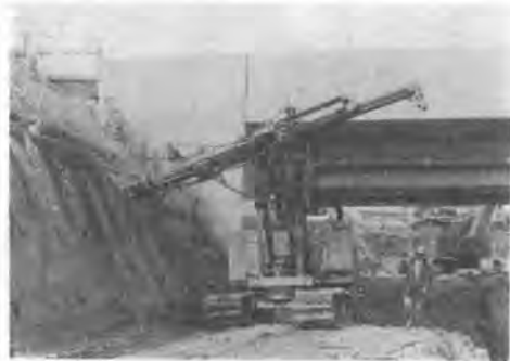
写真-2 打設状況
