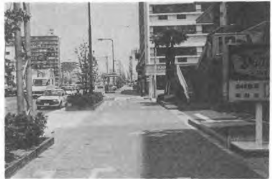
写真-1(b) 工事完成後
