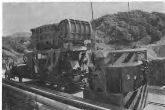
写真-4 全自動コンクリート運搬台車
