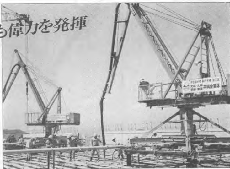
(本四架橋現場設置例)
