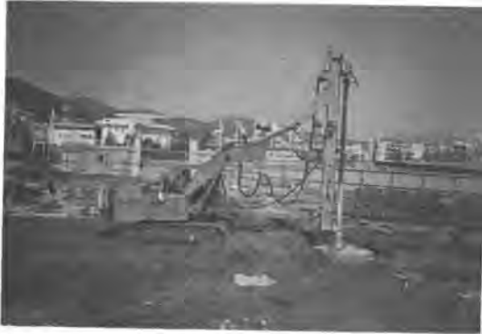
写真-12 杭頭処理機械
