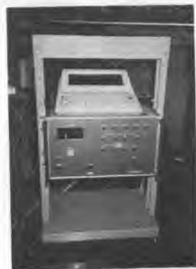
写真-7 簡易型クレーン衝突防止装置制御盤
