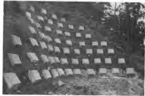
写真-1 型枠方式
