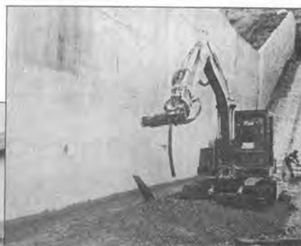
コンクリート壁削り
