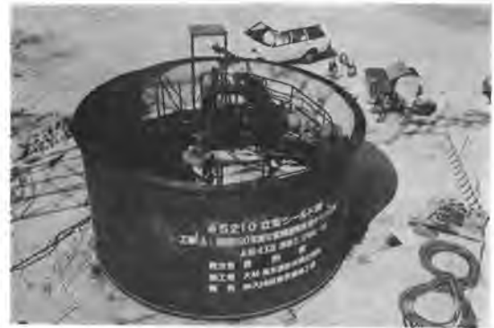
写真-20 半機械掘り立て型シールド機
