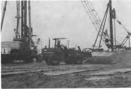
写真-14 稼働中のランバローダ
