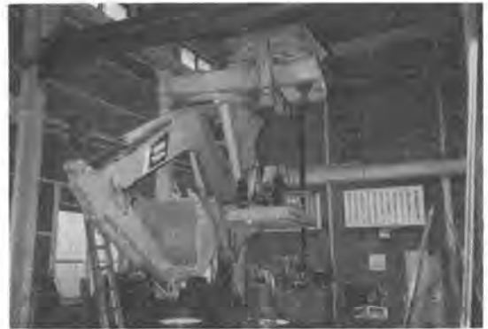
写真-3 立坑ずり積機 (シャフトローダ)
