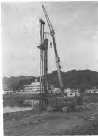
写真-10 二軸式深層地盤改良機 (DMH 20)
