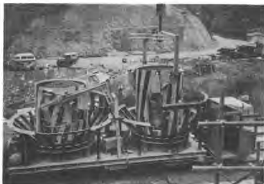
写真—22 バケットつり替え作業無人化システム
