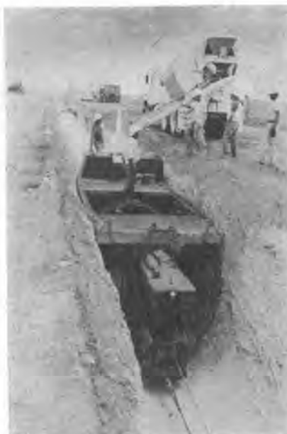
写真二 本装置はウインチを搭載、アンカーからワイヤを介し、移動する
