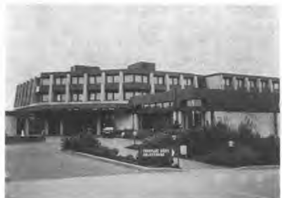
写真-1 建設労働安全研修センター (西ドイツ・ハーン市)
