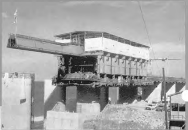
⇨大型移動支保工による施工⇨
