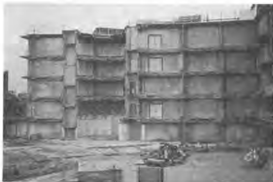
写真-1 K-ジェットシステムによるビル切断風景
