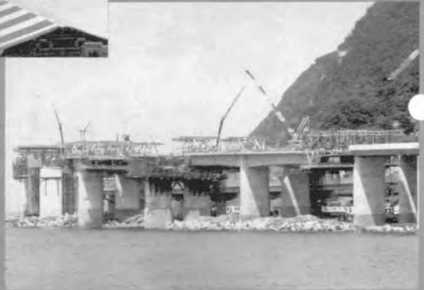
⇨張出し施工状況（新潟側）⇨
