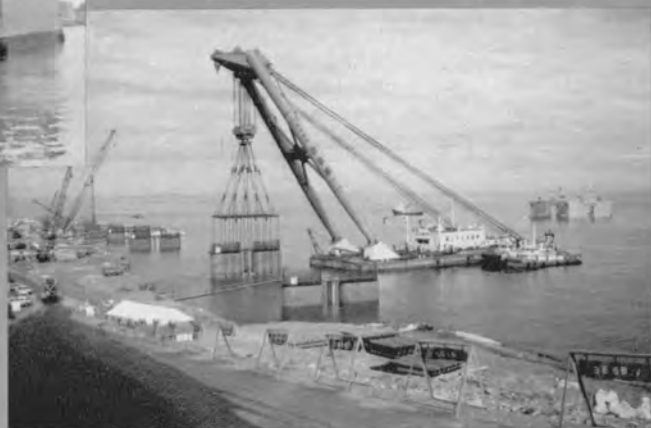
◇1,300 t FC による浮力を利用した据付
