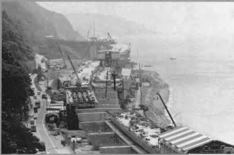
⇨IC 部上部工施工状況
