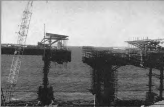
⇨仮支柱を用いた張出し施工（新潟側）
