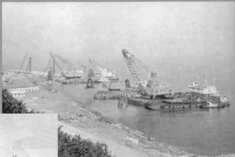
◇グラブ船による海中掘削
