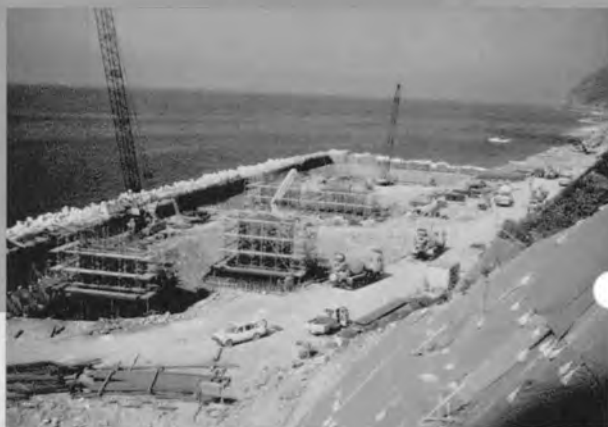
仮締切によるオープン掘削工法での構築⇨
