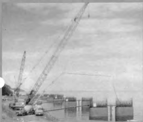
◇つり配管による注入コンクリートの打設
