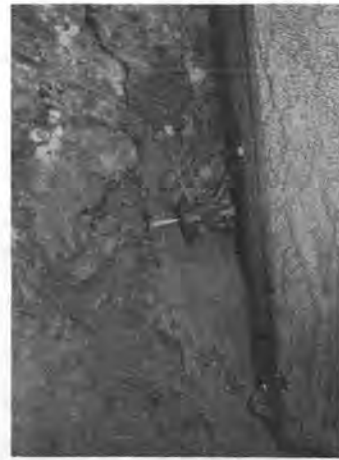
写真-5 スリット切削状況
