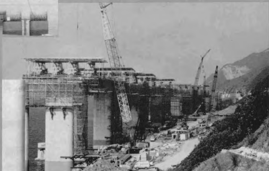
張出し施工状況◇ (富山側)
