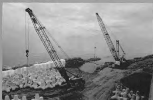
⇨仮締切堤の設置
