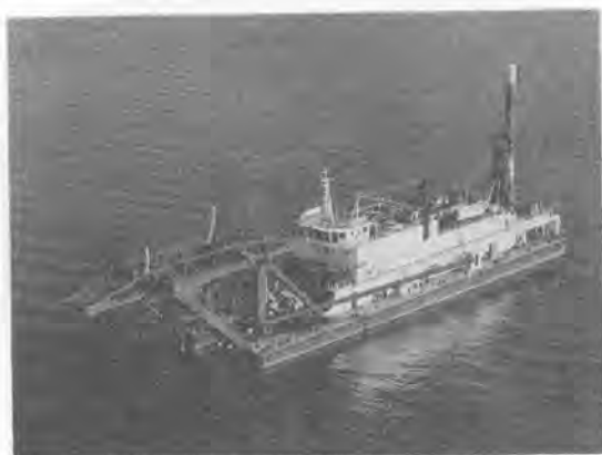
写真-12 三菱“航絞 1004”ポンプ浚渫船
