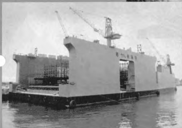
◇6,500 t FD と 5,000 t FD による フーチングの製作
