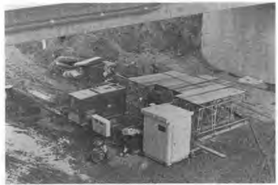
写真-3 注入プラント
