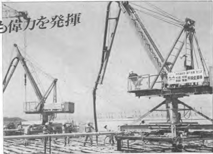
(本四架橋現場設置例)
