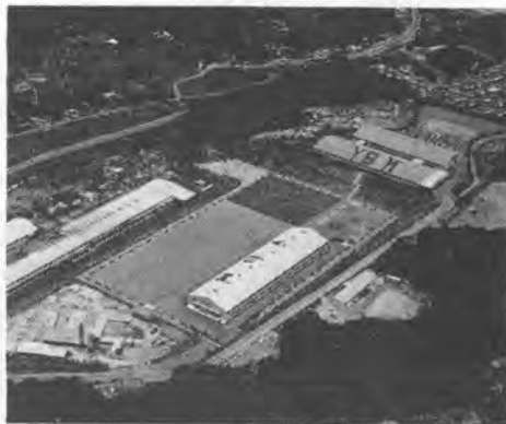
岸山工場全景
