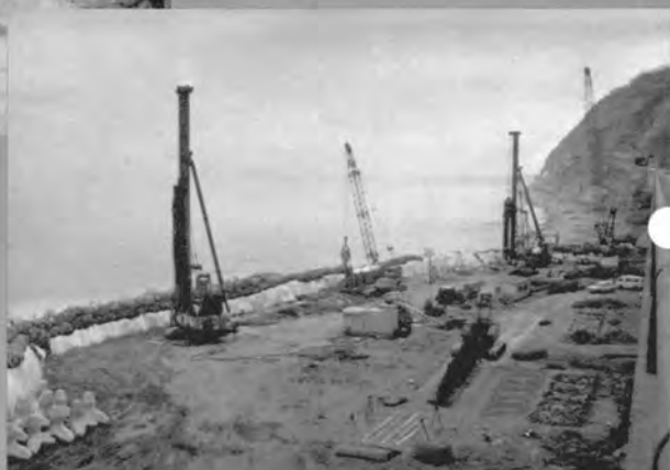
⇨止水鋼矢板（二軸同軸さく孔機による先行さく孔）の施工
