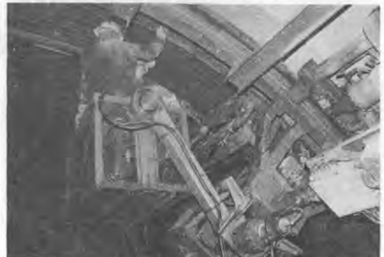
写真-5 TSL 工法施工状況
