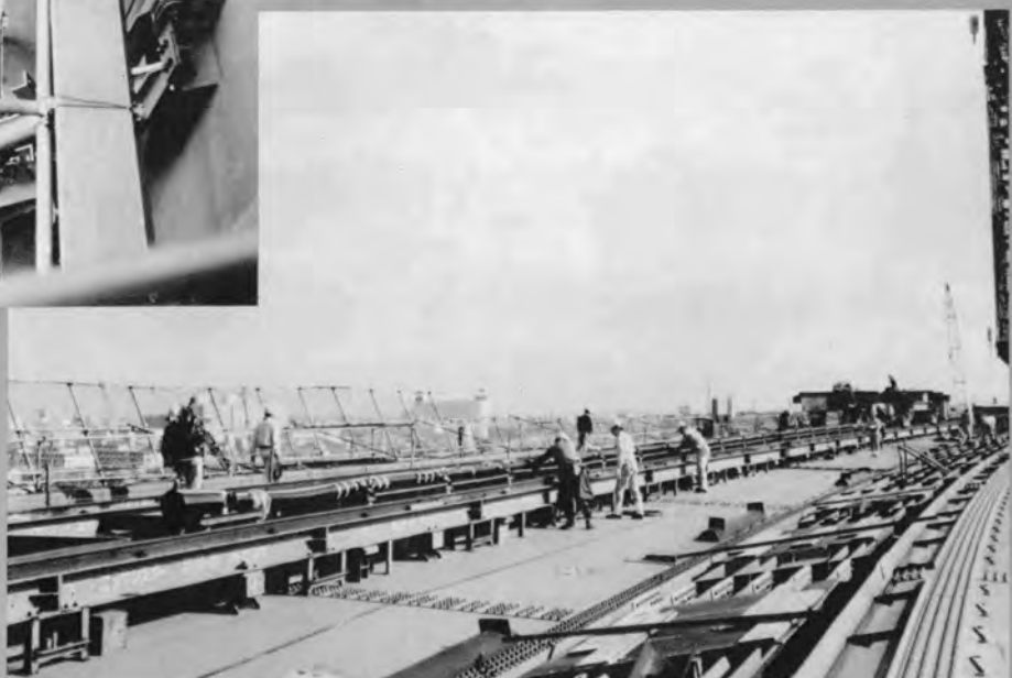
⇨ ケーブル展開後, 移動台車により前方へ移動中
