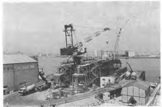
写真-6 工事現場全景
