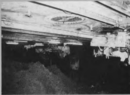
◆P37 ケーソン内機械掘削
