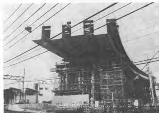
写真-2 西側送出し完了
