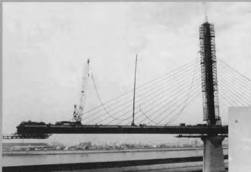
⊕ ケーブル架設 (塔頂ジブクレーン 8t)
