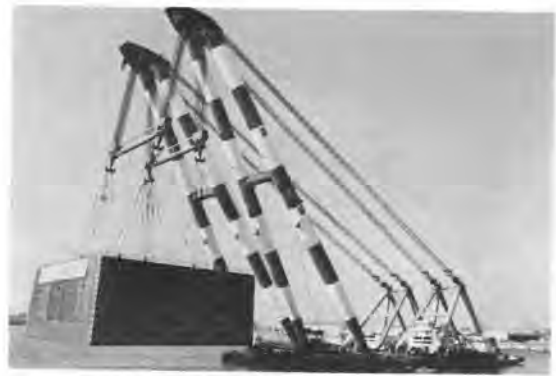
写真-2 鋼製ケーソン着水状況
