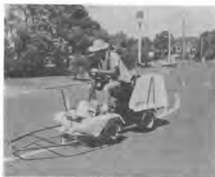
写真-1 Ridelineer の使用現場
