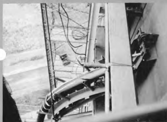
⇨ ケーブル塔側引込み中
