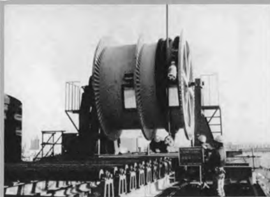
⇨ ケーブル展開準備 (ケーブル輸送リール, 展開用アンリーラ)
