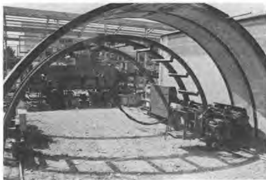
写真-1 ショットクリート形成装置 (FSD) 全景
