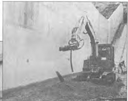
コンクリート壁削り
