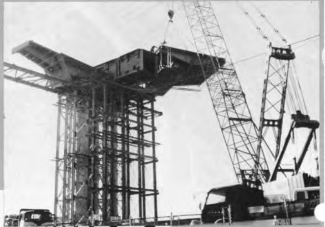
◆P36 橋脚部桁架設 (300tクローラクレーン)
