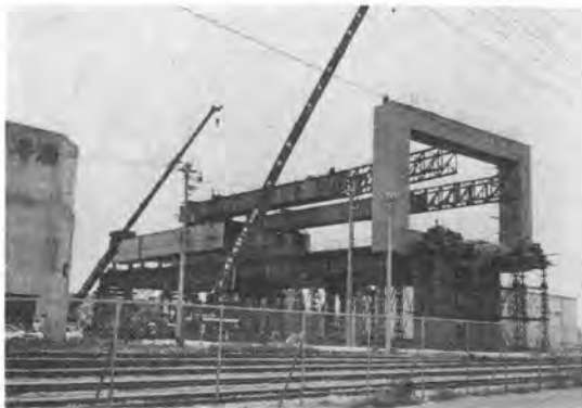
写真-2(a) JR 九州臨港線上桁送出し前
