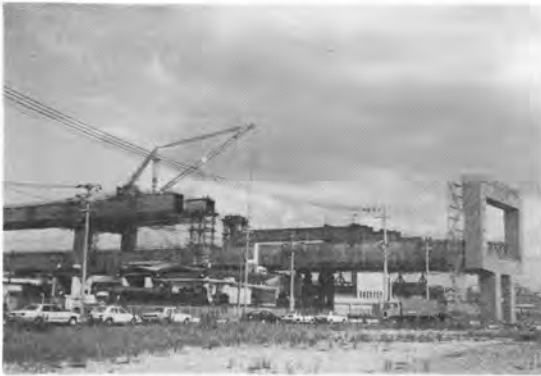
写真-4(a) 三脚クレーンによる手延機解体
