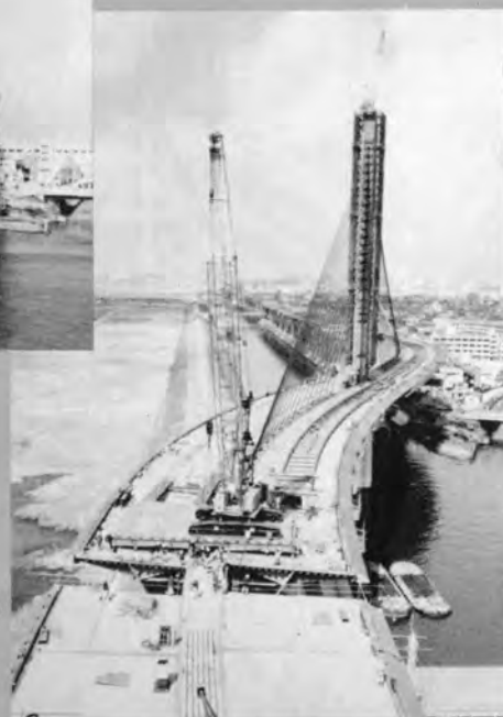
閉合ブロック架設状況 ⊕ (150tづり クローラクレーン)
