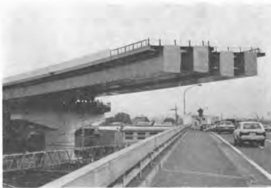
写真-1 東側送出し完了
