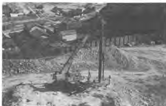
写真-2 施工状況
