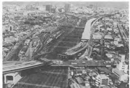
写真-3 黄金陸橋上閉合作業
