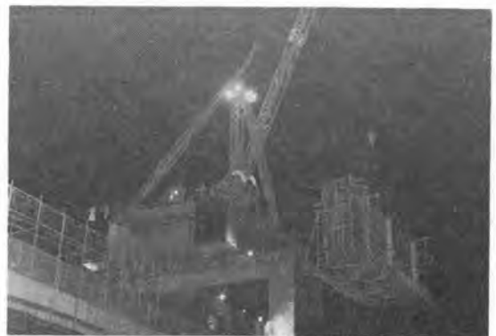
写真-4(c) 三脚クレーン工法架設
