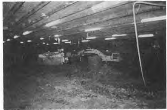
写真-5 ケーソン函内掘削状況
