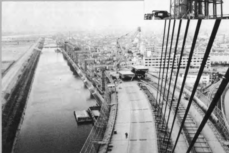
◆親塔側荷上げ設備および縦取り設備 (45tづり)三脚テリックおよび移動台車)
