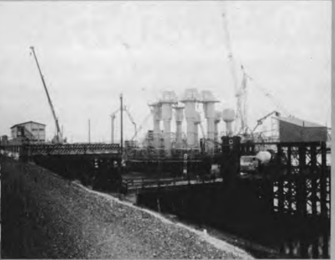
◆P37 ケーソン工事全景
