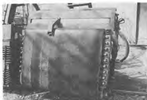
写真-2 ベルト型枠 (幅 120 cm, 高さ 85 cm)
