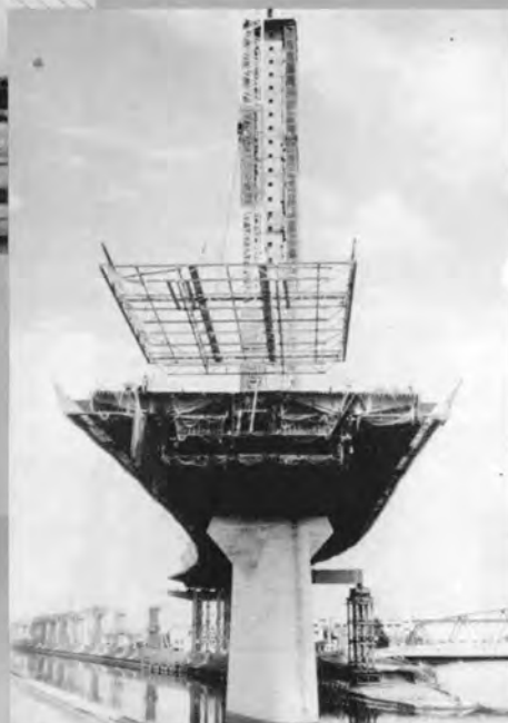
⊕ 移動足場架設中
