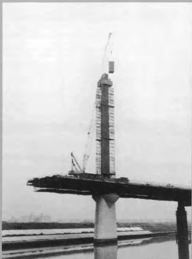
⇨ 親塔架設中 (150tクローラクレーンと現場溶接ハウス)
