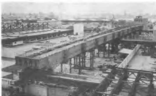
写真-1(a) 横取り前、地組完了
