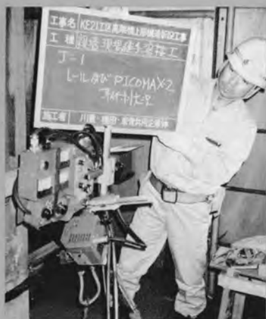
⇨ 親塔現場溶接用レールおよび溶接機
