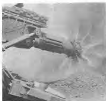
写真-2 ウォータージェット噴射状況
