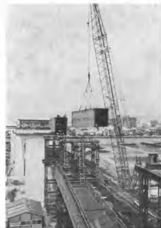
写真-3 トラッククレーンベント工法の架設
