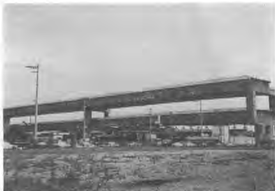
写真—5 架設完了
