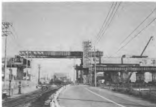
写真-2(b) JR 九州臨港線上の架設桁送出し
