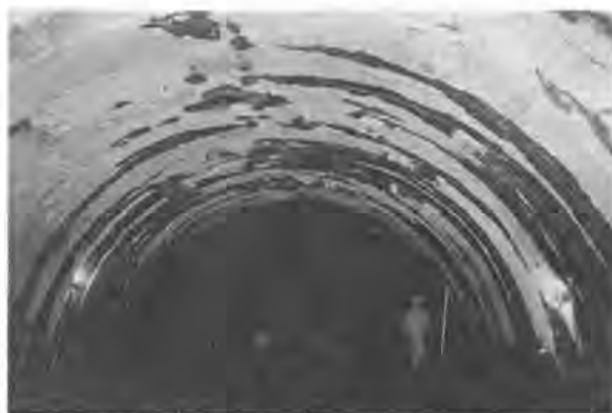
写真-6 TSL 工法による1次覆工完了
