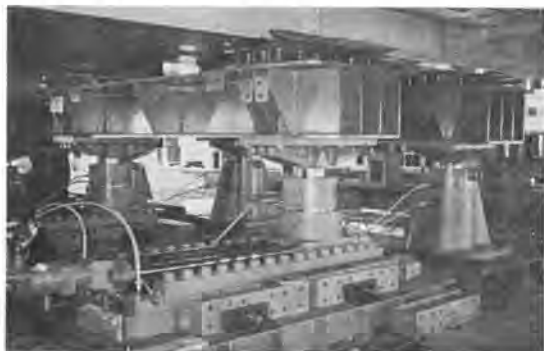
写真—4 送出し装置配置状況
