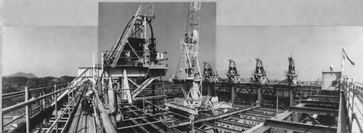
⇨最終まじかのリフトアップ工事
