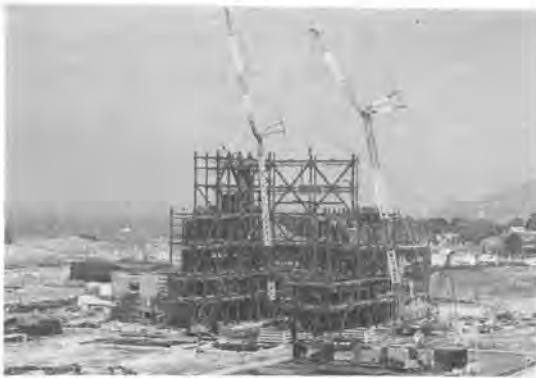
写真-1 バンカーホップの取付
