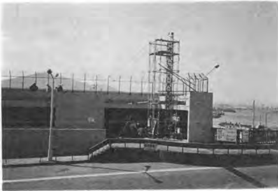
写真-2 本計測の基準点であり、頂部に水タンクをセットした
