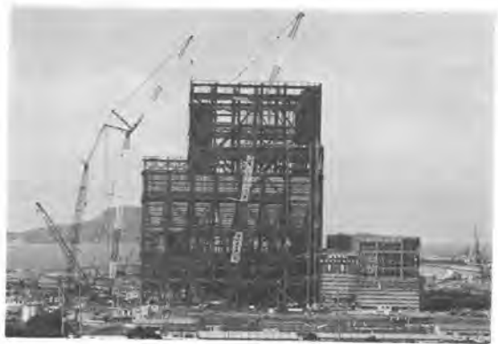
写真-2 最終鉄骨建方
