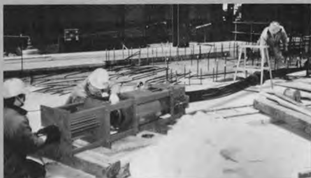
◆ジャッキ、つりケーブルを地上で組立てる
