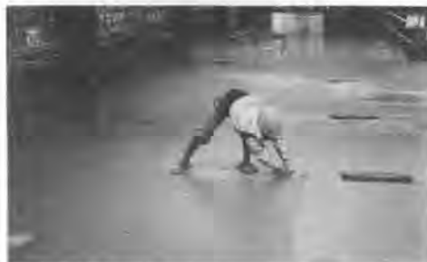
写真-1 熟練工による仕上げ作業
