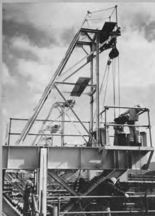
◆ウインチでジャッキをジャッキ架台につり込む
