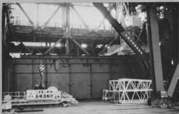
◆トップガーダ上にジブクレーンを組立てる
