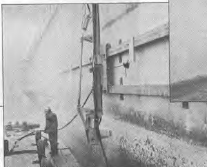
岸壁ハツリ作業
