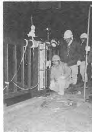
写真-5 ⑤点における光波の標的および変位センサを同時にセットした
