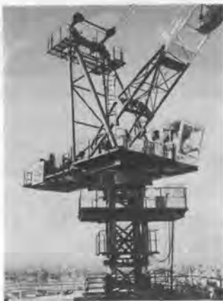
写真-1 20 t・m タワークレーン
