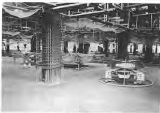
写真-6 現場試用中のコンクリート床仕上げロボット
