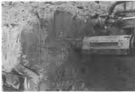
写真-3 施工状況
