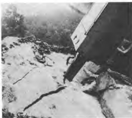
写真-2 割岩状況
