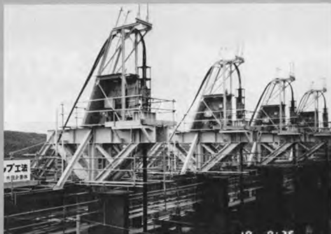
◆指令室をボイラー棟頂部に設置した 準備完了したリフティング装置◆
