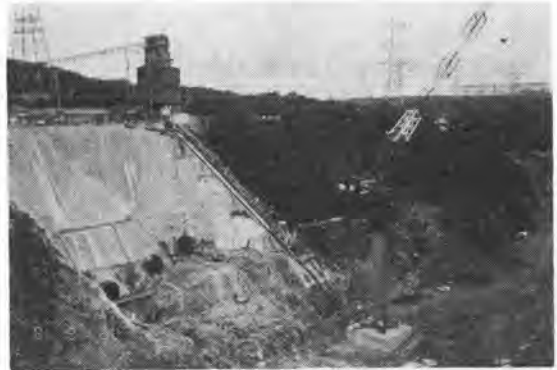
写真-2 ダム打設用インクライン台車
