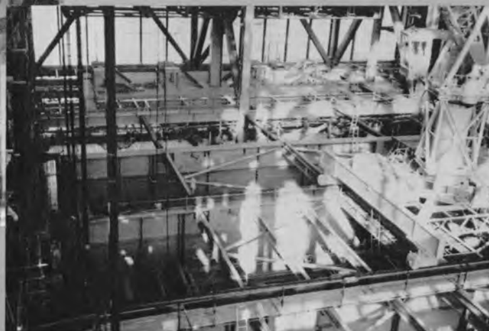
◆ジブクレーンによるボイラー機器の取込み作業◆
