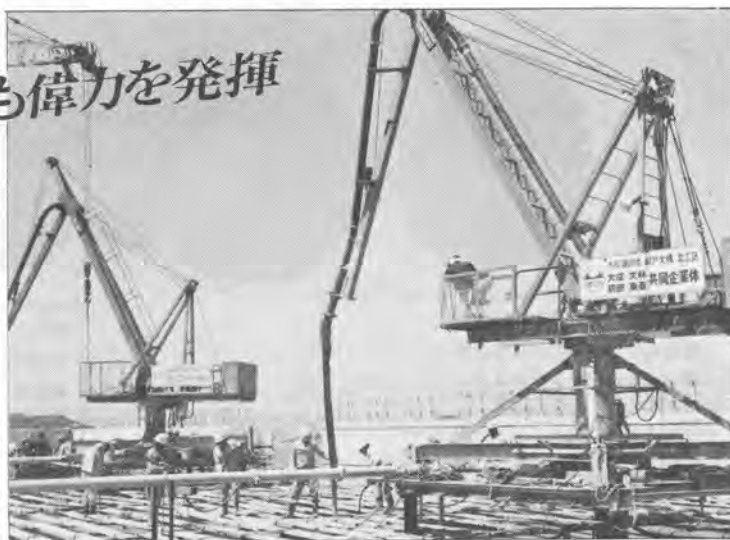
(本四架橋現場設置例)
