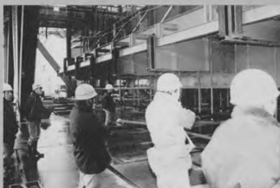
◆リフトアップ中のトップガーダとつりボルト
