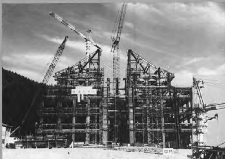
◆大屋根部鉄骨建方
