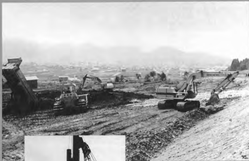
⇨敷地造成切土・盛土
