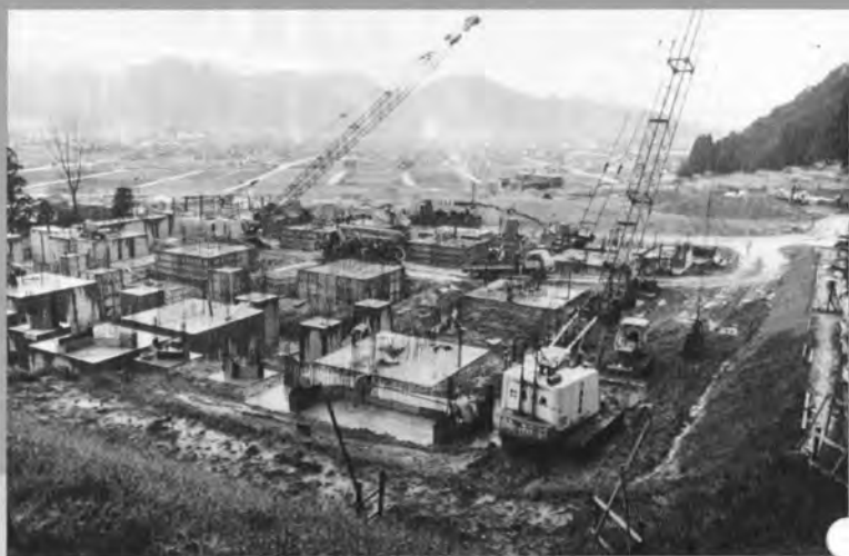
⇨基礎鉄筋、型枠組立、 コンクリート打設
