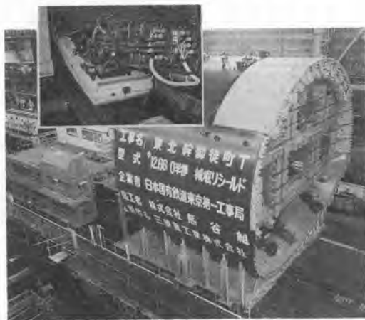
写真-6 φ12.66 m 半機械掘り式シールド
