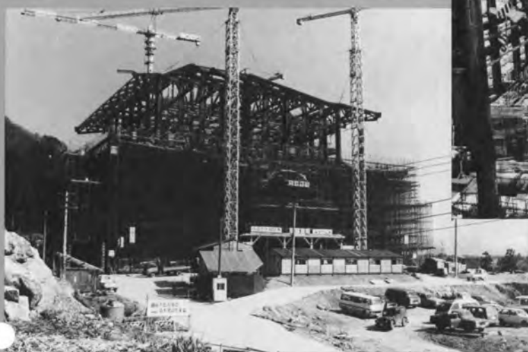
◆下屋根部 コンクリート打設
