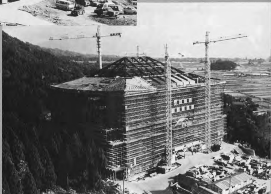
大屋根部 コンクリート打設◆
