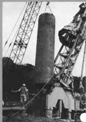
⇨ベノト杭築造
