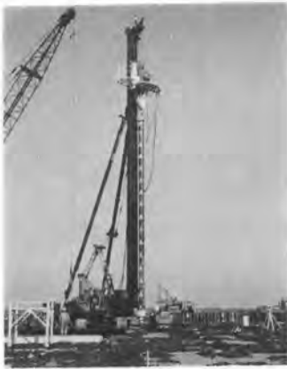
写真-3 生石灰杭打設機
