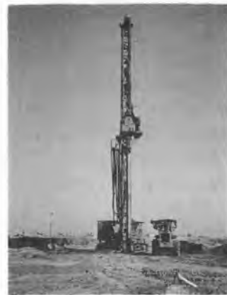
写真-6 サンドコンパクションバイル打設機
