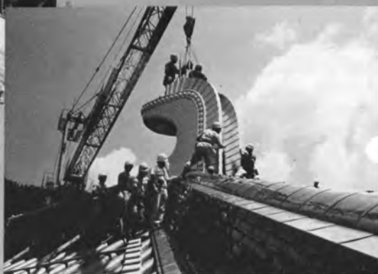
大屋根 しび 鴉尾取付け
