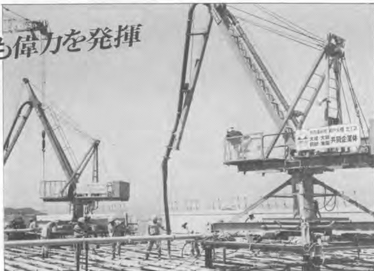
(本四架橋現場設置例)
