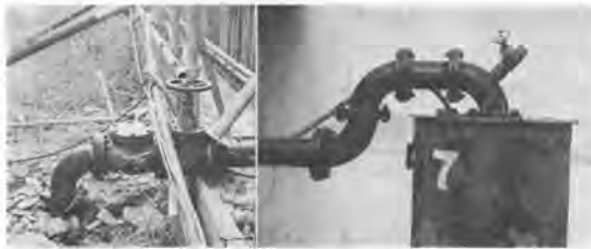
写真-2 揚水井の頭部
