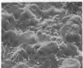
写真-2 溶射された皮膜の表面
