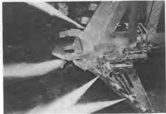
写真-2 硬質地盤急速さく孔工法
