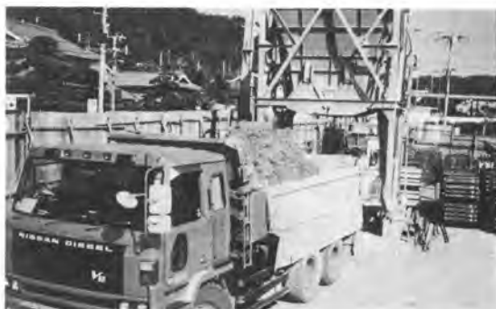
写真-3 残土搬出状況
