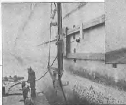
岸壁ハツリ作業
