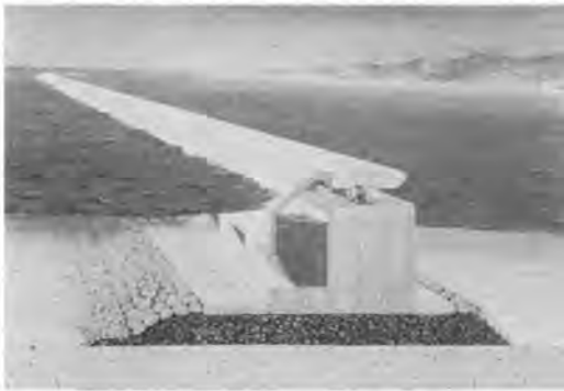
写真-3 波力発電ケーソンを用いた防波堤
