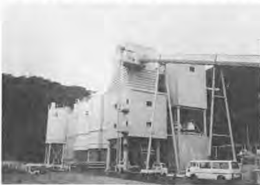
写真-1 アイスプラントを併設したコンクリートプラントの全景
