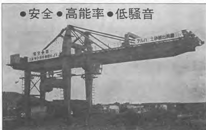
YBM-110型 バケツ8M 3 能力150M 3 /H (地下25Mより)
