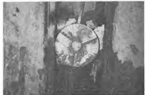
写真-2 掘削パイロットヘッドの到達および刃先の状況
