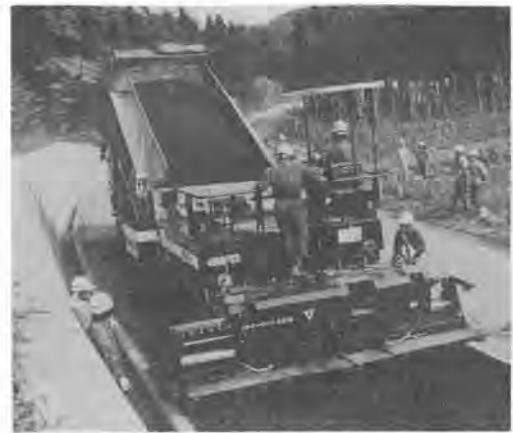
写真-4 前後輪駆動アスファルトフィニッシャ (住友建機)
