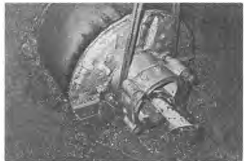
写真-4 カッタヘッドの到達状況
