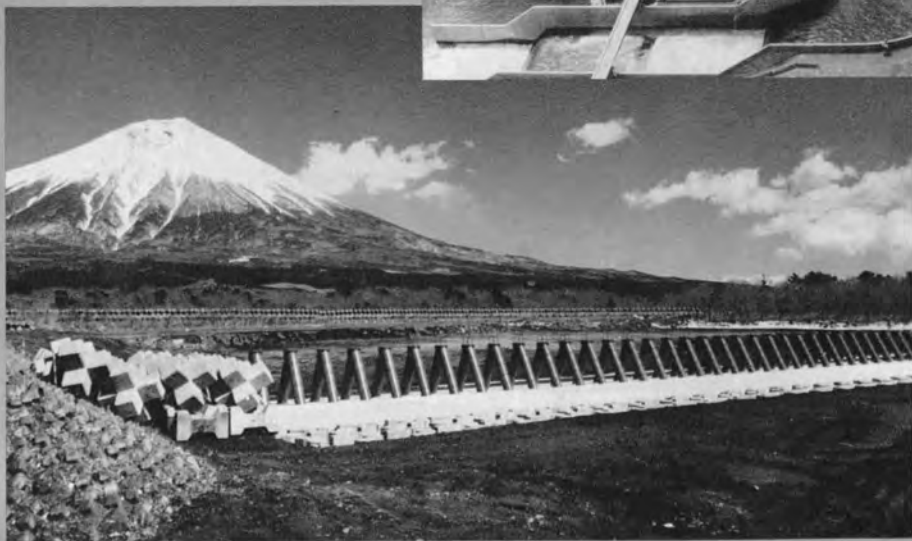
⇨ 樹林帯前面補強工 (静岡)
