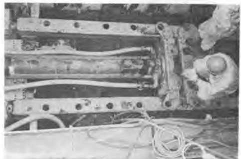
写真-1 パイロット管推進状況
