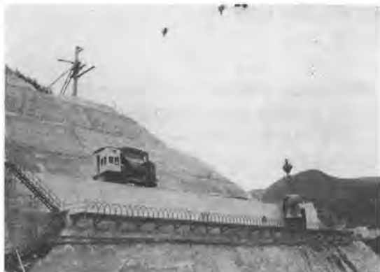
写真-1 無人コンクリート運搬車全景
