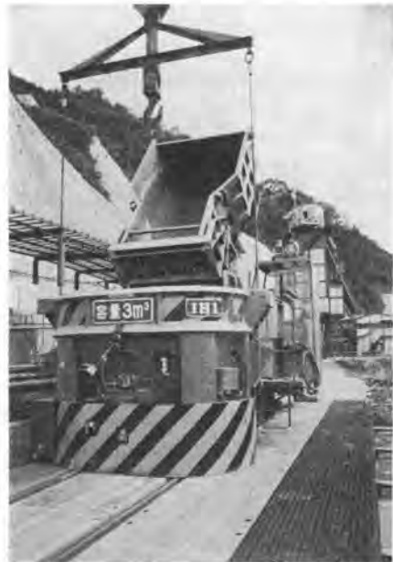
写真-1 全自動コンクリート運搬台車
