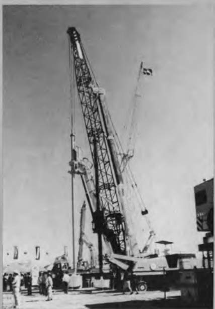
⇨アースドリルと深礎掘削機
