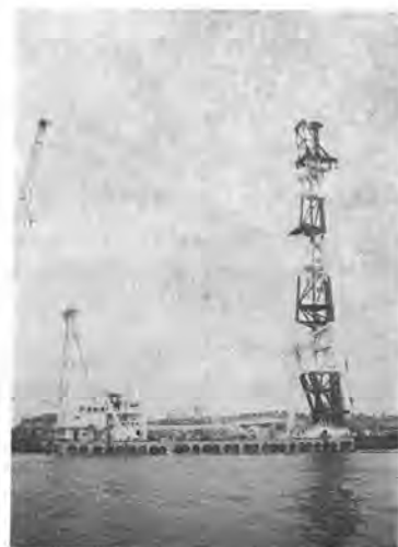
写真-5 杭打船「第十芳飛」
