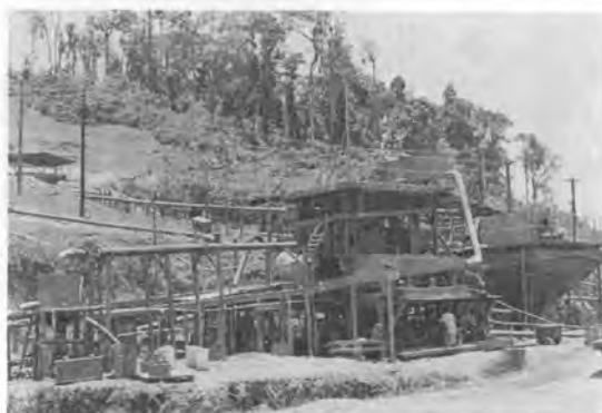
写真-7 NA 鉱山選鉱場大型ジグ選別機
