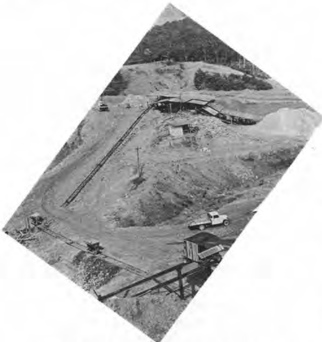
写真-2 YD 鉱山坑外(インクラインと選鉱場全景)
