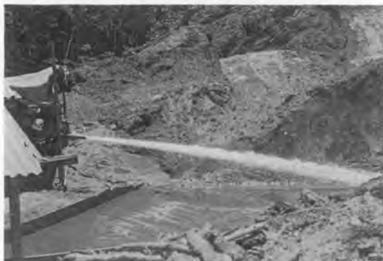
写真-6 NA 鉱山ジェット水流採掘
