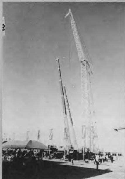
⇨高さとり能力を誇るクレーン群
