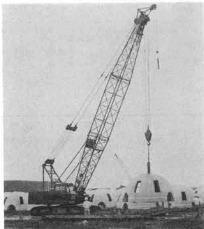
写真-6 日立 KH 230-3 全油圧式クローラクレーン
