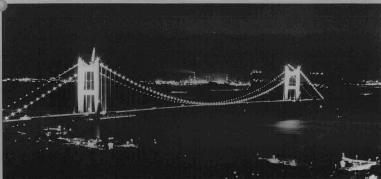
◆維持管理用照明を点灯した下津瀬戸大橋（つり橋）
