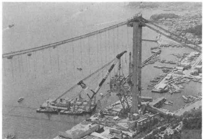
写真-4 下津井瀬戸大橋 2P 塔付2パネルの架設
