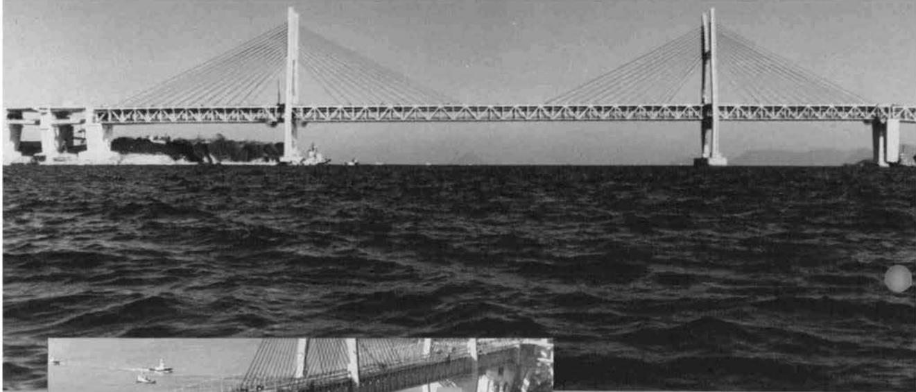
⇨ 岩黒島橋（斜張橋）
