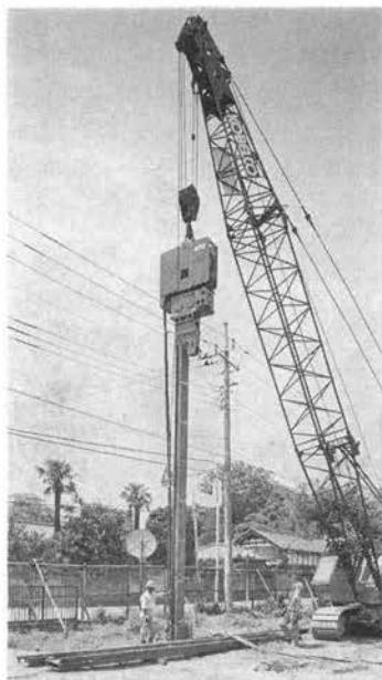
写真-8 日平技術 NVZ-40 油圧パイプロ
