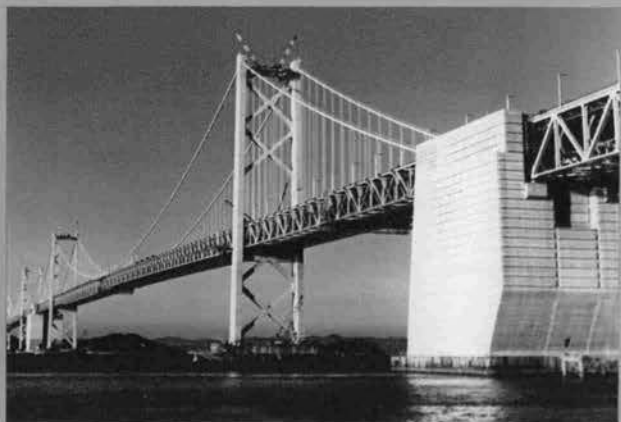
⇨ 北備讃瀬戸大橋（左方）と南備讃瀬戸大橋
