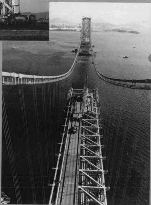
⇨補剛桁の架設作業⇨
