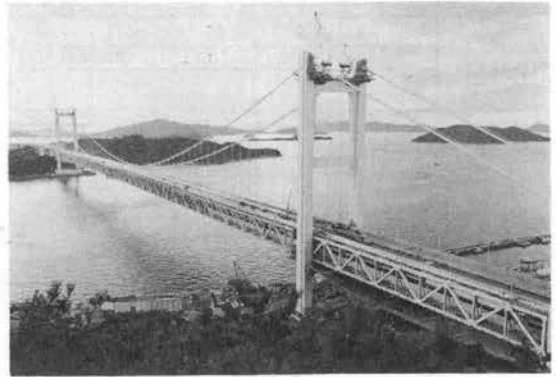
写真-1 下津井瀬戸大橋（鷲羽山から四国側を望む）
