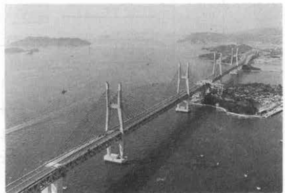
写真-2 櫃石島橋・岩黒島橋（手前岩黒島橋）
