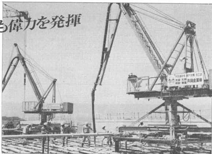
(本四架橋現場設置例)
