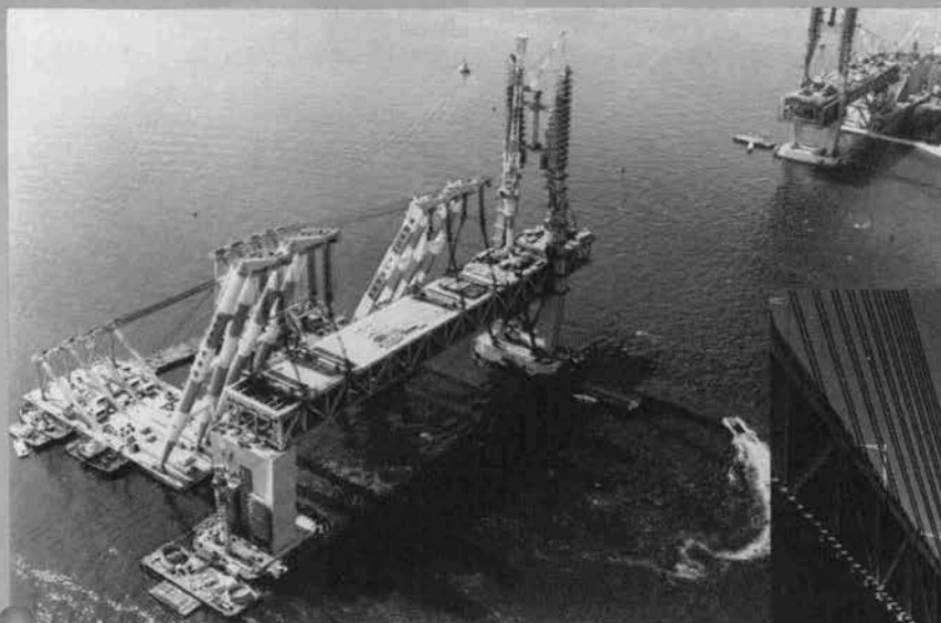
◆クレーン船相づりによる桁の大ブロック架設
