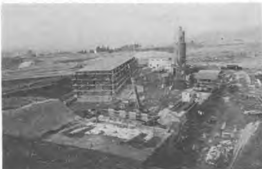
写真-2 発進基地
