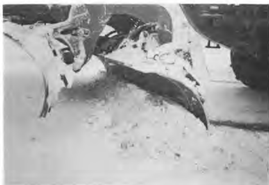
写真一11 第2ブレードによる圧雪処理作業
