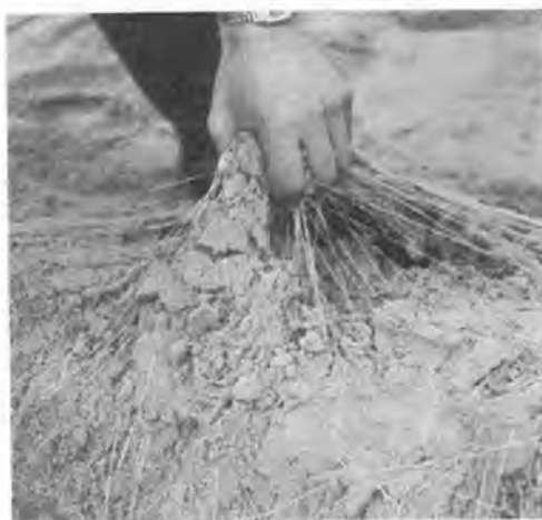
写真-1 テクソル工法
