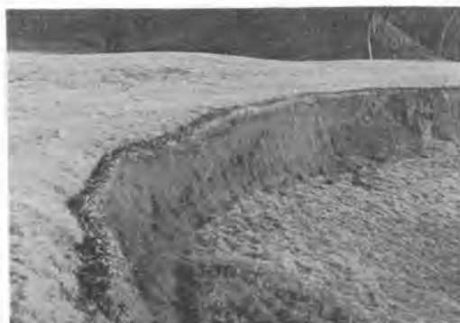
写真-3 ゴルフコース改修工事(植生後)
