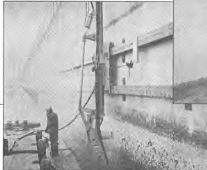
岸壁ハツリ作業
