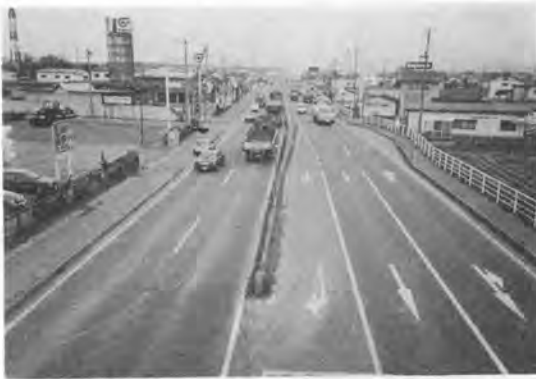
写真-1 広幅員多車線道路状況
