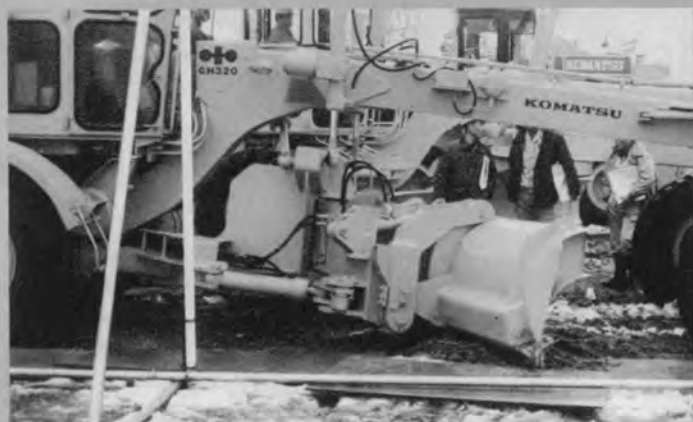
❖ 高出力除雪グレーダ (小松 GH 320)
