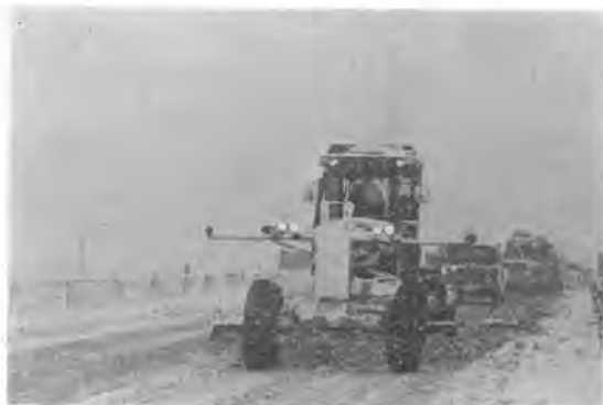
写真-7 1車線ワンバス除雪作業状況
