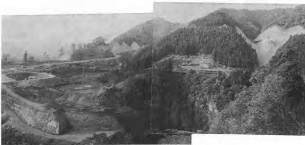
写真-1 骨材生産プラントが設置される予定の左岸台地
