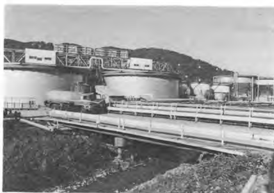
写真—10 排水処理設備（吉岡）
