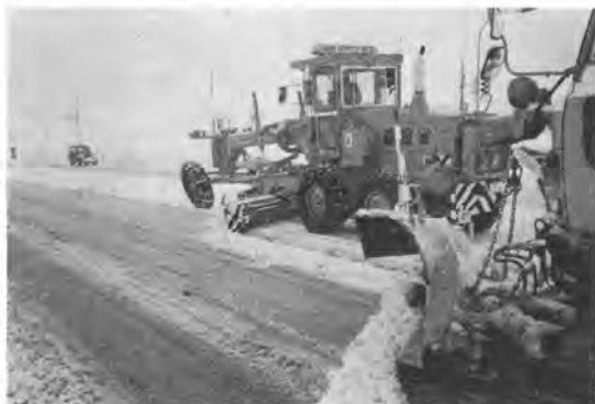
写真一10 雁行除雪作業時の雪の流れ
