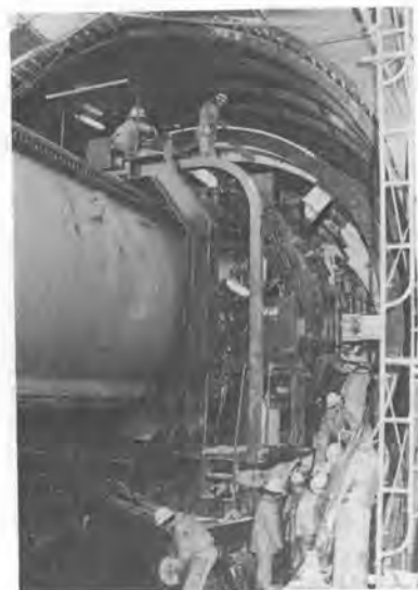
写真-3 シールド機組立状況
