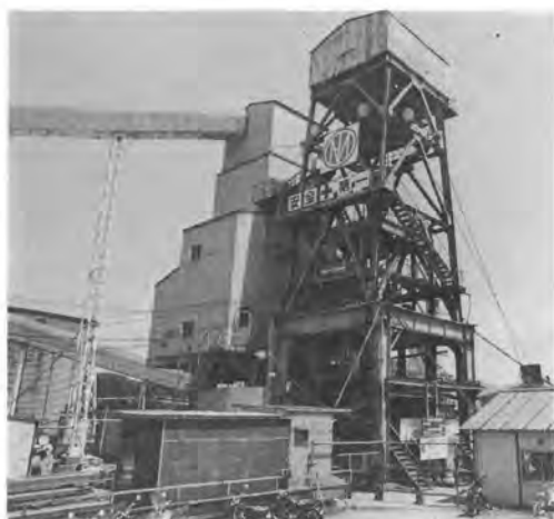
写真—8 立坑巻上設備（吉岡）
