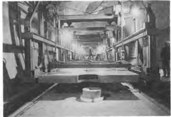
写真-13 スラブ運搬敷設車
