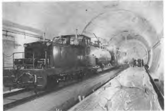
写真-14 移動注入プラント車
