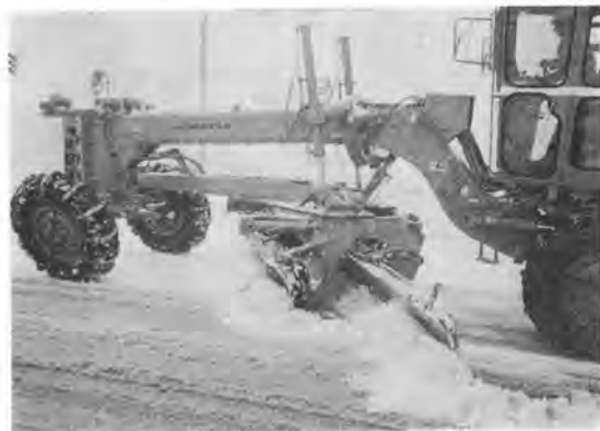
写真一9 ブレード負荷状況と雪の流れ
