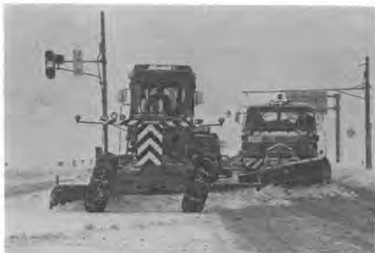
写真-6 除雪作業状況
