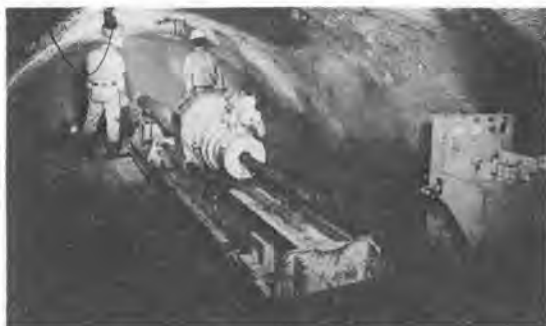
写真-1 水平ボーリング用試錐機
