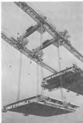
写真-2 補剛桁ブロックのつり上げ状況
