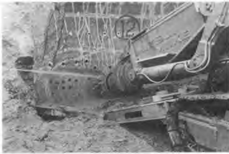
写真—11 あらかじめ削孔してあるところをロードヘッダで掘削しているところ
