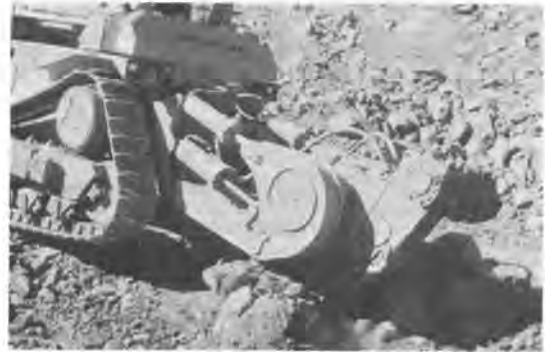
写真—1 インパクトリッパによる破砕作業
