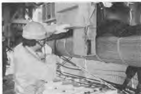
写真-5 L/Bの主ケーブル上走行状態
