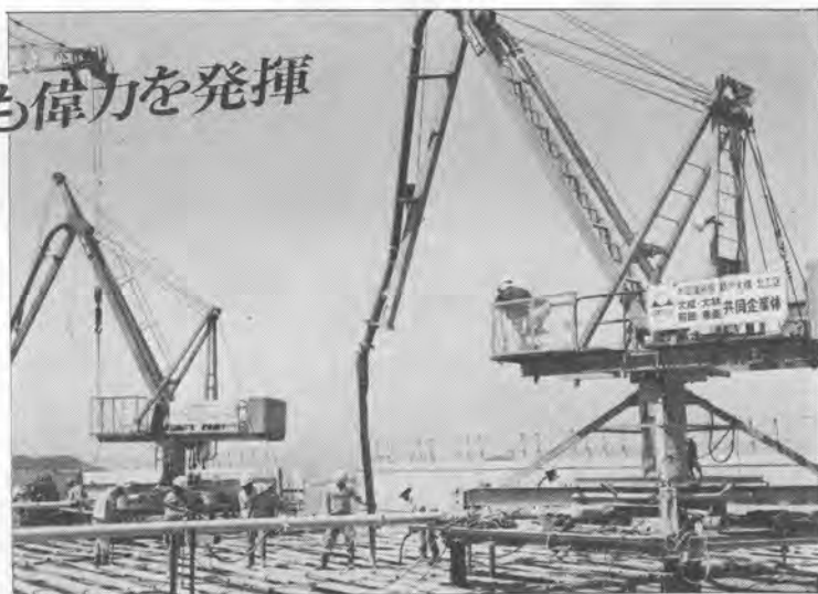
(本四架橋現場設置例)
