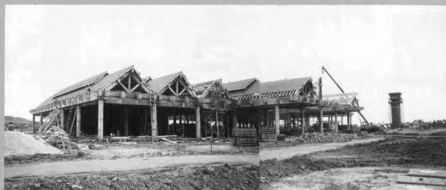
⇨ 施工中のターミナルビル
