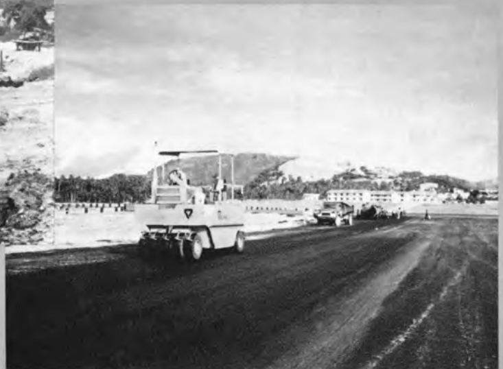
✧アスファルト舗装✧
