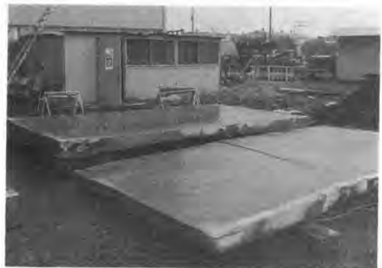
写真-2 水平切断の切断面
