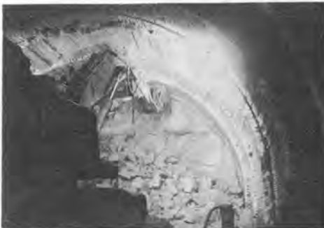
写真—14 写真—13 のところを碎岩機で掘削しているところ
