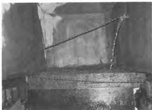
写真-4 桁部切断
