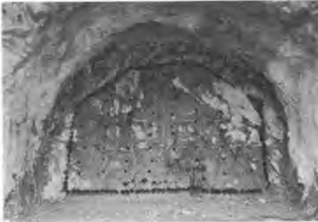
写真—12 周囲にスリッタによってスリット状の削孔をしたところ
