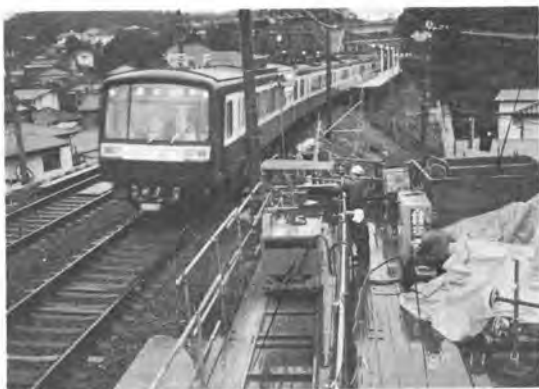
写真-3 切断中の全景
