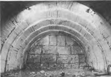
写真—13 スリッタで格子状にスリット削孔をしたところ
