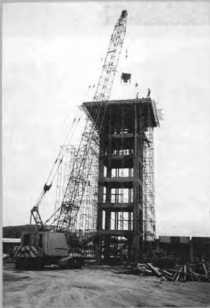
⇨ 施工中の管制塔
