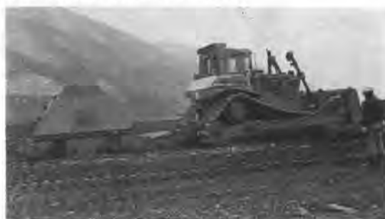
写真-1 けん引式 MVT 施工機
