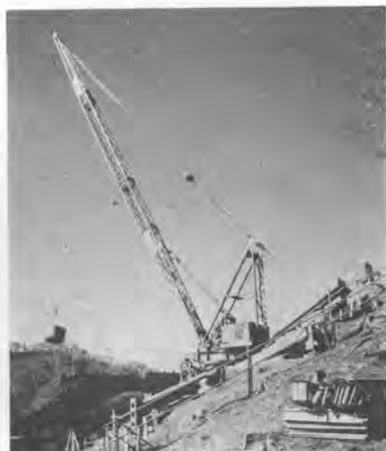
写真-4 日立 HS 36 鉄塔建設補助用ジブクレーン
