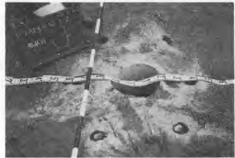
写真—4 φ 300 mm の空孔と周囲の平行孔
