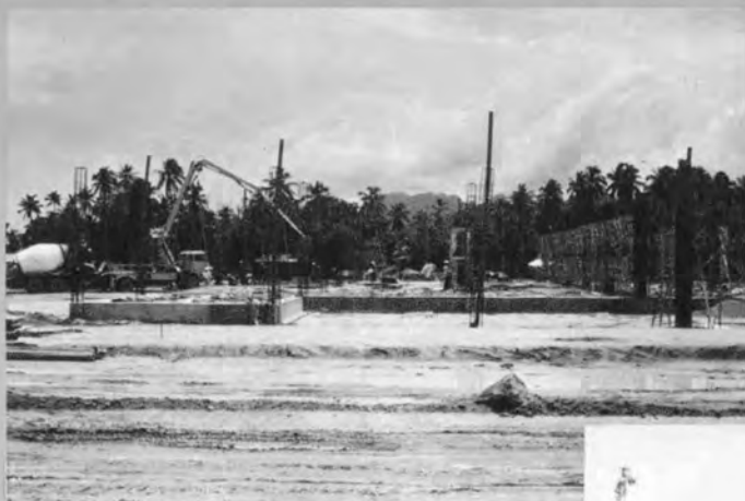
⇨ ターミナルビル基礎工事
