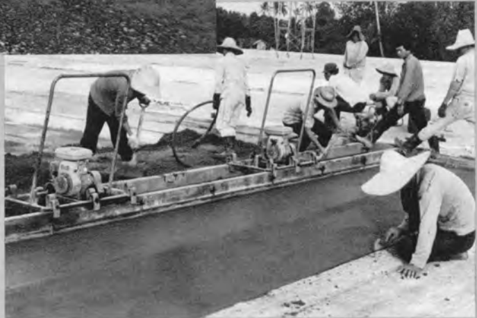
⇨ エブロンコンクリート打設
