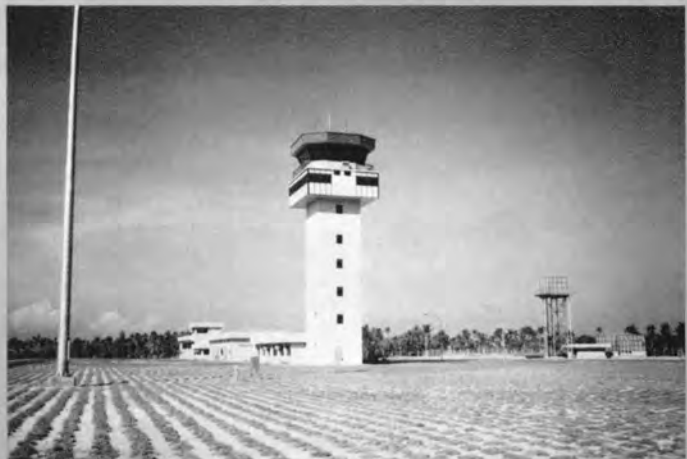
⇨ 完成した管制塔
