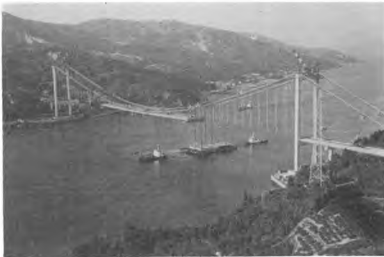
写真-1 補剛桁ブロックのつり上げ状況
