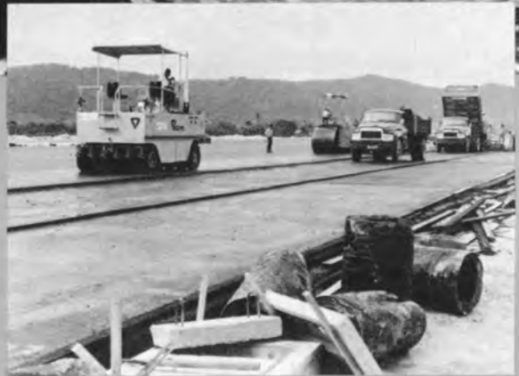
✧アスファルト舗装型枠使用
