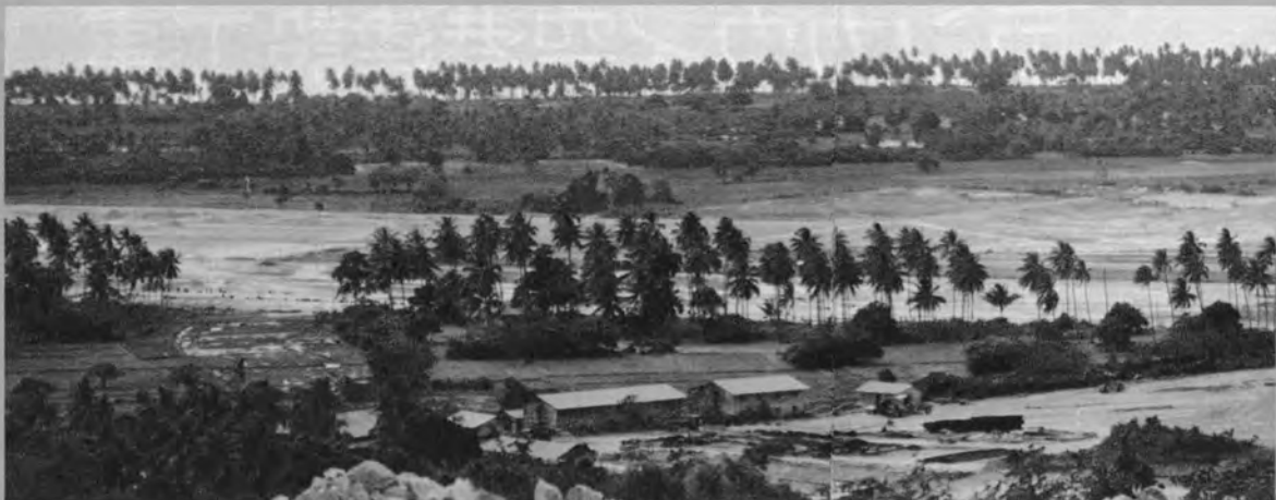
⇨ 滑走路施工前全景
