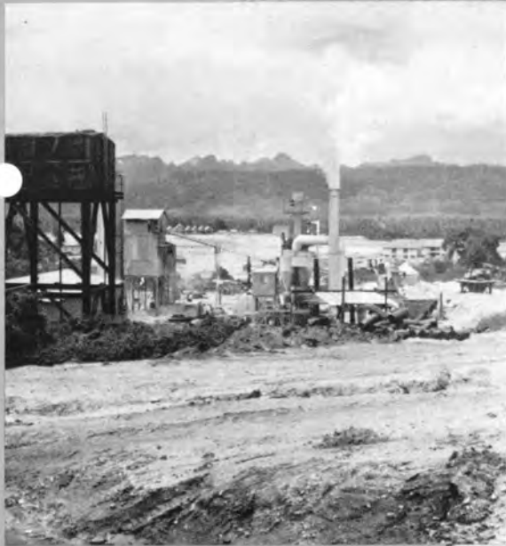
✧アスファルトプラント (80 t/hr)
