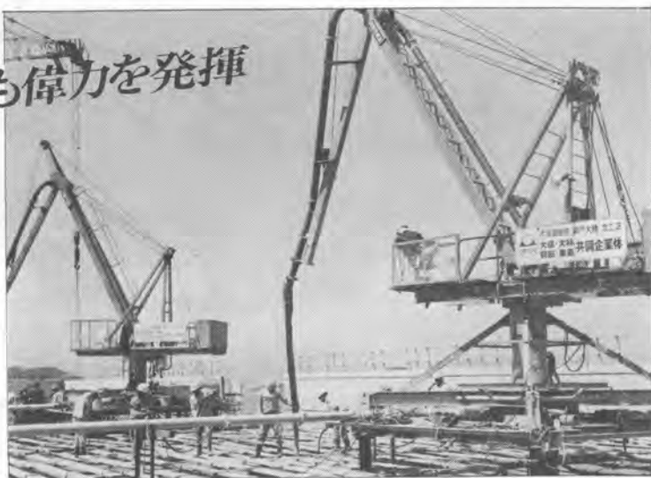
(本四架橋現場設置例)
