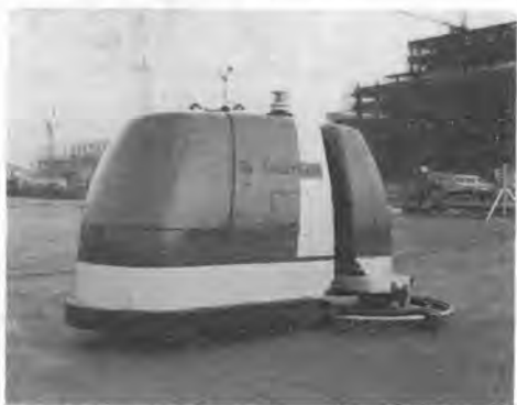
写真-5 床仕上げロボット（大林組）
