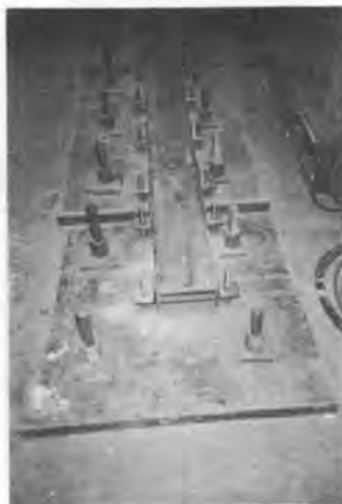
写真-3 ソリッド部材組積用鋼製基礎
