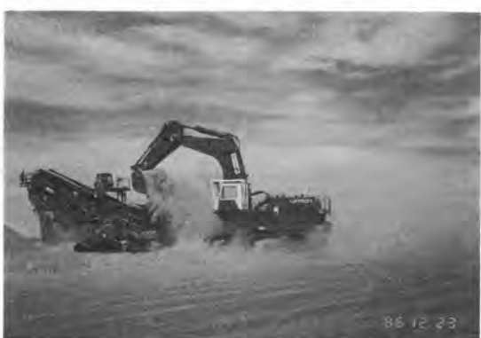
写真-6 日立UH 801稼働現場
