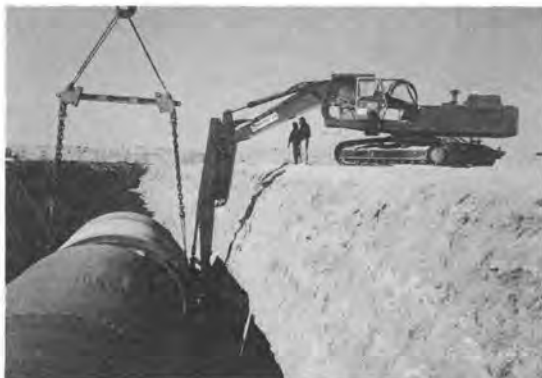
写真-5 日立UH 143スライドアーム式振動締め機
