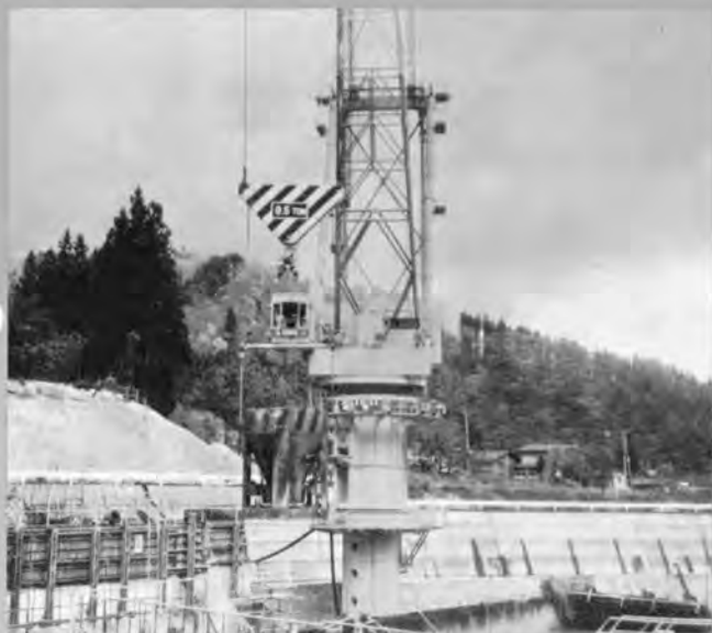
◆タワークレーンの自動運転システム（間組） 目標地点を指示すると、自動的に安全なルートを選んでつり荷を目的地まで移動させる
