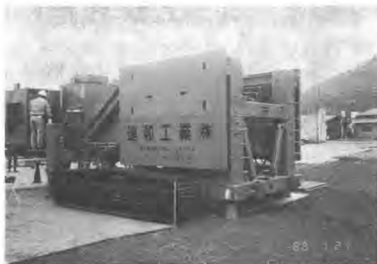
写真-6 三菱 MT 120 RS 全旋回ボーリングマシン
