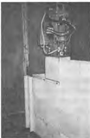
写真-5 ソリッド部品を所定の位置へ組積するところ
