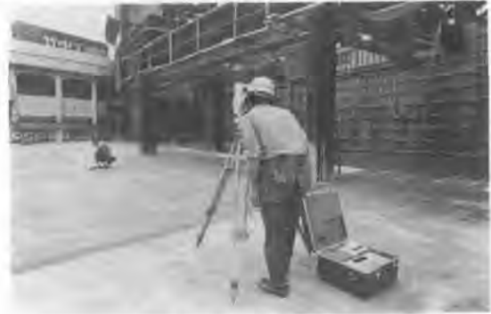
写真1 測量中のコンパス-L
