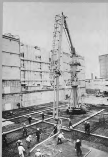
④ブレーシングクレーン (大林組) オペが1本のレバーで筒先を任意の位置に移動、水平面保持や垂直面を保持した撒出しも可能
