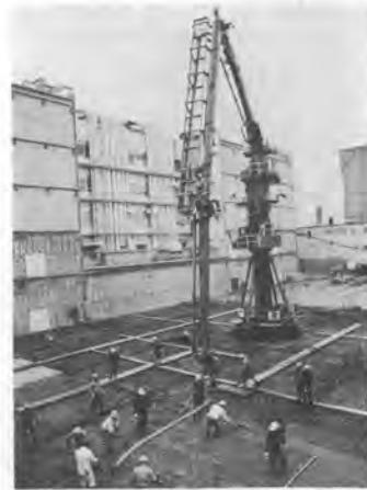
写真-5 自動制御式プレーシングクレーン (ディストリビューター仕様)
