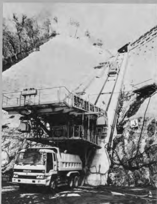
◆RCD工法インクライン自動化システム（西松建設） バッチャプラント——ホッパステーション間のインクライン設備の無人運転
