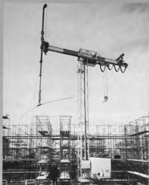
④耐火被覆吹付ロボット (清水建設) 梁の位置・形状を入力してやると、指定の位置にロボットが自動的に移動し、指示した場所に所定厚の耐火材を吹付ける
