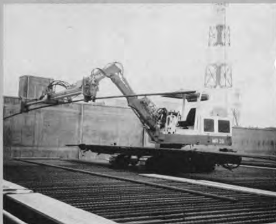
⑤鉄筋配筋ロボット (鹿島建設) 重量鉄筋をあらかじめ指示したパターンに自動的に配筋する
