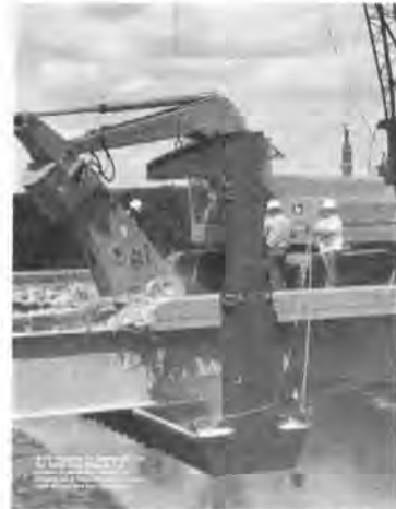
写真-3 工事状況
