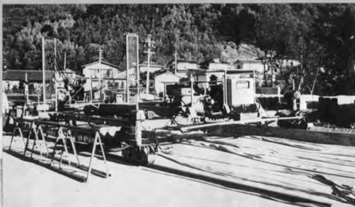
⑦高精度コンクリート縦仕上機 (鹿島道路) コンクリート縦仕上機の高さ調節をサーボモータを使って自動化し、高さ表示もデジタル化した
