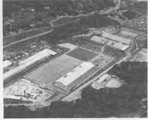
岸山工場全景
