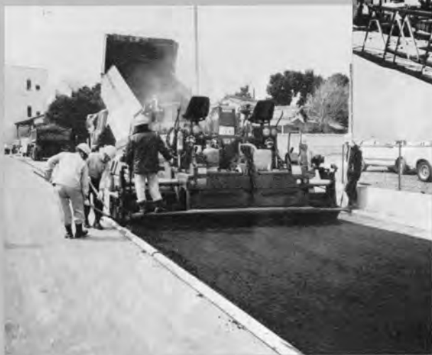
⑧自動運転アスファルトフィニッシャー 4.5m (日本舗道) 発進・停止、ステアリング、材料供給、ホップウイング開閉敷ならしの厚・幅の調整などを自動化
