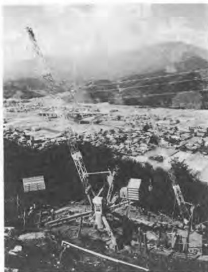
写真-4 石川島 M-40 ジブクレーン
