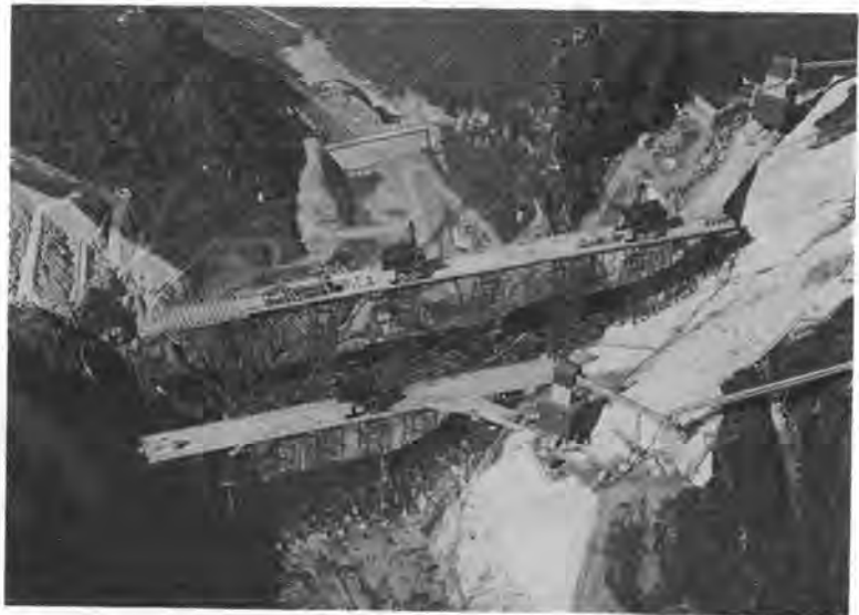
写真-1 走行路組立状況
