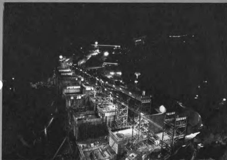
⇨ 工事中の弥栄ダム
