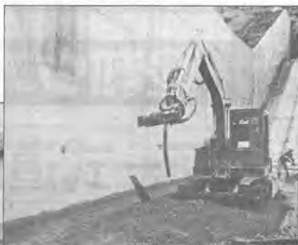
コンクリート壁削り
