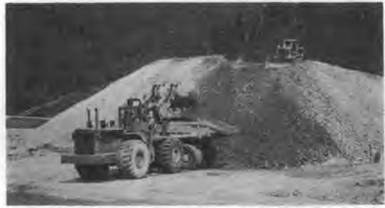
写真-2 フィルタ材のストックパイルング
