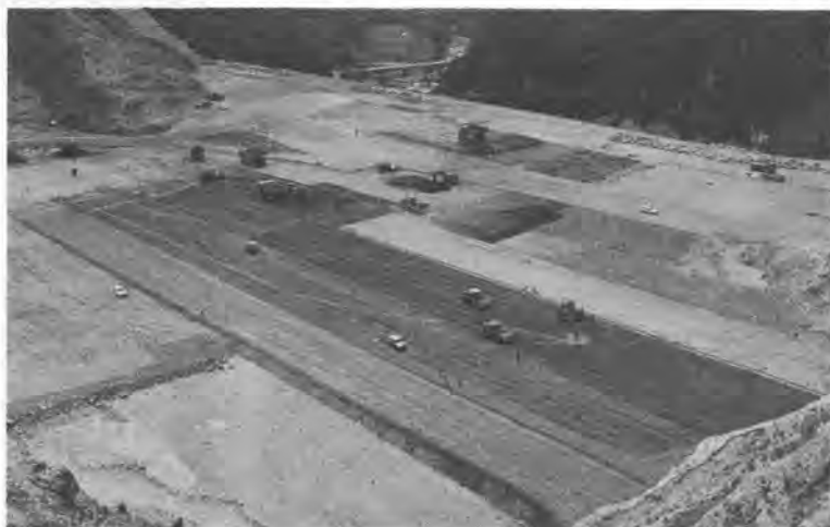
写真-8 本体盛立工
