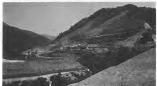
写真-3 ロック山法面対策工
