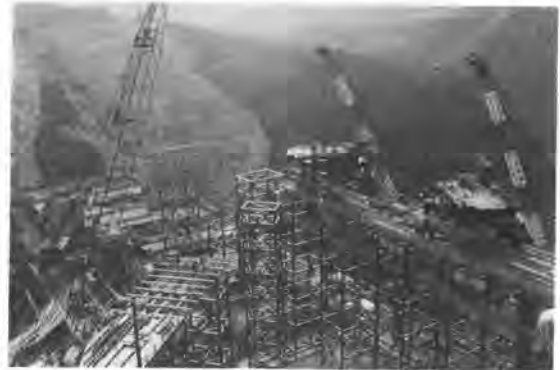
写真-2 ジブクレーンの移動状況
