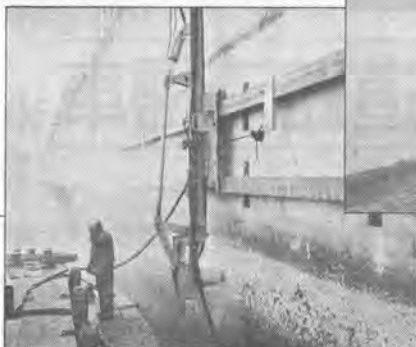
岸壁ハツリ作業
