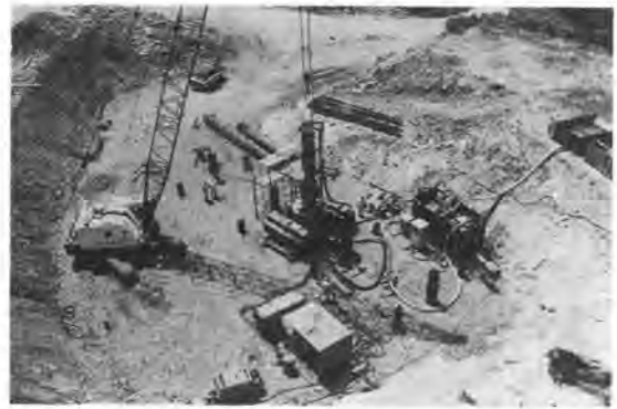
写真-3 岩盤掘削時状況
