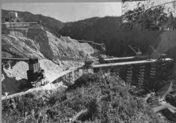
⇨ 上下流バッチャプラント, ジブクレーン
