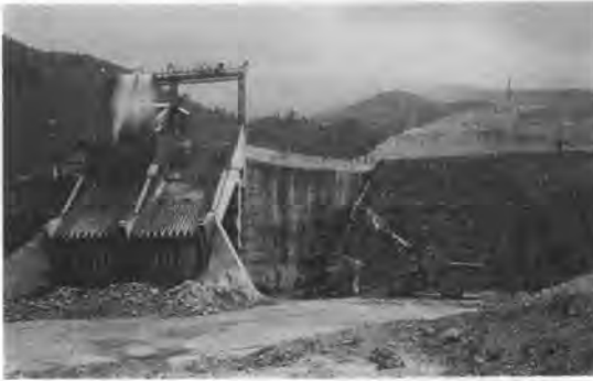
写真-1 コア材のグリズリ処理と含水比調整
