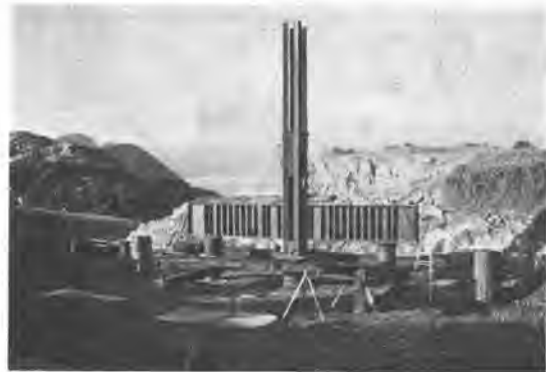
写真-5 引抜試験状況
