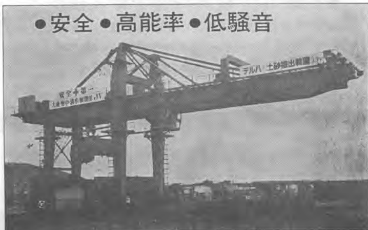
YBM-110型 バケット8M 3 能力 150 M 3 /H (地下25Mより)
