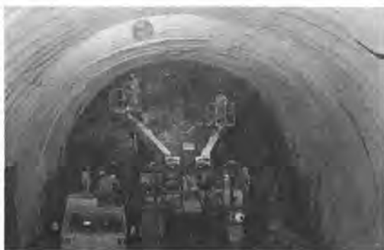
写真-1 装葉孔とロックボルト孔の並行作業
