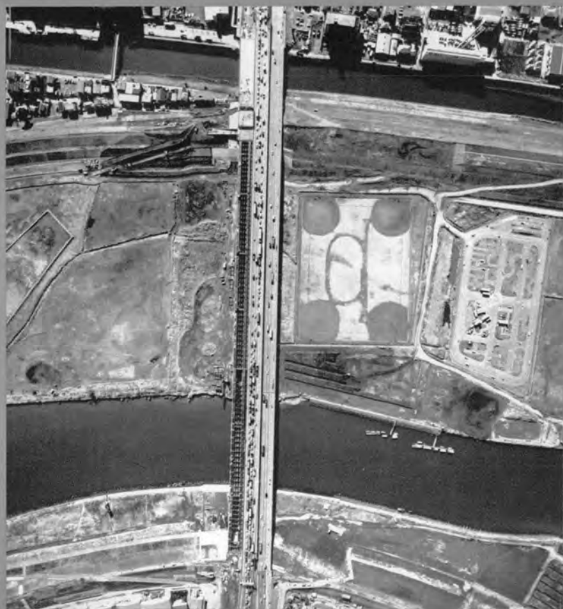
⇨ 工事場所全景 (笹目橋出入路(写真 下部)より笹目橋を のぞむ)
