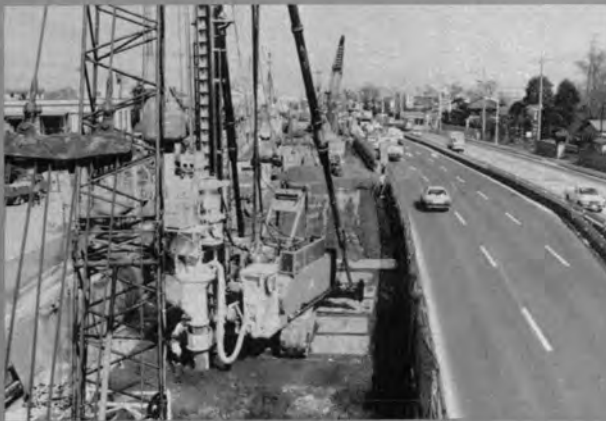
地盤改良工事
