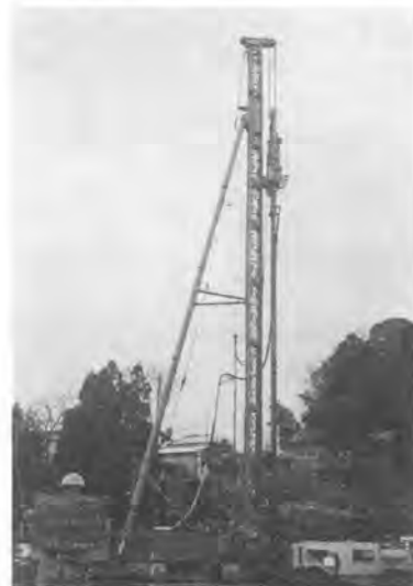
写真-16 排土式 CMC 施工機械
