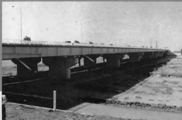
⇨ 完成した笹目橋
