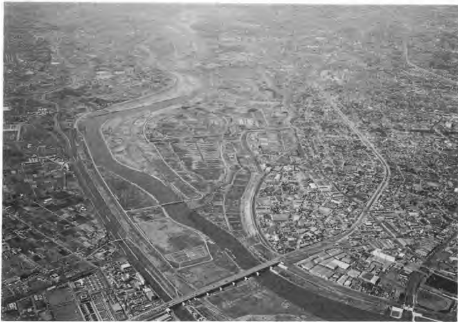
写真-1 荒川第1調節池全景（下流から上流を望む）
