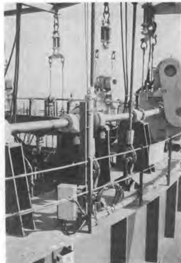
写真-4 通常管および水平度検出センサ
