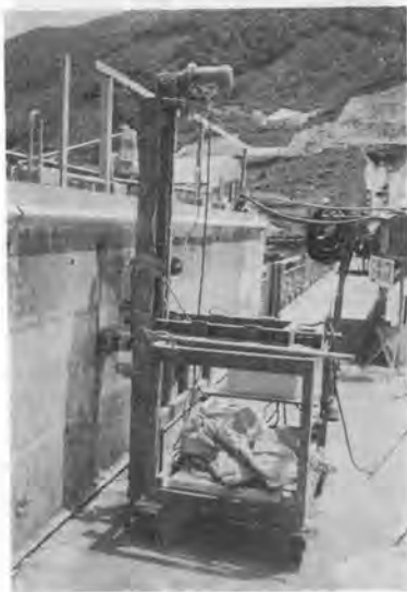
写真—46 ダム用型枠自動清掃機
