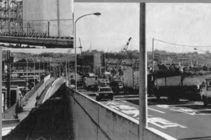
東京地区建設状況⇨
