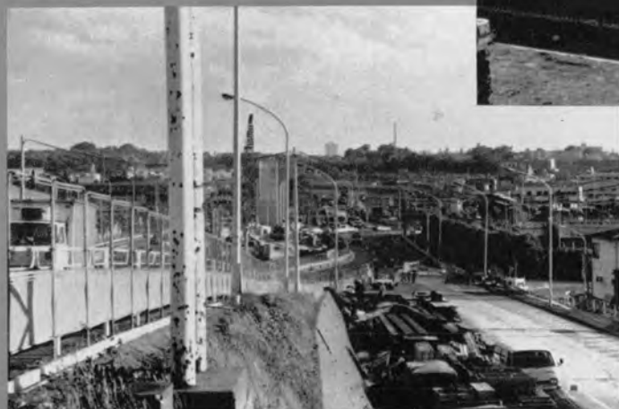
⇨ 完成間近な笹目橋出入路
