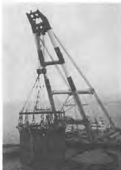
写真-1 根入れ式鋼板セル施工状況
