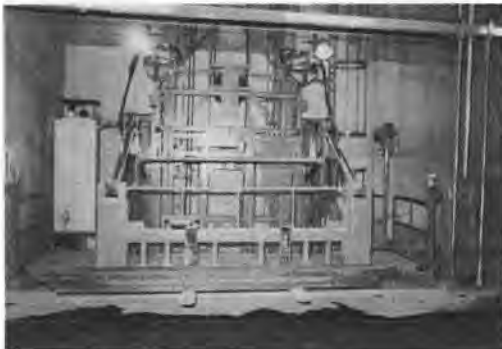
写真-8 超高速自動リフト
