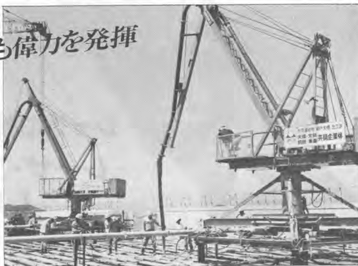
(本四架橋現場設置例)
