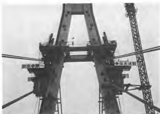
写真-5 下段作業台水平スライド機構
