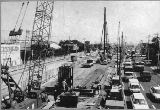
低公害工法による中間杭打設工事
