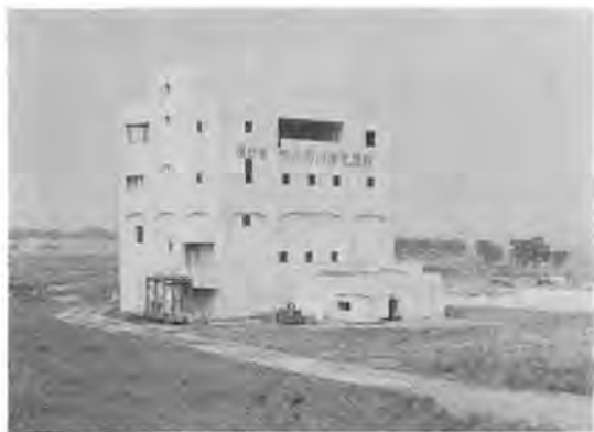
写真-3 荒川河川浄化機場で手前側が吐出槽、右側の工事中個所が浄化施設
