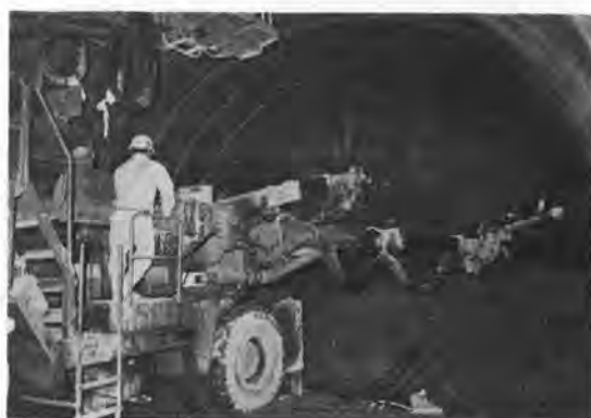
写真-2 下半のせん孔とロックボルトの並行作業
