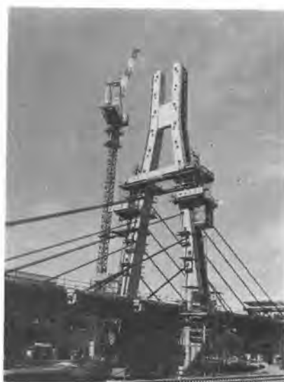
写真-4 斜材架設時全景
