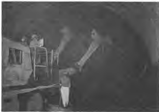
写真-4 吹付状況
