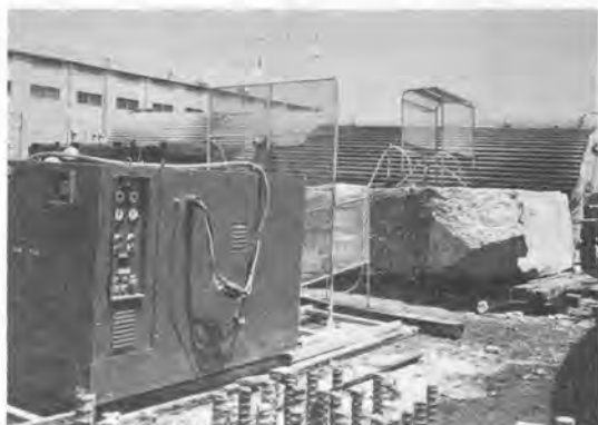
写真-44 コンクリート切断機
