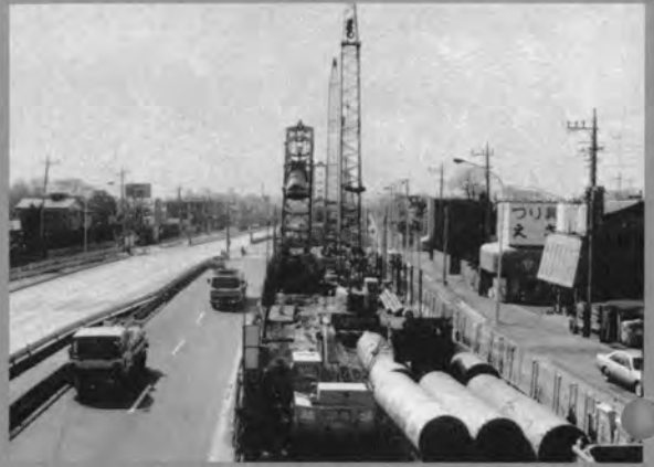
ベント機による基礎杭工事
