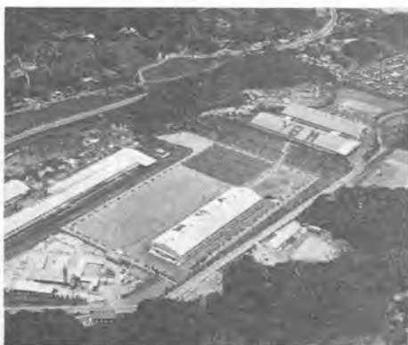
岸山工場全景
