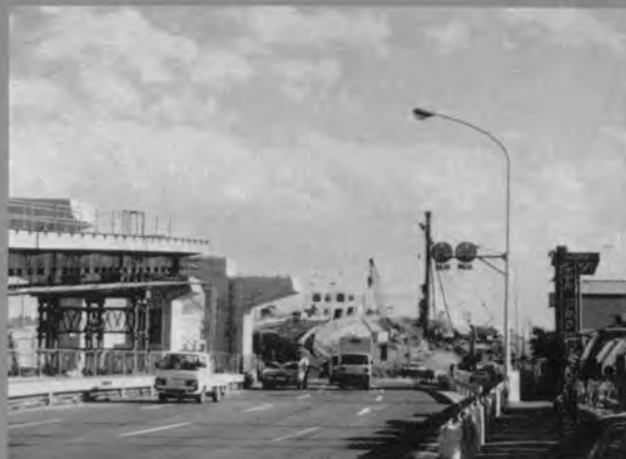
⇨ 笹目橋出入路 SC 杭打設工事
