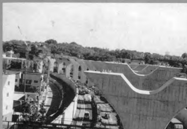
⇨ 東京地区接続部の5号線（Ⅱ期）工事
