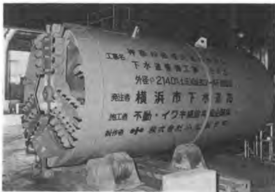
写真—26 頭動形新2折アーティキュレートシールド機
