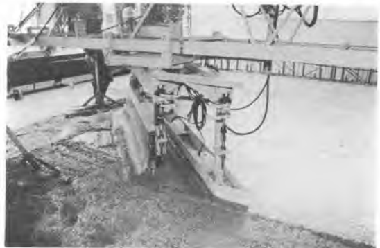
写真-31 コンクリート床ならし装置
