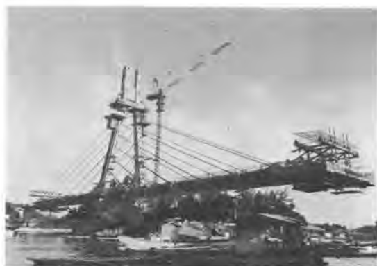
写真-1 布施田浦橋工事状況
