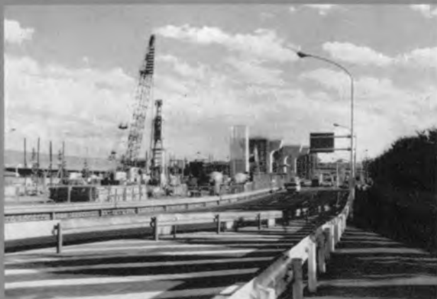
⇨ 笹目橋出入路基礎杭工事
