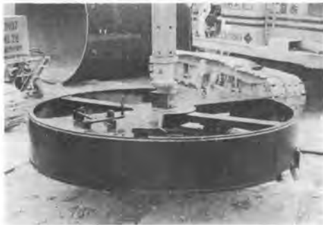
写真-14 径 3 m 用ドリリングバケット
