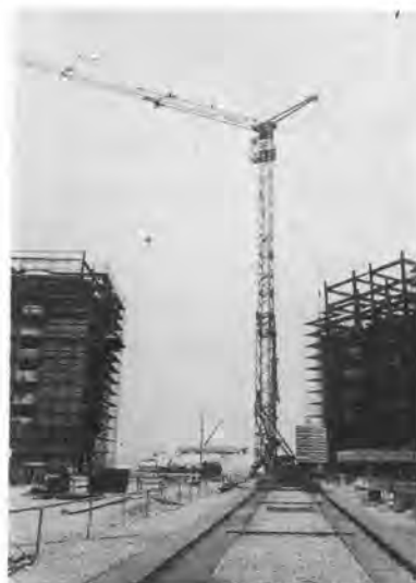
写真-7 走行式水平ジブ形タワークレーン
