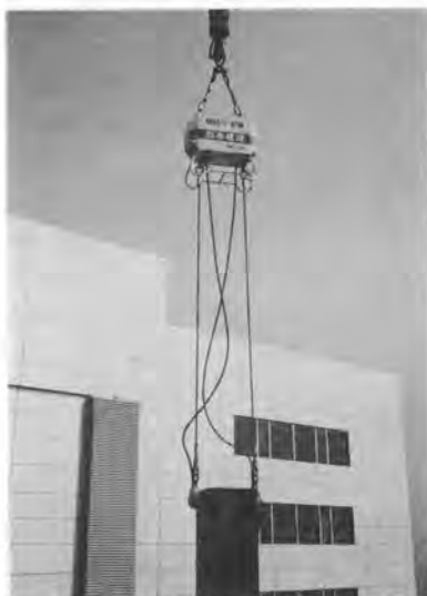
写真-10 自動玉掛けはずし装置
