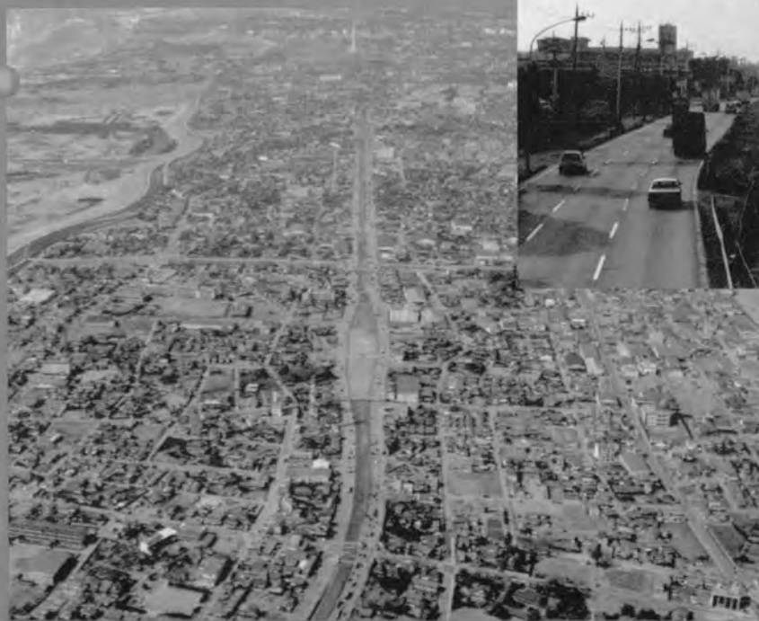
⇨ 工事場所全景
