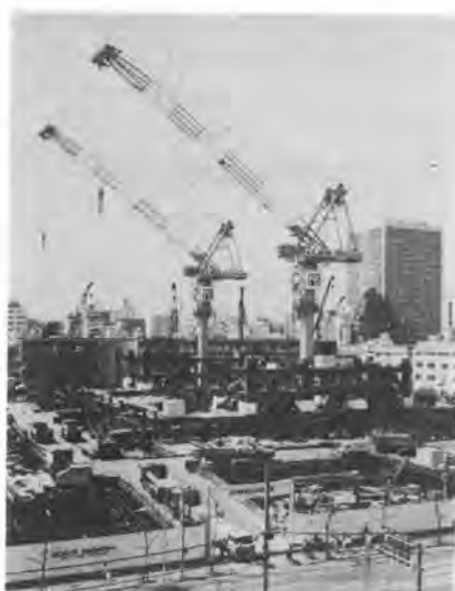
写真-6 超高層用タワークレーン K-900 H
