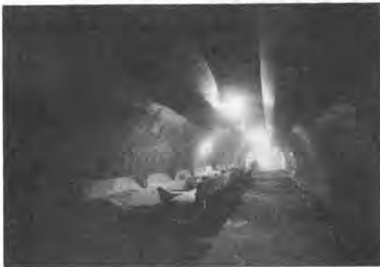
写真-4 コンテナ併置状況
