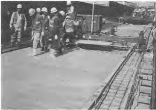
写真-2 上面増厚法による鋼橋床版の改良工事
