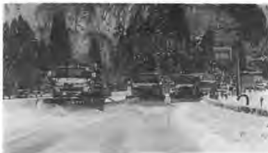
写真—4 機械除雪作業
