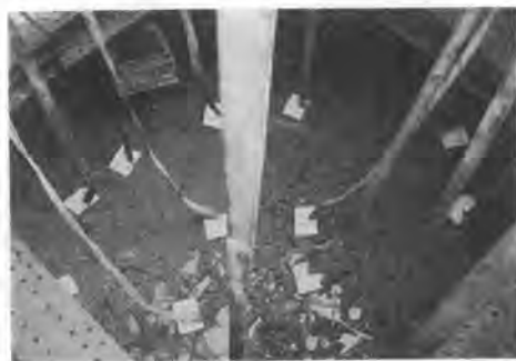
写真-5 ドレン材の土中での鉛直性の確認
