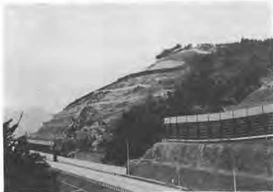
写真—2 落石防止柵
