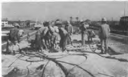
写真-3 伸縮装置補修工事
