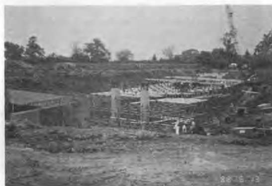
写真-3 橋梁工事
