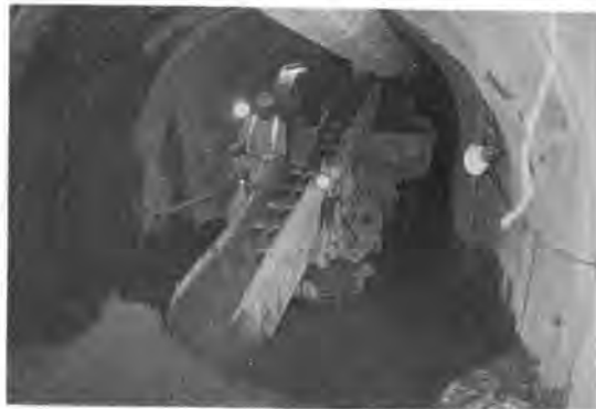
写真-2 フックス 40 による掘削状況
