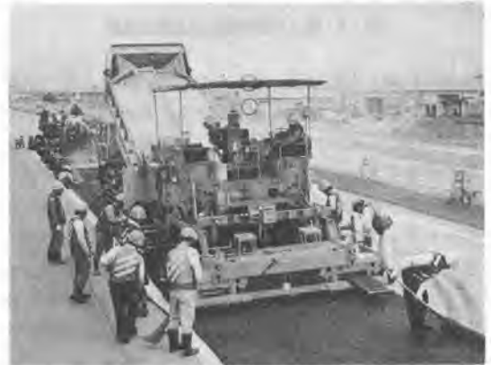
写真-1 路上表層再生工法による舗装改良
