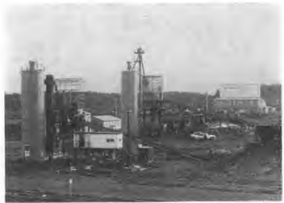
写真-1 コンクリートプラント全景
