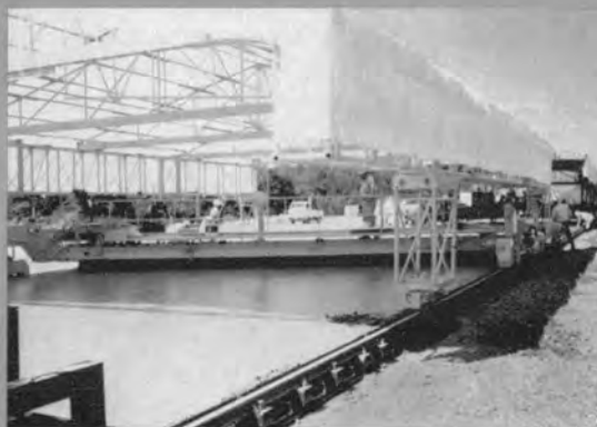
⇨斜め仕上げ機
