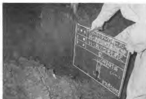
写真-6 打設後のJ効果確認のための掘削(深度10m)
