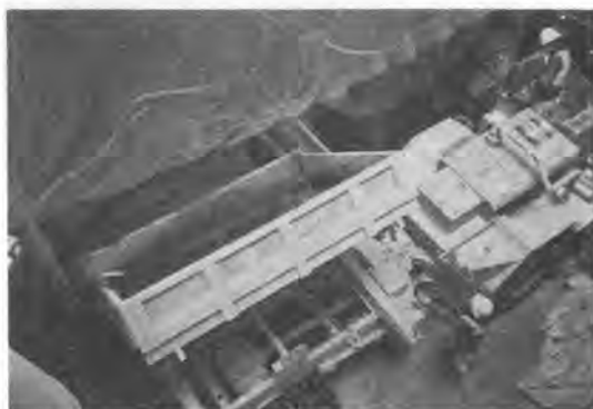
写真-3 作業坑底部でのずり排出状況
