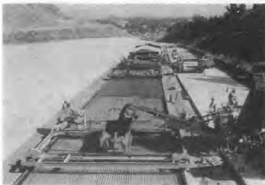
写真-3 舗設全景
