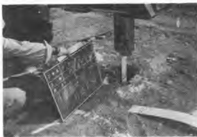
写真-2 アンカレス・マンドレルによる打設状況
