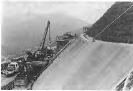
写真-3 アンカー工法
