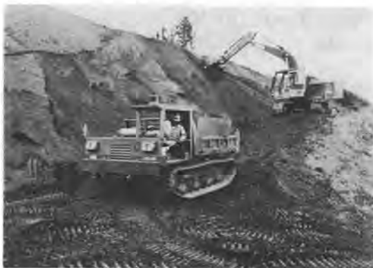
写真-1 切土掘削
