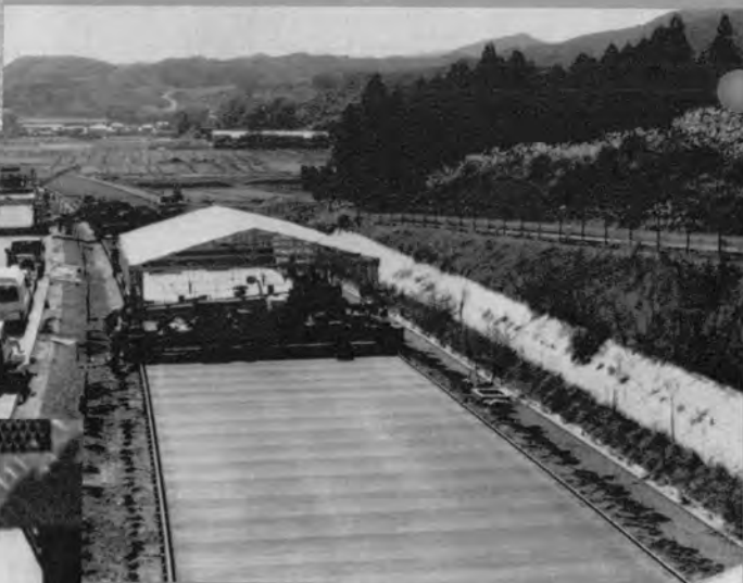
⇨舗装完了状況
