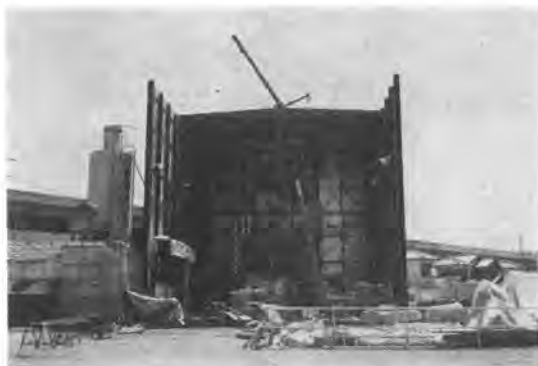
写真-1 作業立坑仮設備
