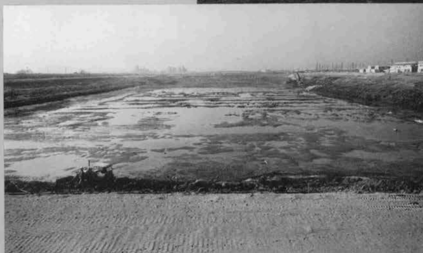
◆ドライドック 大排水完了後
