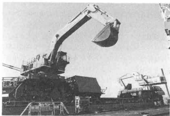
写真-2 揚土装置 (7 m 3 バックホウ)
