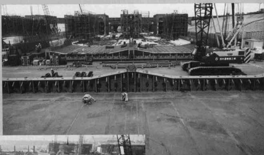
⇨ 底盤部防水鋼板組立て
