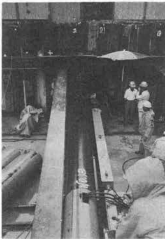
写真-2 鋼管推進, 発進立坑
