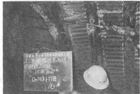
写真-8 斜め先打ボルト工
