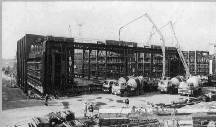
⇨ 壁支保工 コンクリート打設
