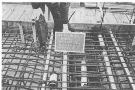
写真-10 主桁理設計器
