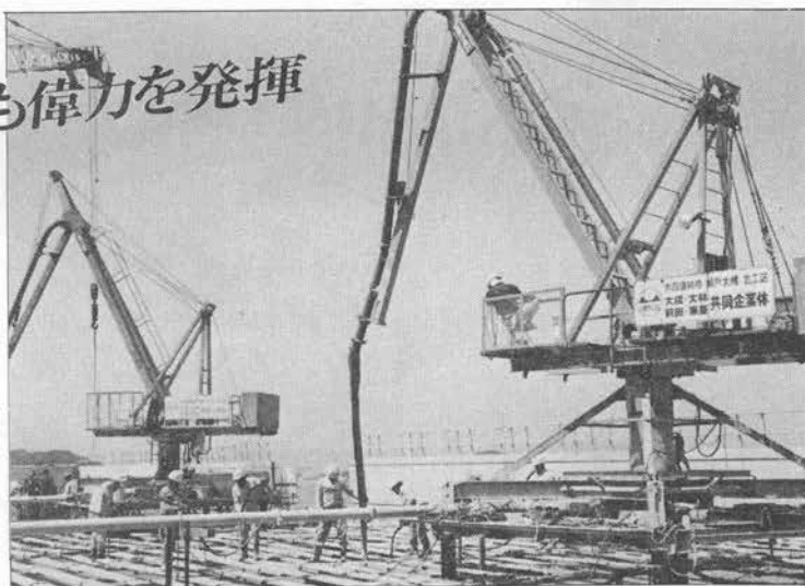
(本四架橋現場設置例)
