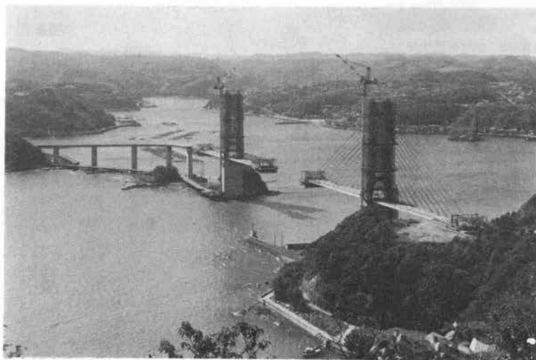
写真-11 施工中全景 (S. 62.10)
