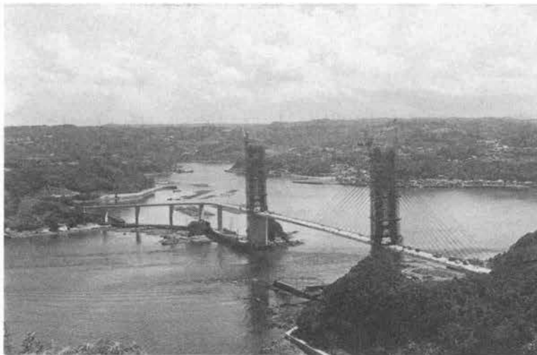
写真-12 最新施工状況 (63.7)
