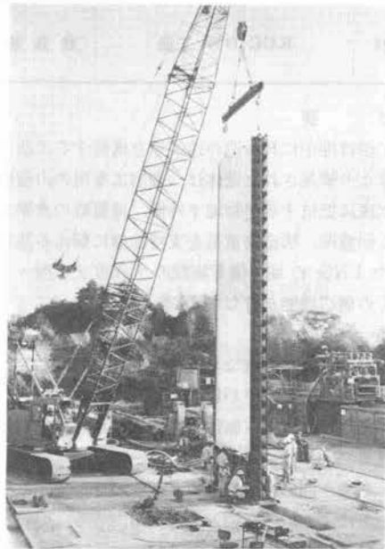
写真-1 鉄筋かご建込状況
