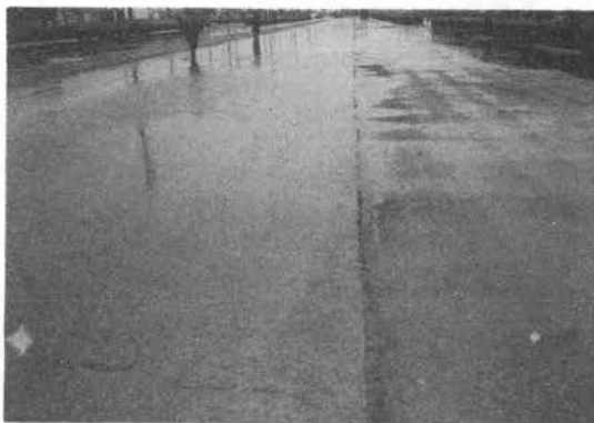
写真-1 米国ワシントン州タコマ港インターモダルヤードにて(左:超締固めフィニッシャ施工,右:一般機施工)
