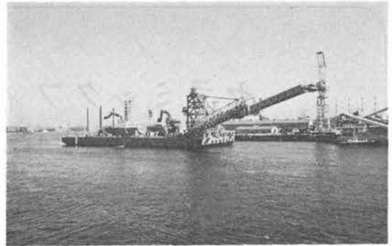
写真-3 No. 3 (ブーム), No. 4 (シャトル) コンベヤ
