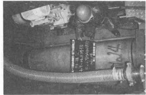
写真-4 ヒューム管セット状況
