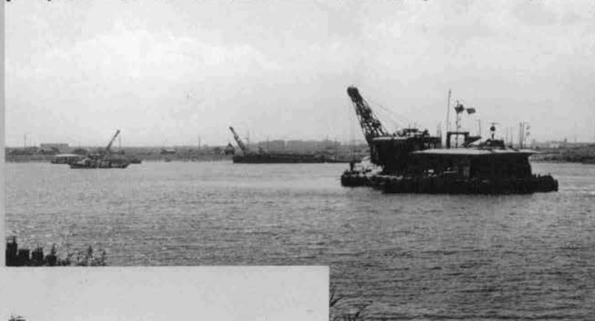
◆ドライドック浚渫 (グラブ浚渫船)
