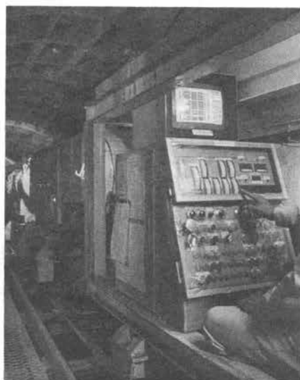
写真-2 マイコン掘進管理画面と運転状況 送運転を開始した。
