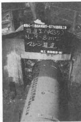
写真-3 初期発進状況
