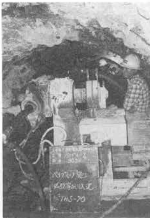
写真-6 パイプルーフ施工状況
