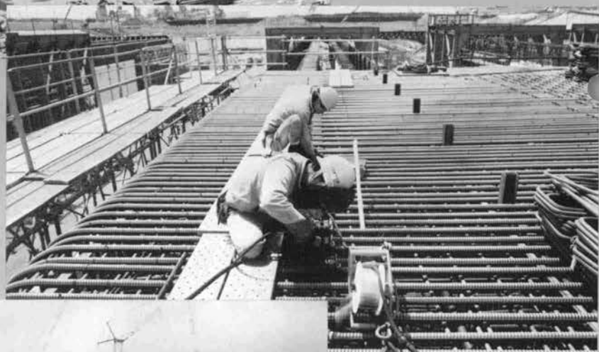
⇨ 上床盤鉄筋組立て (エンクローズ溶接)
