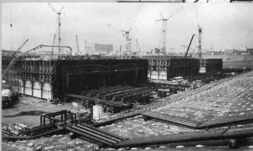
⇨ 上床盤用移動支保工, コンクリート打設
