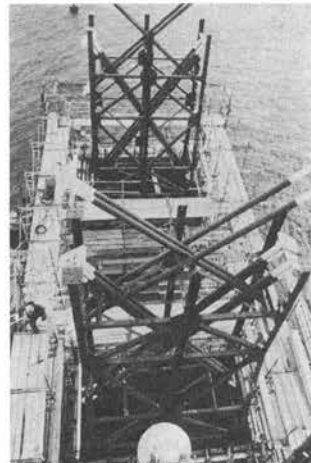
写真-7 主塔施工状況
