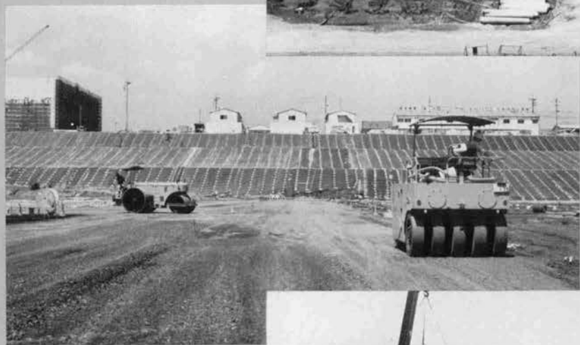
⇨ 作業ヤード路盤造成
