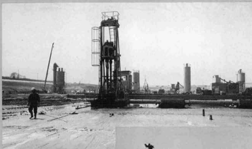
⇨ 渠底部地盤改良 (固化処理)
