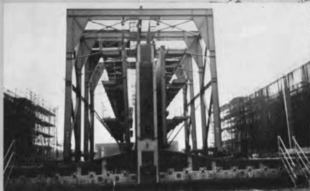
⇨ 壁用移動式型枠（中壁用）
