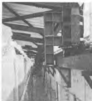
写真-9 桁柱部横振れ防止ガイド
