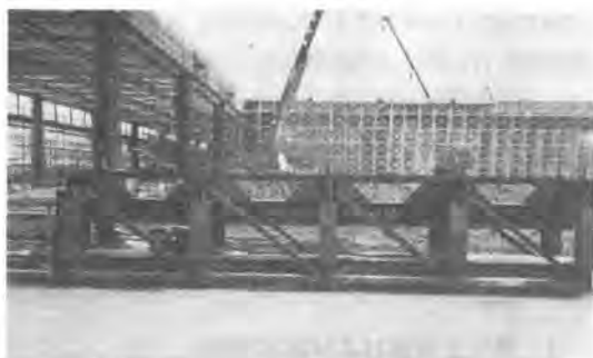
写真-8 横引き試験施工全景
