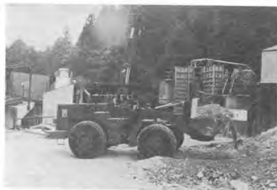
写真-2 大型ホイール式油圧ショベル
