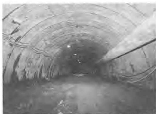
写真-2 1次覆工の仕上り状況
