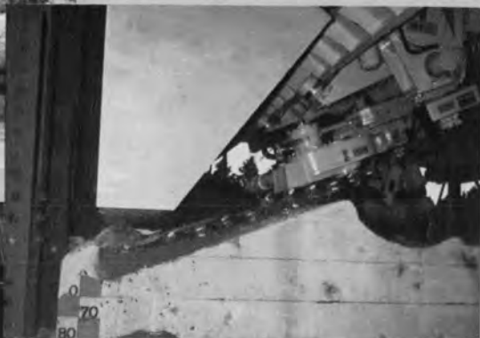
⇨ジブカッタ掘削状況
