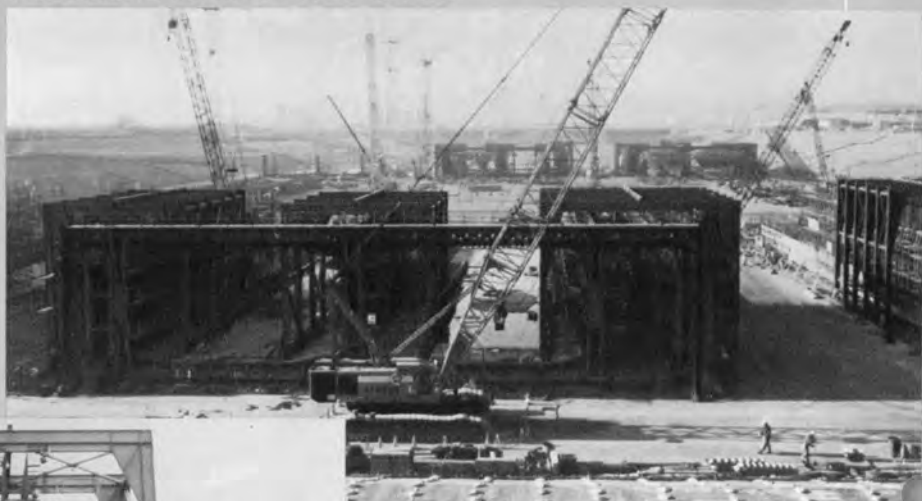
⇨ 壁用移動式型枠（全景）
