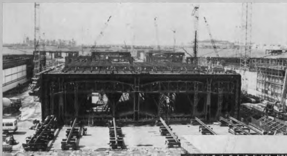
⇨ 上床用移動式型枠支保工
