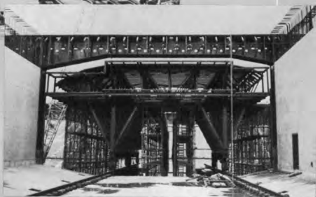
⇨ 上床用移動式型枠支保工
