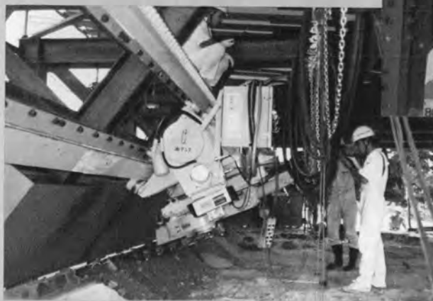
⇨模擬ケーソンに装着された ジブカッタ
