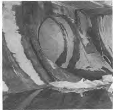
写真—4 地中接合完了状況
