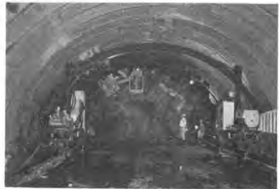
写真-1 施工機械の外観
