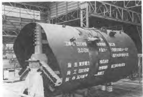
写真-2 スライドフード押出し後
