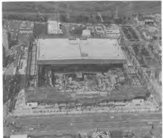
写真-1 トラベリング工事全景
