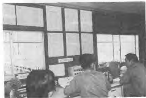
写真-7 指令室内部
