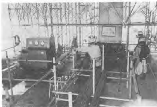
写真-4 中央柱部ジャッキシステム（端部盛替後）
